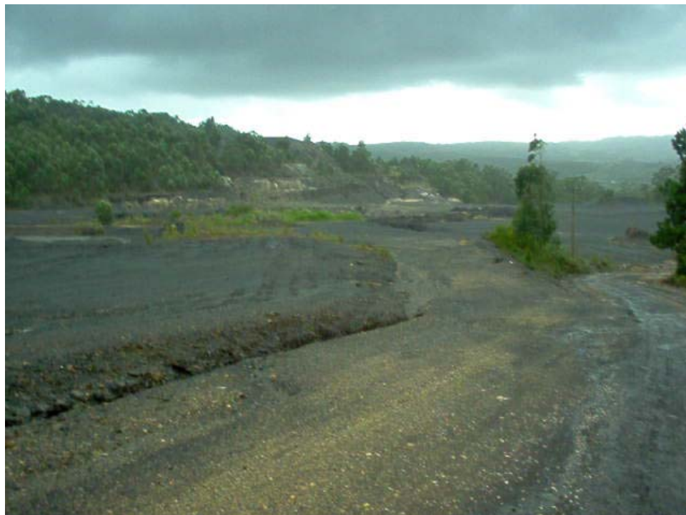
Figura nº 35- Coordenada 6848020N/0661538E cota 165 - Mineração a céu aberto abandonada com disposição de rejeito carbonoso, (Coqueria Rio Deserto).
