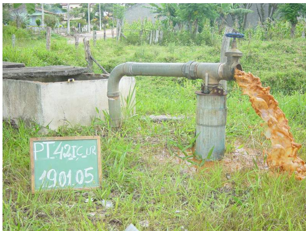
Figura nº48- Poço não instalado no município de Içara, coordenada 666.682E/6.823.373N. Observa-se inadequação de tamponamento e perímetro de proteção.
