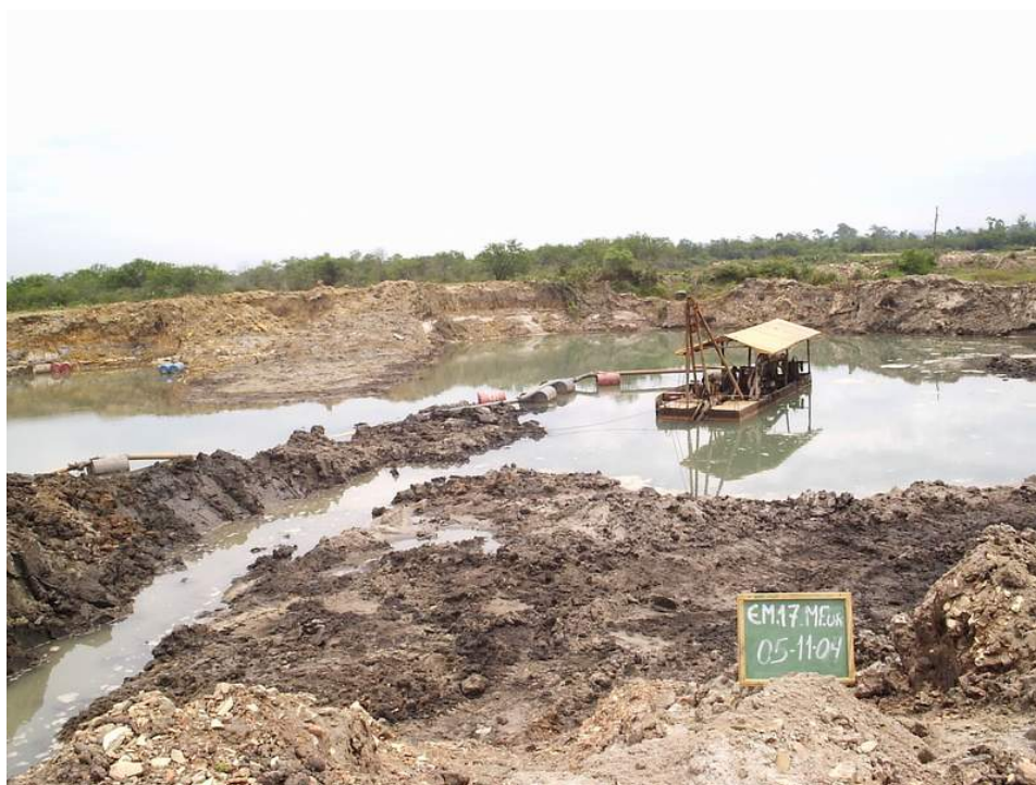
Figura nº 46 – Coordenada 678190E/6829190N, Extração de areia no município de Morro da Fumaça
