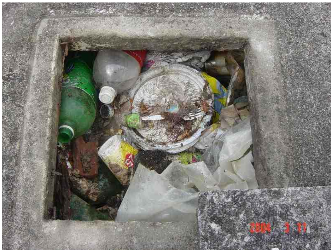
Figura nº 56 - Município de Cocal do Sul. Uso diverso de poço escavado.
