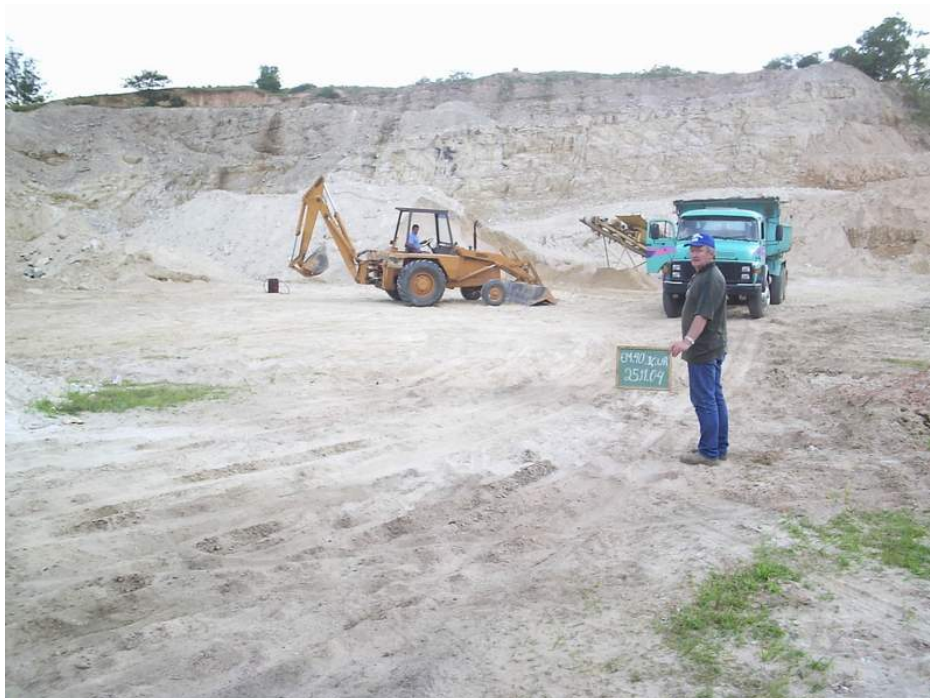
Figura nº 40- Coordenada 676.131E/6.822.309 N, Extração de argila na localidade de Rio Acima, município de Içara
