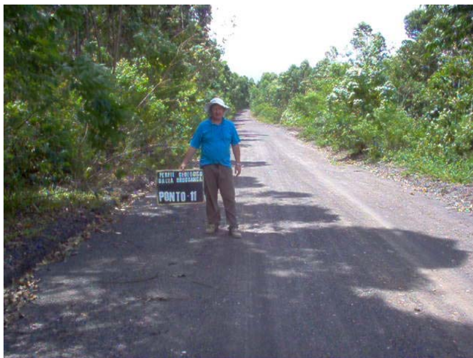
Figura nº 31 - Coordenada 6849971N/0661318E cota 345m – Estrada Rio Carvão de Baixo, em área minerada. Leito da estrada sobre rejeito carbonoso.
