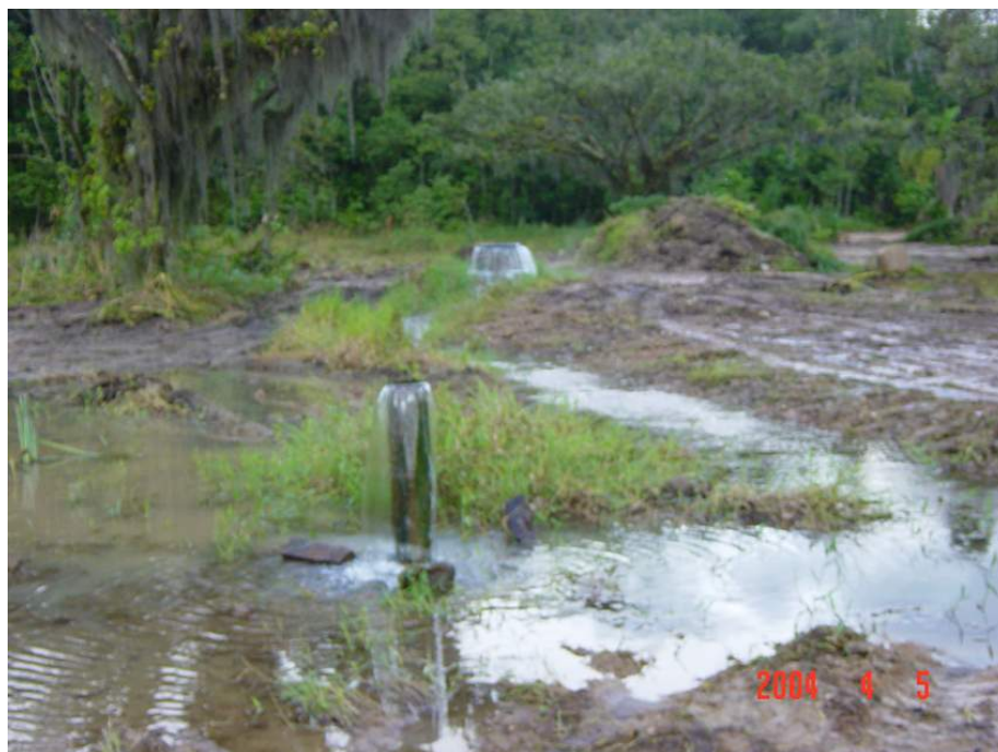
Figura nº 05 -.Poço de ventilação de mina de fluorita abandonado, com água termal. Município de Pedras Grandes.
