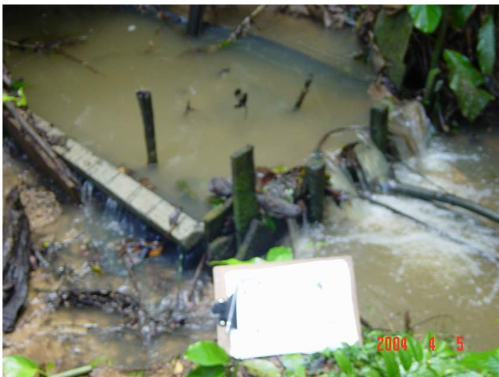
Figura nº 57 - FT 25 PG-UR Coordenada 670.614E/6.841.672N, fonte cadastrada no município de Pedras Grandes.
