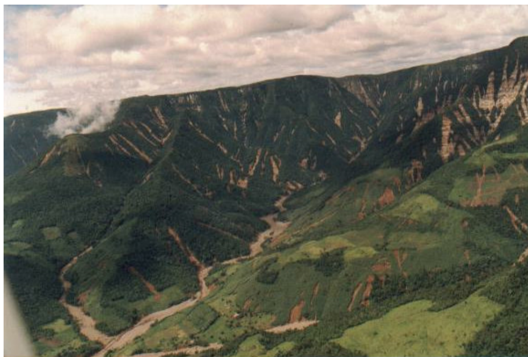
Figura 31: Movimentos de massas na encosta superior da escarpa, evoluindo para mud flow e debris flow , onde o fluxo era canalizado. Local: Vale do rio Figueira, município de Timbé do Sul. Foto cedida por Joel Pélérin.
