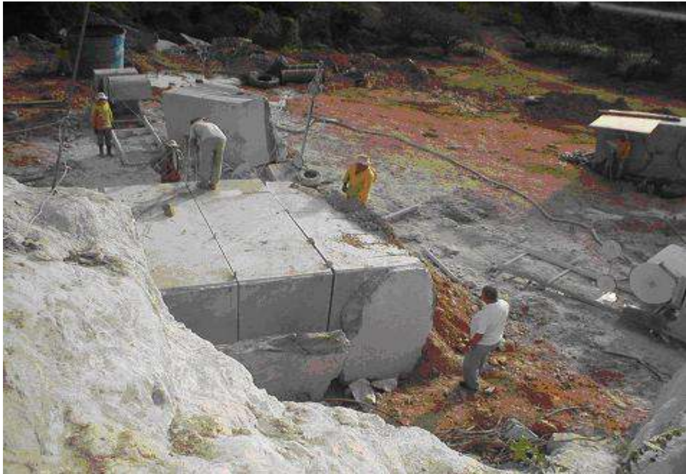
Foto 2.16 - Frente de lavra, em maciço, do Granito Red Brown. Fonte; Araújo et al. (2007).
