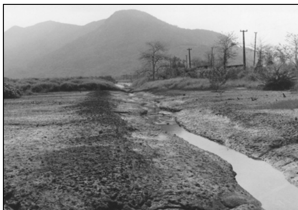
Foto 2.2 – Canal de drenagem do Rio Piaçaguera
