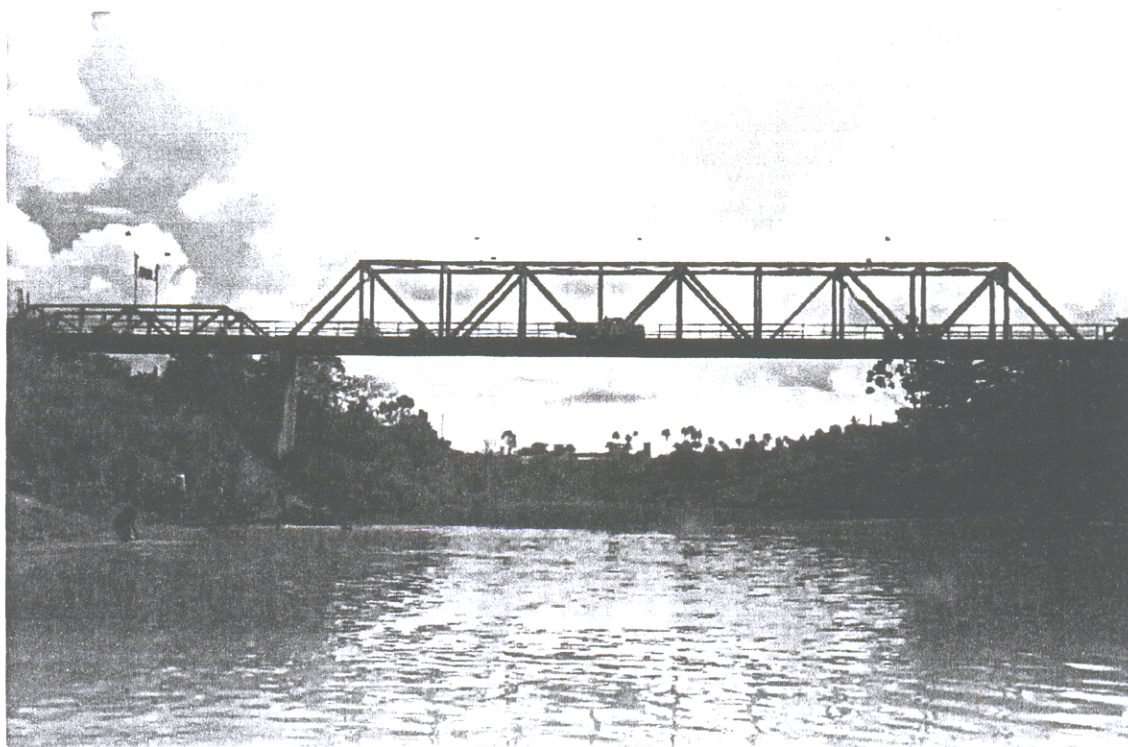
Figura 17- Trecho do rio Acre, sob a ponte que interconecta a cidade de Brasília, AC (Foto: Rômulo Angélica).
