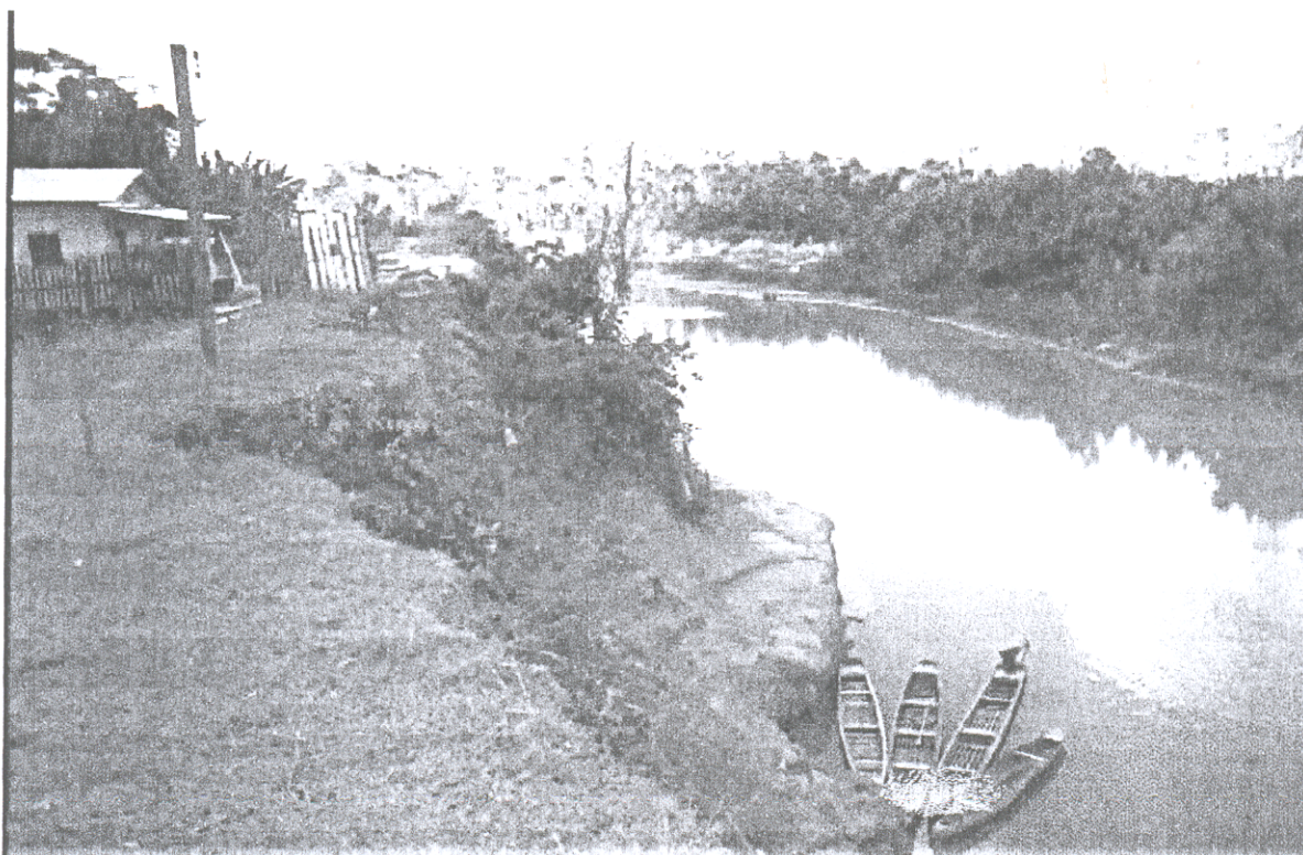
Figura 9- Barranco às margens do rio Acre, Assis Brasil- AC. (Foto: Rômulo Angélica).
