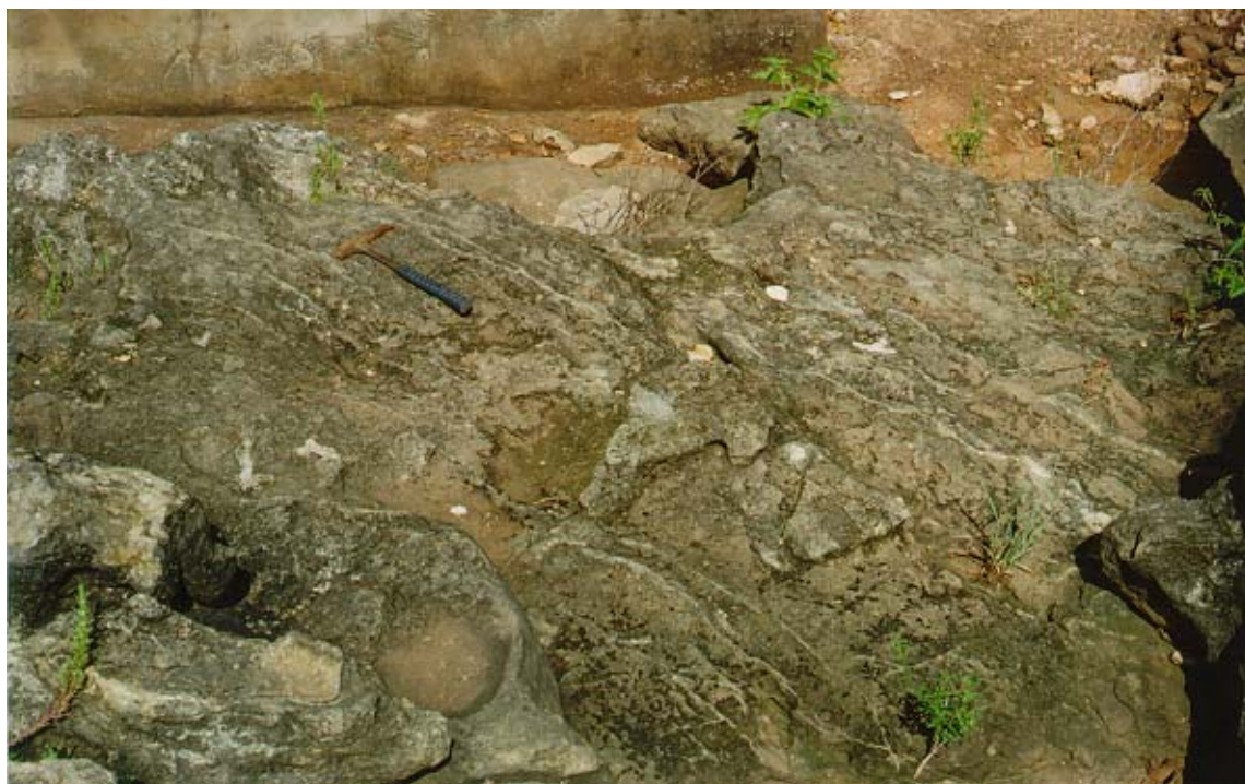
Foto 4.5. Detalhe do afloramento do pontilhão da via férrea Macau-Afonso Bezerra (RN). Paralelo à direção indicada pelo martelo (aproximadamente N-S), encontram-se fraturas de extensão preenchidas por carbonato (ver esquema na Figura 4.11) (Folha SB.24-X-D-II, UTM: 773,620kmE e 9.417,693kmN).
