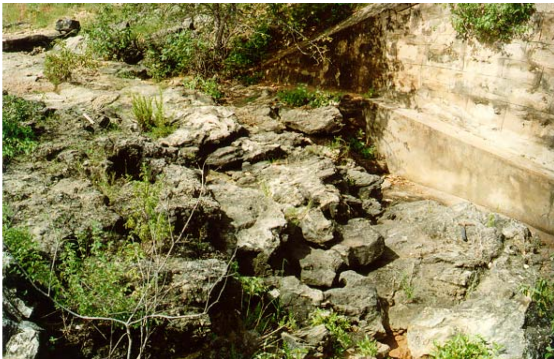
Foto 4.4. Visão geral do Afloramento sob o pontilhão da linha férrea de Afonso Bezerra. Juntas extensionais de direção N-S são encontradas no canto direito inferior da foto, enquanto dobras E-W podem ser observadas na porção central, sobre o calcário Jandaíra (ver esquema na Figura 4.11) (Folha SB.24-X-D-II, UTM: 773,620kmE e 9.417,693kmN).
