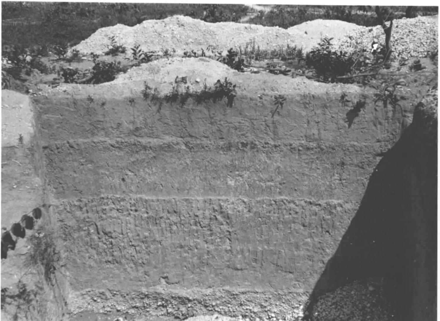
FOTO 19 - Cata - Poço retangular onde é removido o capeamento areno-argiloso, com a finalidade de encontrar-se a camada de cascalho diamantífero em baixo. Tais poços têm profundidade variável, dependendo do nível de cascalho a ser trabalhado.
