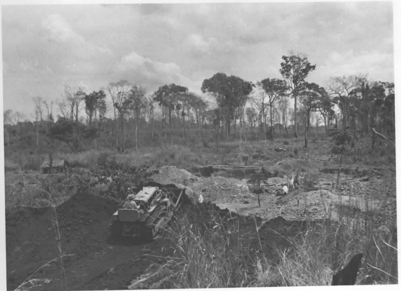
FOTO 18 - Remoção de estéril por meio de trator de lâmina.
