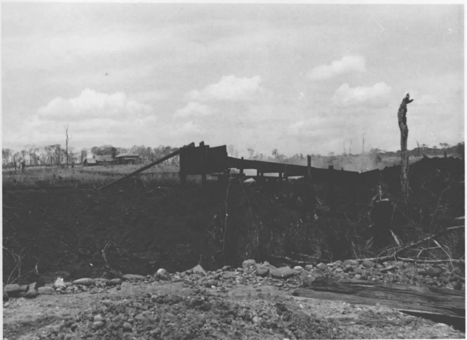
FOTO 15 - Caixa e calha ou rampa usadas na apuração dos diamantes, quando explorados por meio de Dragas.
