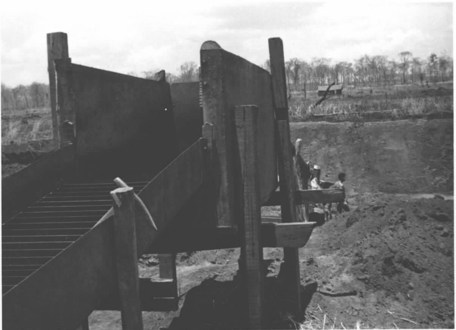
FOTO 16 - Detalhe da caixa e rampa de ferro usadas na apuração dos diamantes em exploração por dragas.
