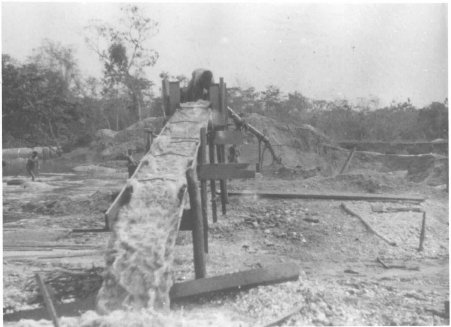
FOTO 17 - Caixa e calha de madeira, usadas na apuração de diamantes por meio de draga. Notem-se as ripas transversais à calha, com grande espaçamento.
