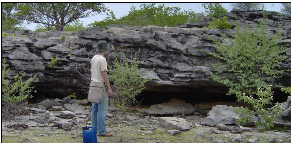
FIGURA 7.23 – Abrigo com desenvolvimento horizontal significativo, altura da ordem de 1 m. A presença de morcegos indica potencial espeleológico (Coord. UTM-WGS 84: 653.6363 / 9.388.732, P57).
