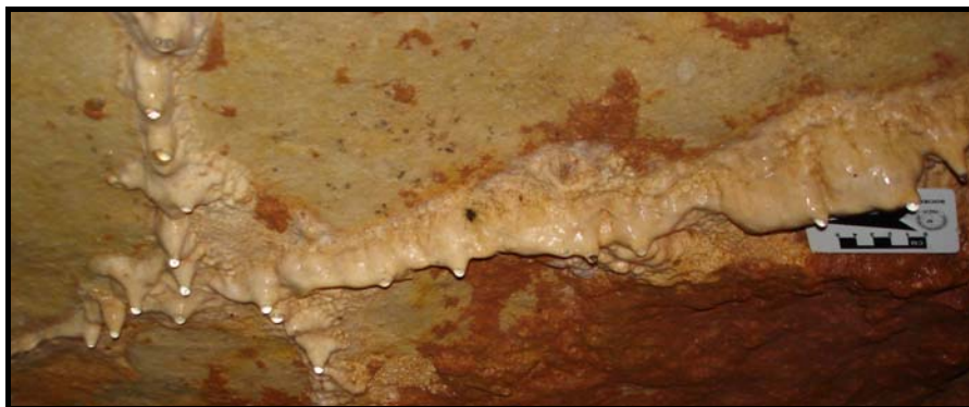
FIGURA 8.11 – Estalactites em processo de formação por gotejamento em fendas no teto.
