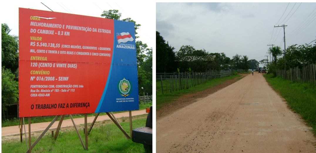
Figuras 56 e 57 – Placa de recuperação da vicinal do Cambixe do novo contrato e trecho que foi pavimentado no primeiro contrato.
