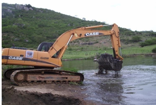
Figura 54 - Limpeza no açude com o auxílio de dragas, para a remoção do lodo no fundo. Fonte: Autor.
