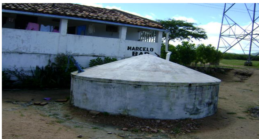
Figura 22 - Cisterna com dispositivo para retirada de água sem contato direto com o reservatório.
