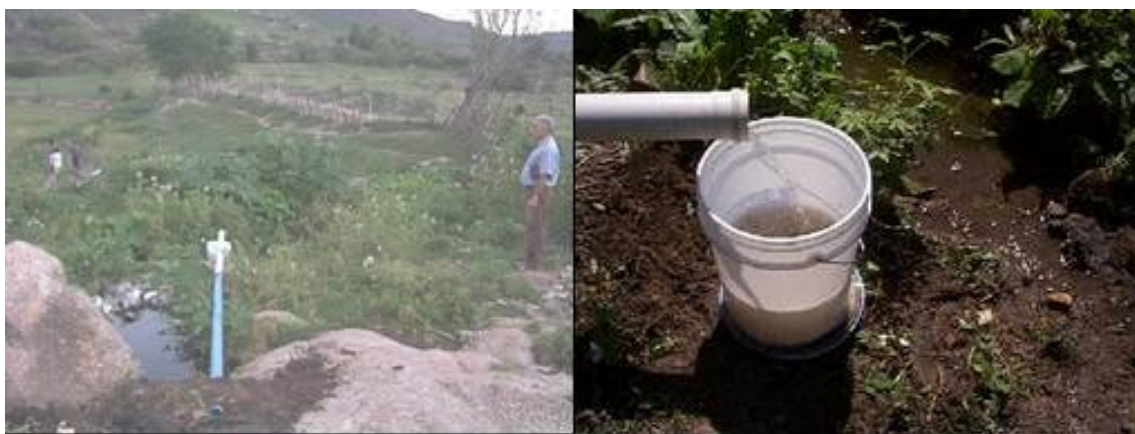
Figura 49 – Características da situação do esgoto existente e medição de vazão de esgoto. Fonte: Autor.
