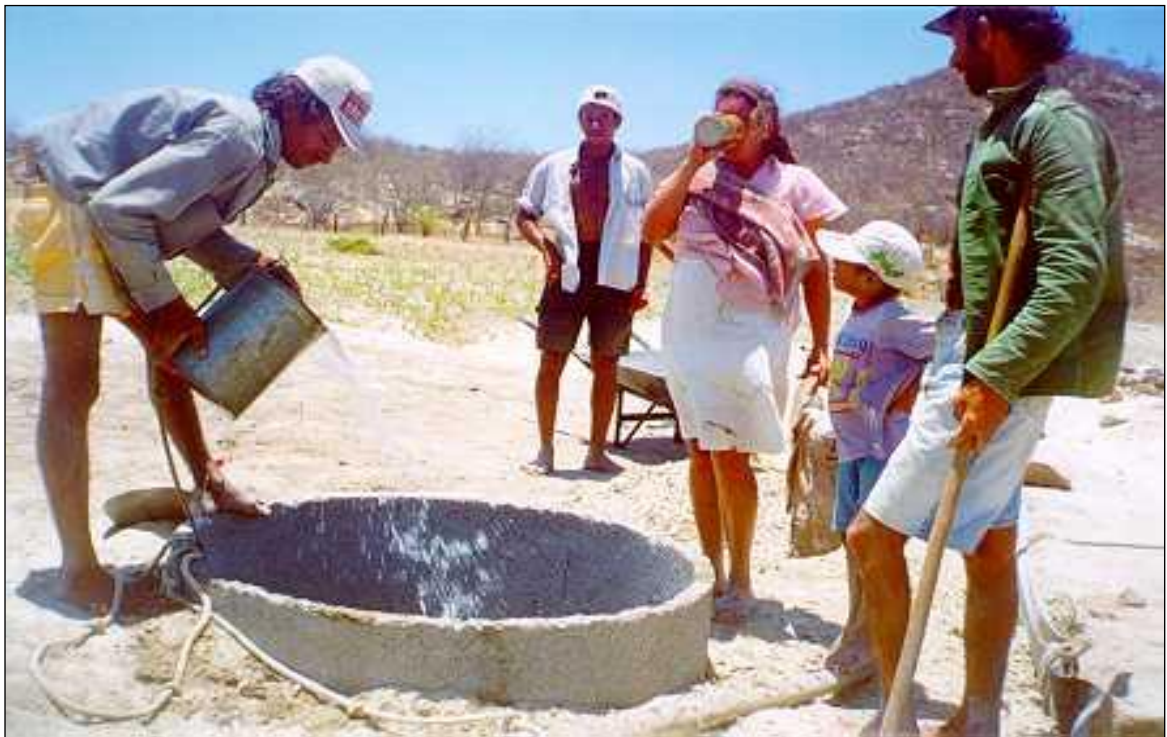
Figura 15 - Água captada em depósito aluvional com barragem subterrânea, utilizada para o abastecimento humano – Distrito de Mutuca – Pesqueira/PE.
