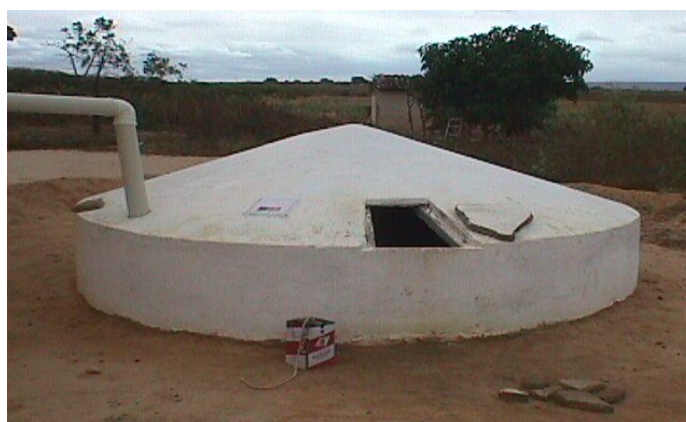
Figura 9 - Cisterna para captação da água do telhado. Foto: Autor.
