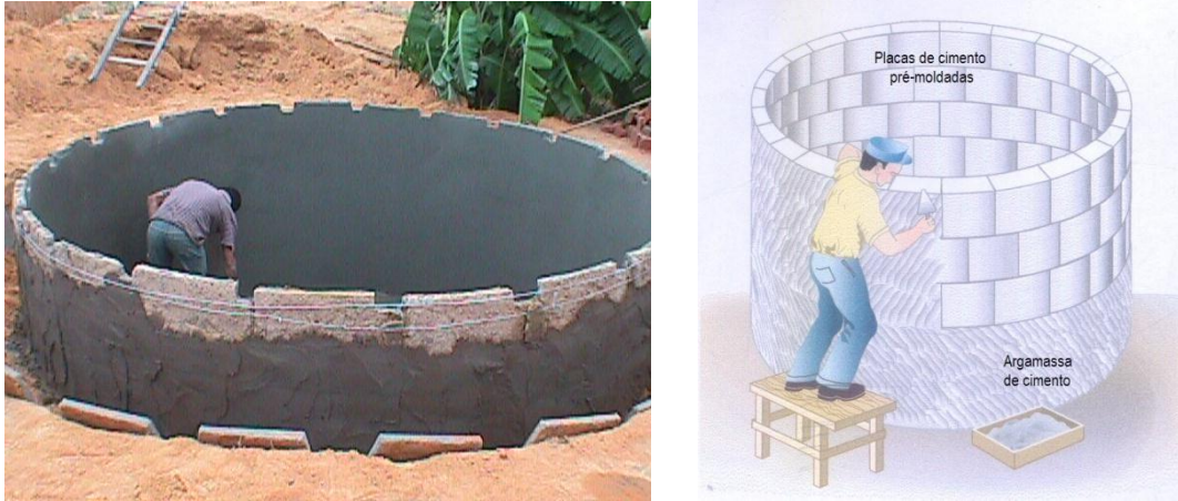
Figura 10 - Cisternas de placas de cimento (armação e reboco das paredes). Fonte: BERNAT et al. (1993).
