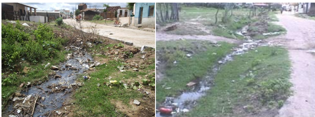
Figura 46 – Esgoto a céu aberto contaminando o manancial. Fonte: Autor.
