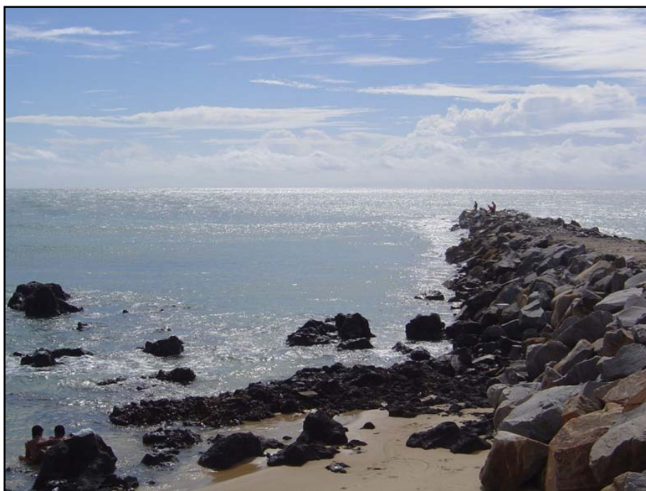
Figura 3.10. Barreira artificial construída com intuito de diminuir o efeito da erosão costeira, Praia de Areia Preta, Natal/RN (Foto: I. Cabral Neto).
