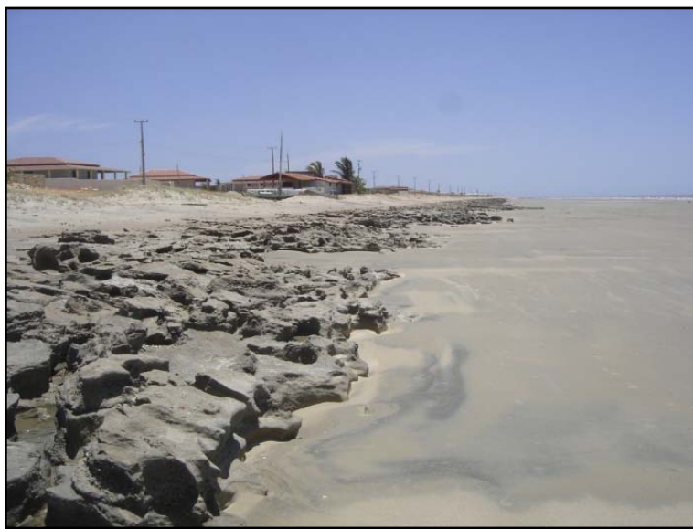
Figura 4.10. Afloramento de beachrock da Praia de Baixa Grande, Areia Branca/RN. A morfologia e disposição em zona superior de pós-praia deste beachrock favorecem a proteção natural à zona costeira.
