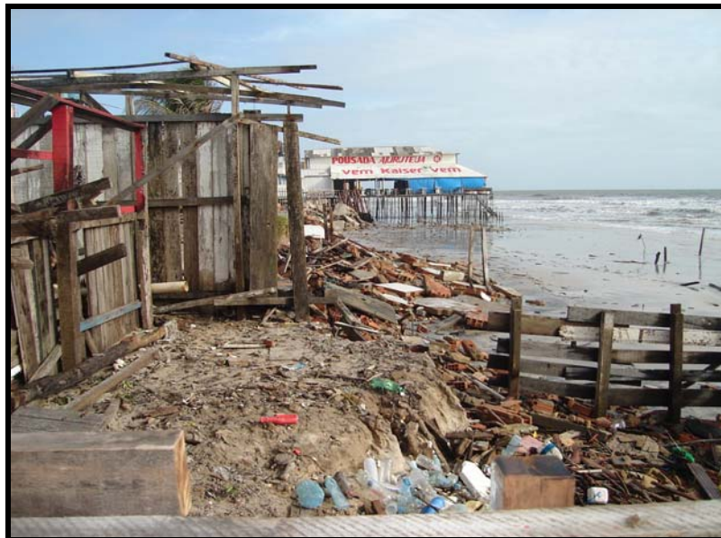
Figura 2.4: Destruição de barracas na praia de Ajuruteua durante a maré alta de sizígia ocorrida em março de 2006.
