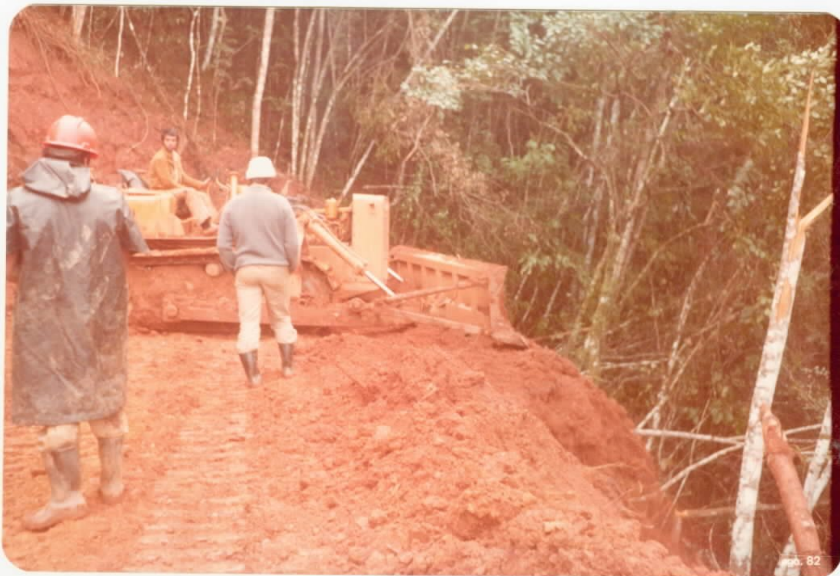
Abertura de acesso com trator. Os trajetos das estradas eram planejados geralmente perpendiculares às estruturas, subsidiando os dados geológicos e verificando zonas geoquimicamente anômalas. Quando havia es pes sa cobertura de solos, o trator executava os trabalhos de trincheiras e/ou de ca pa gens.
