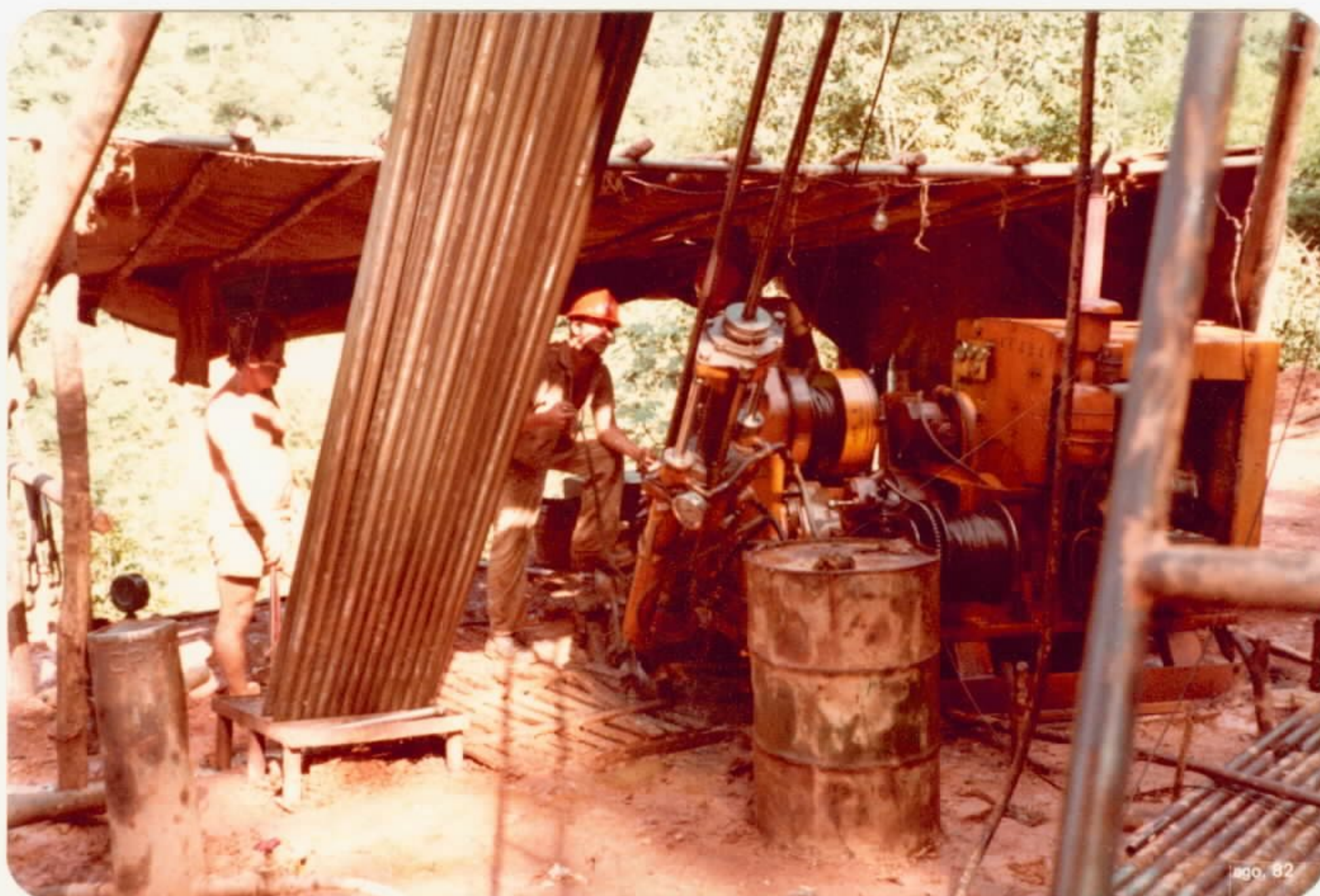
Aspectos dos trabalhos de sondagem rotativa, notando-se a inclinação de 45° do furo. A sonda é uma BBS 34, com capacidade de perfuração de até 400m.
