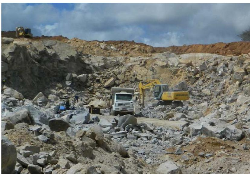
**Figura 59 – Escavadeiras trabalhando sobre a pilha de rocha desmontada, município de Macaíba (localidade de Jundiáí, Pedreira Potiguar).**
