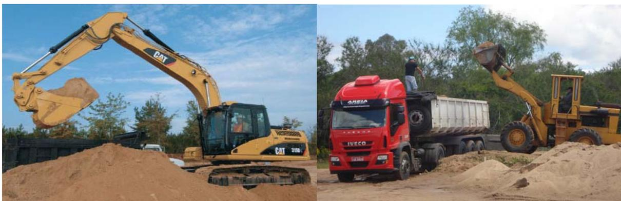
**Figura 36 – Desmonte mecânico por escavadeiras ou tratores / pás-carregadeiras.**
