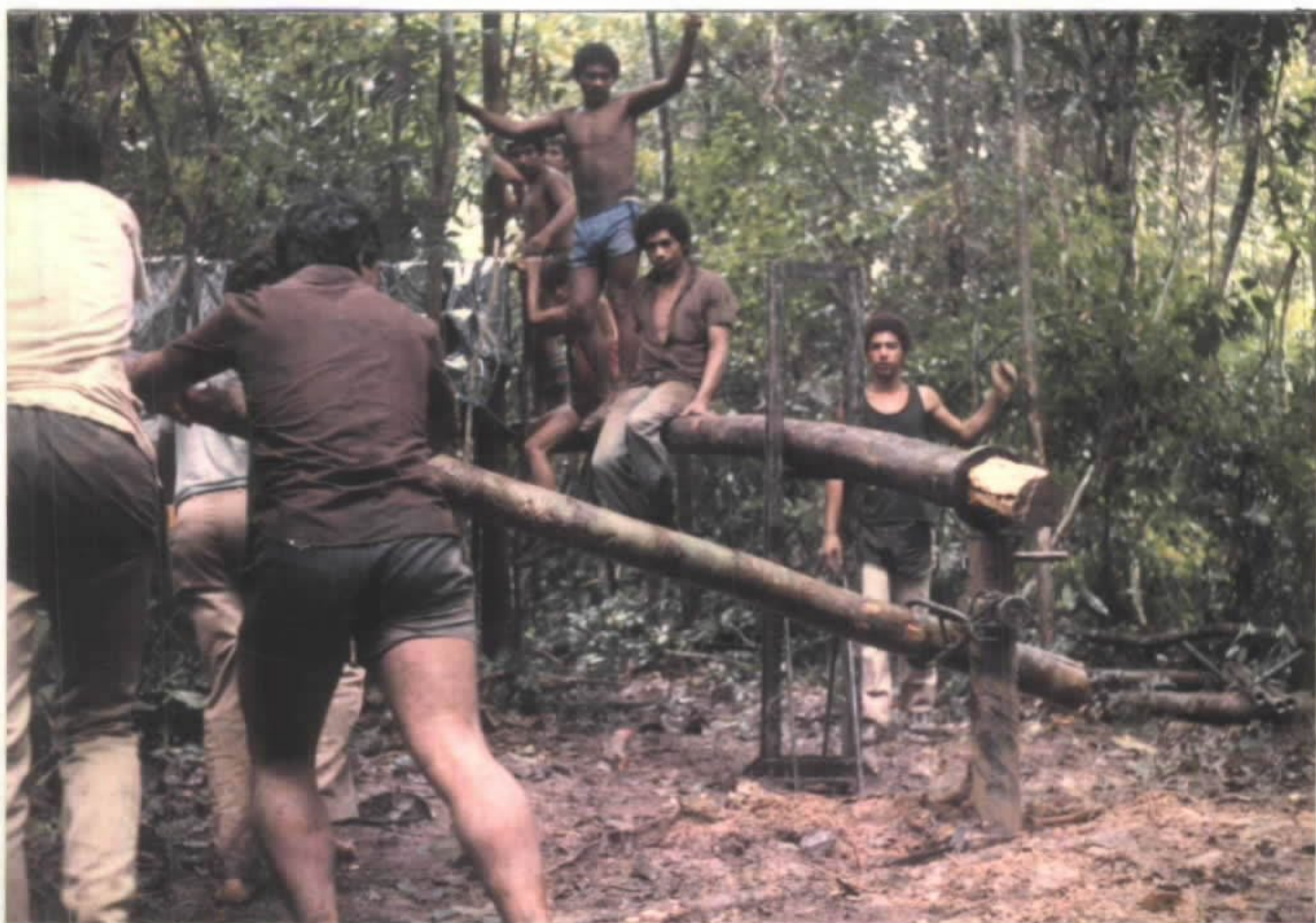
SACANDO REVESTIMENTO - CAMPANHA DE SONDAGEM BANKA
