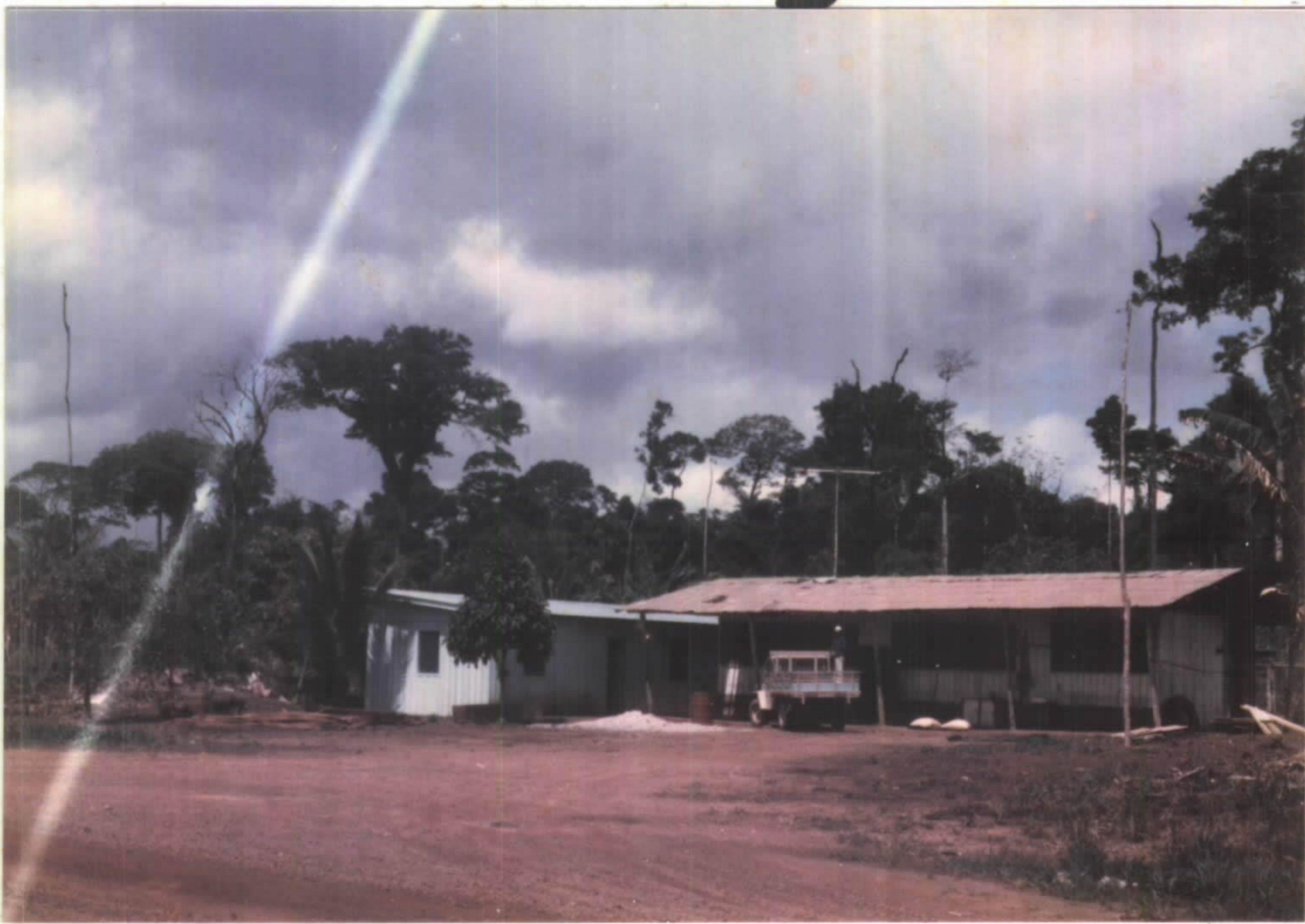
VISTA GERAL DA BASE DE APOIO DA MSMT LTD. EM RIOZINHO DAS ARRAIAS
