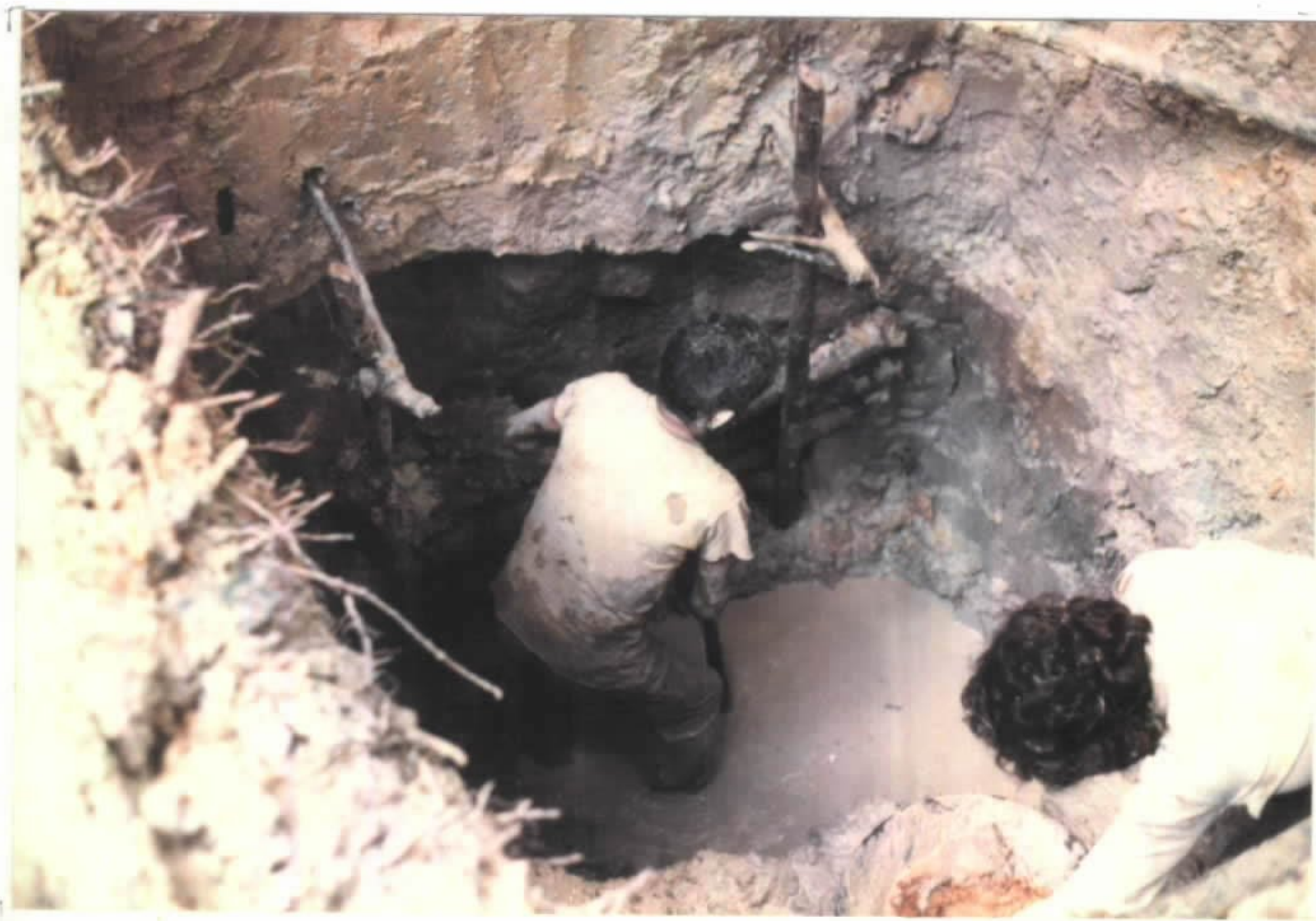
ESCAVAÇÃO DE POÇOS NOS ALUVIÕES DO BT-18.
