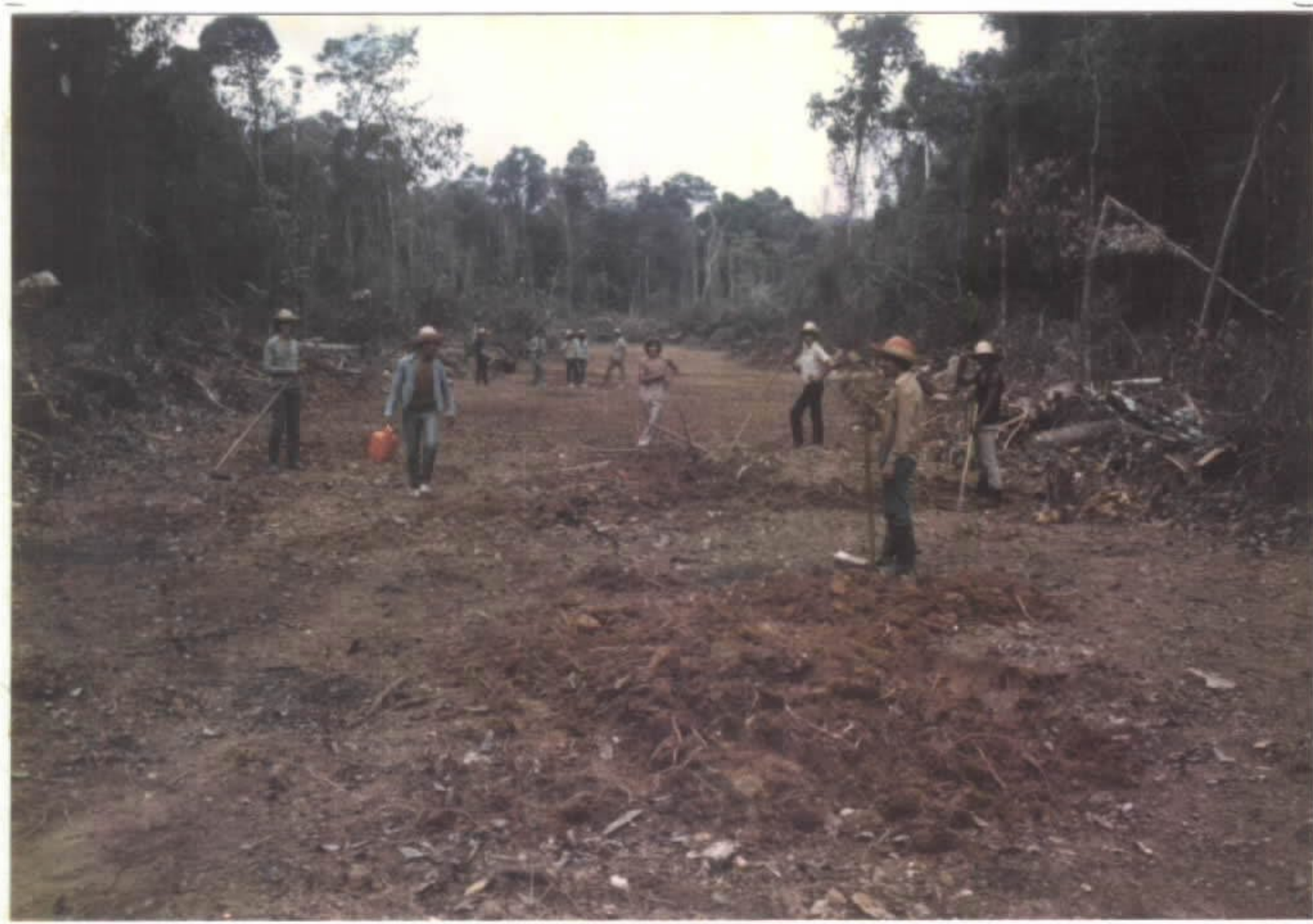
ABERTURA DO CAMPO DE POUSO - PISTA SÃO MIGUEL - NO BT-18.
