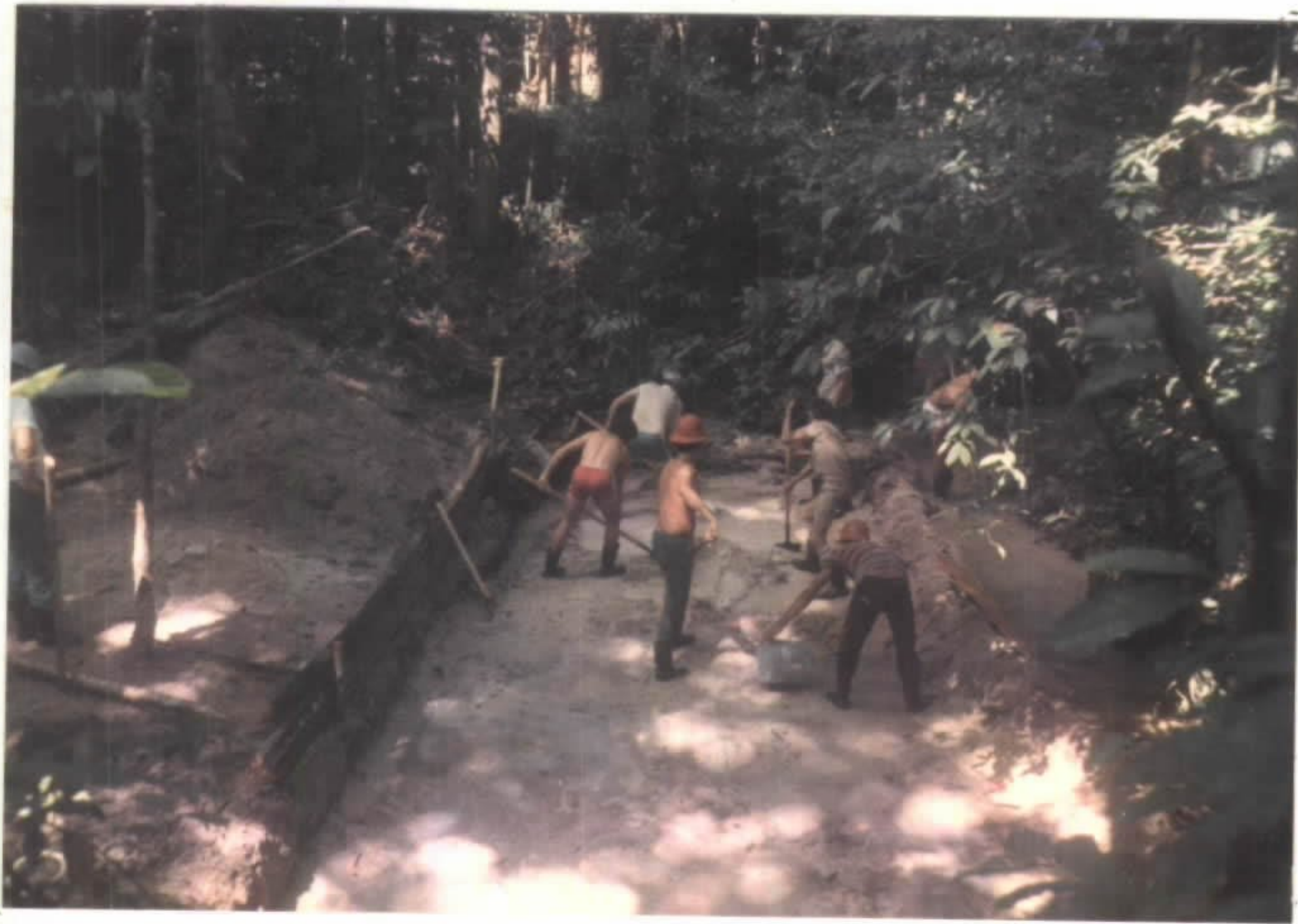
ABERTURA DE CATA NO IG. DO ESTALO.
