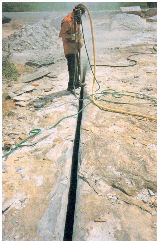
Fig. 9: Corte de rocha mediante uso do flame jet . (Fonte: Alencar, Caranassios e Carvalho, 1997)
