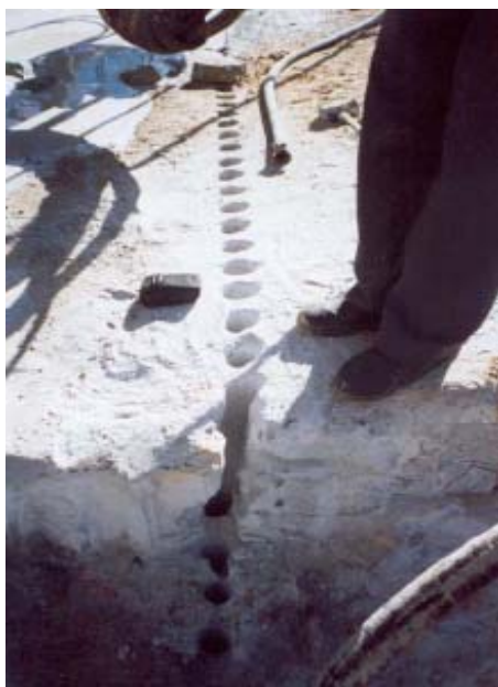
Fig. 17: Características de estágios de corte no plano horizontal através de perfuração contínua (Fonte: Pinheiro, 2003)
