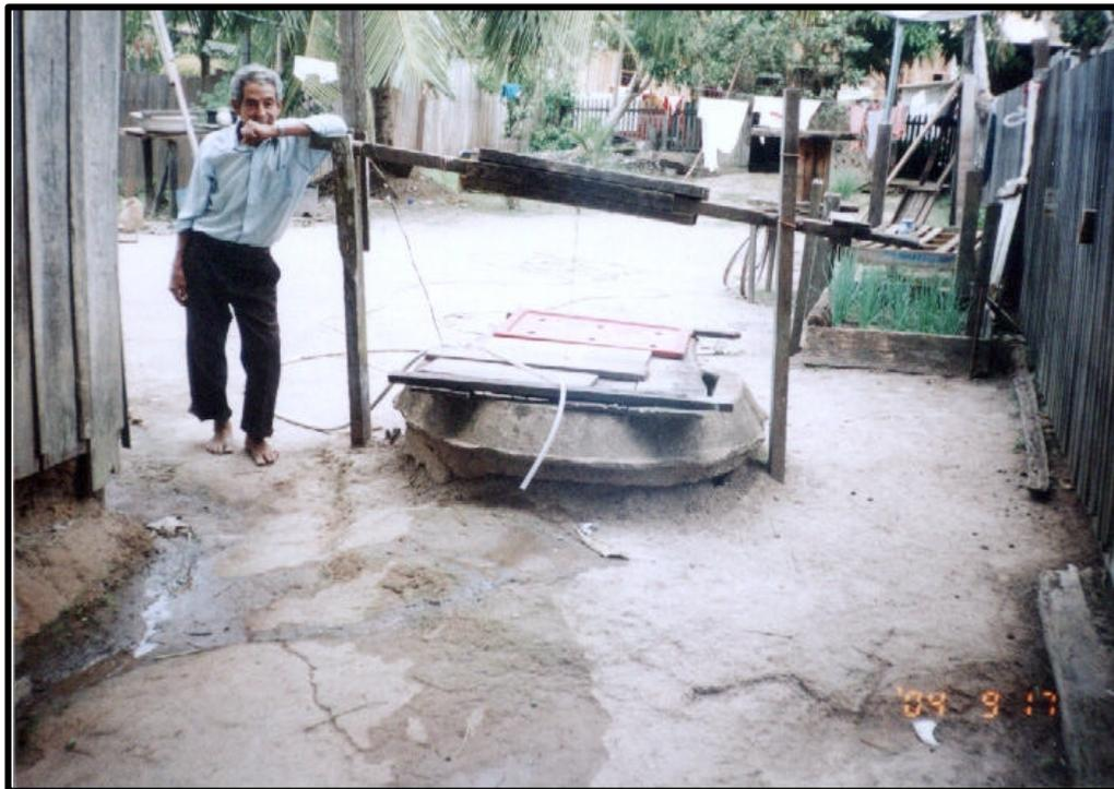
Figura 2 – Poço cacimba com precário sistema de bombeamento cadastrado na vila de Jaciparaná.
