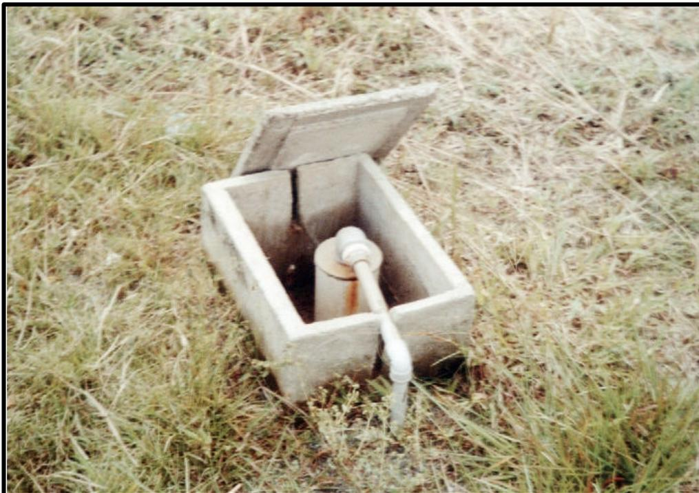
Figura 6 – Poço semi-artesiano responsável pelo abastecimento da Escola Bela Vista, localizado a cerca de 15 m de distância da fossa sanitária.
