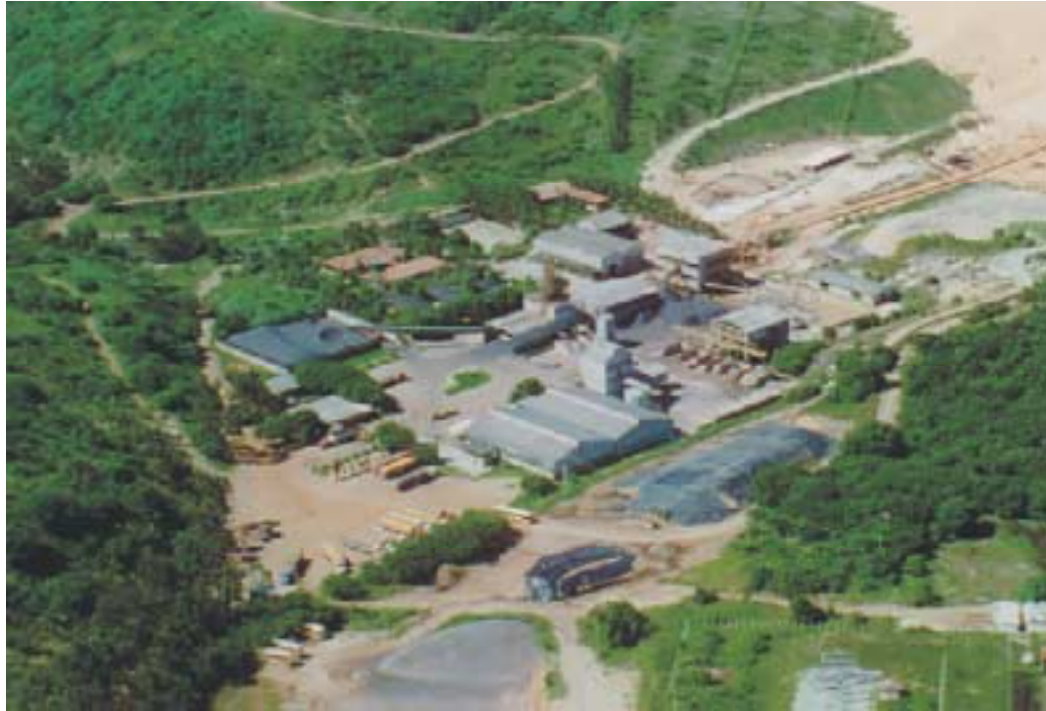
Foto 5.1 – Vista geral da área de beneficiamento de ilmenita na mina Guajú, em Mataraca. Foto gentilmente cedida pela Millennium Inorganic Chemicals.
