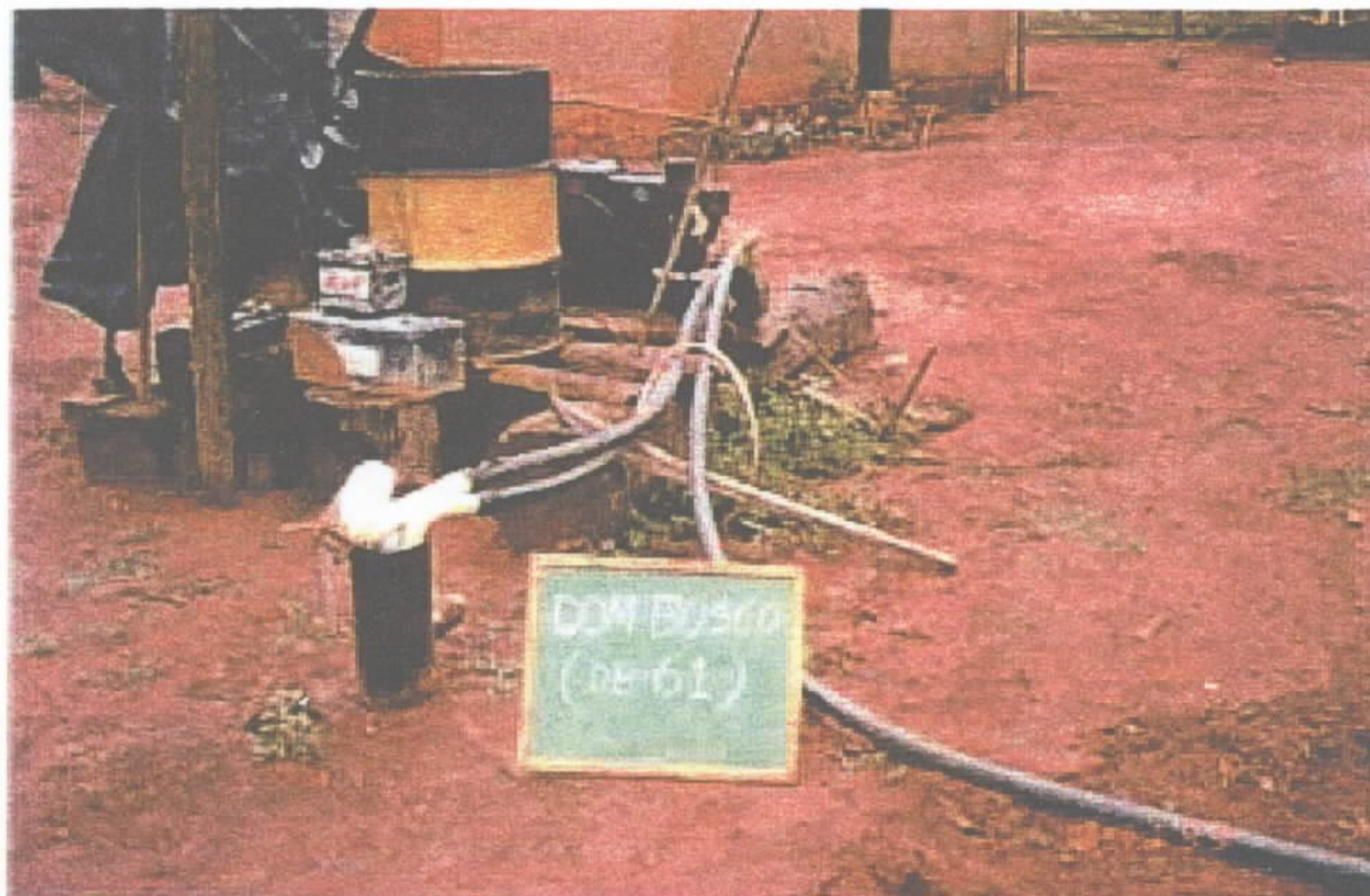
Foto 5 - Poço tubular com sérios problemas construtivos e operacionais. Poço não protegido, sem tampa e laje de proteção. Sistema de adução bastante precário. Município de Dom Bosco. UTM: 367028E/8148475N.
