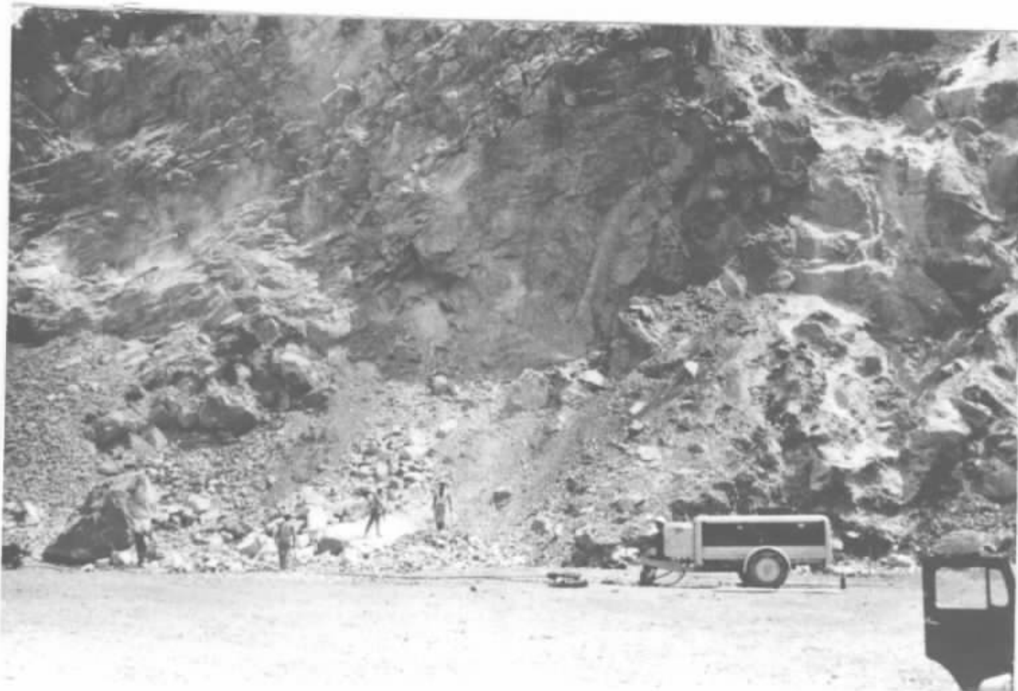
ASPECTO DA MINA DE CALCÃO RIO DA VOTORANTIN - Fo- lha de Itambé, no Km 8 da Estrada Bonsucesso - Itapeva.
