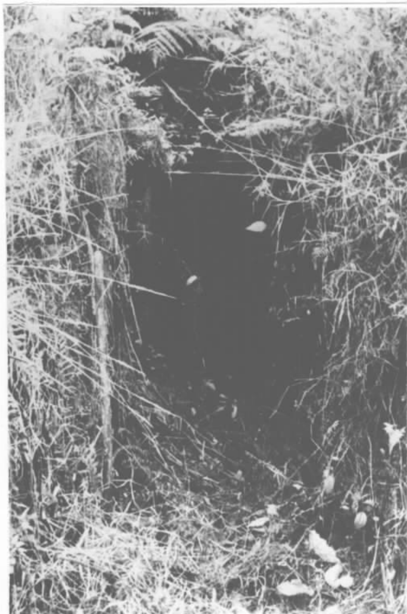
SÃO DOMINGOS I. Detalhe da entrada da galeria.
