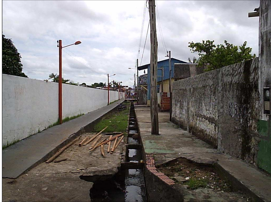
Figura 14: Vala de esgoto a céu-aberto correndo ao lado do muro do terreno onde estão situados os poços públicos da Estação Paraíba
