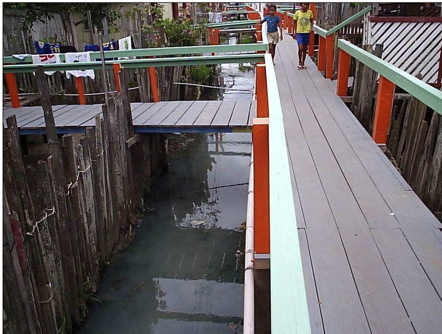
Figura 16: Detalhe do canal de esgoto sob as palafitas que ladeiam o terreno da Estação Paraíba.
