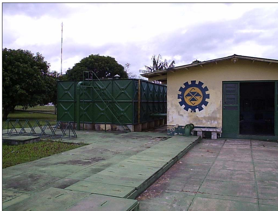
Figura 18: Reservatório de água da Estação SHAM, com capacidade para 90.000 litros e paredes de ferro.
