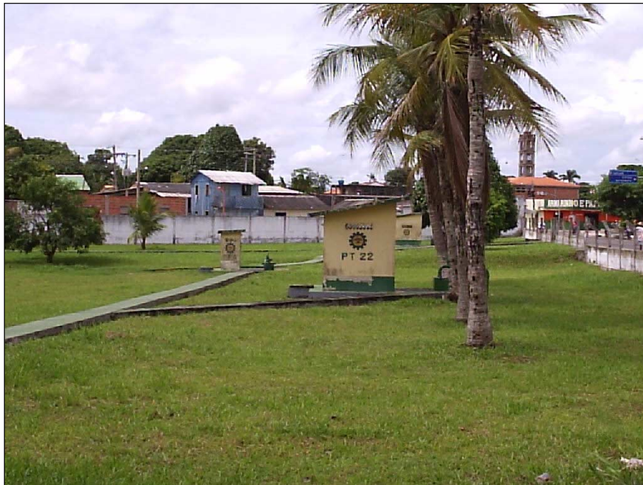
Figura 17: Poços no terreno rebaixado da Estação Paraíba, contaminados com nitrato e alumínio.
