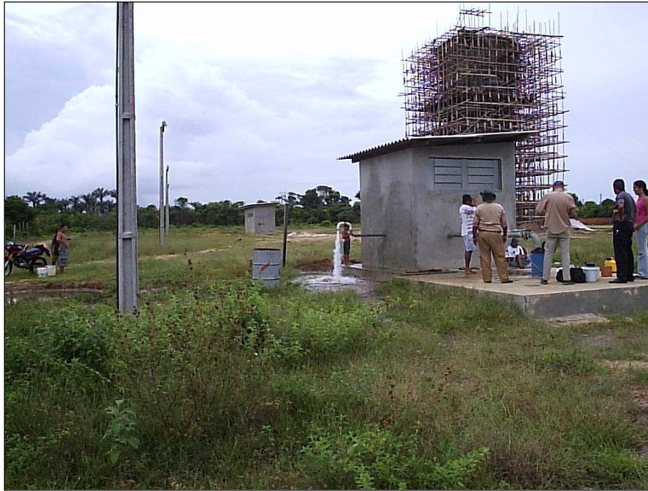
Figura 21: Poço PT-2 da Estação Itaúna, no momento da realização do teste de bombeamento. Este poço entrou em operação, integrando-se ao sistema público, logo após os trabalhos de campo deste projeto.
