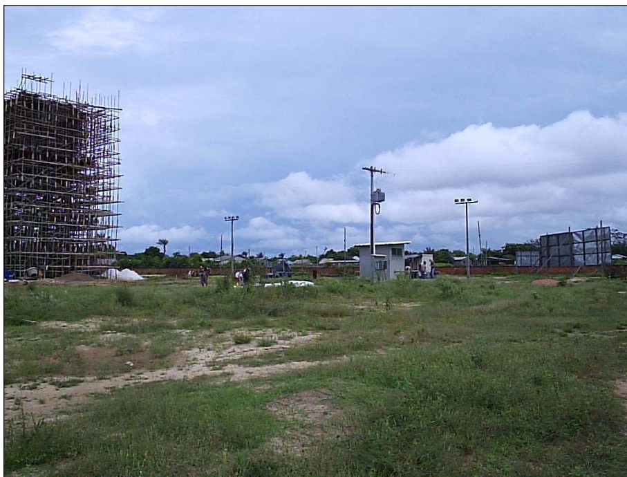
Figura 20: Área da Estação de Bombeamento Itaúna, com dois poços tubulares recém-perfurados e reservatório em fase de conclusão.
