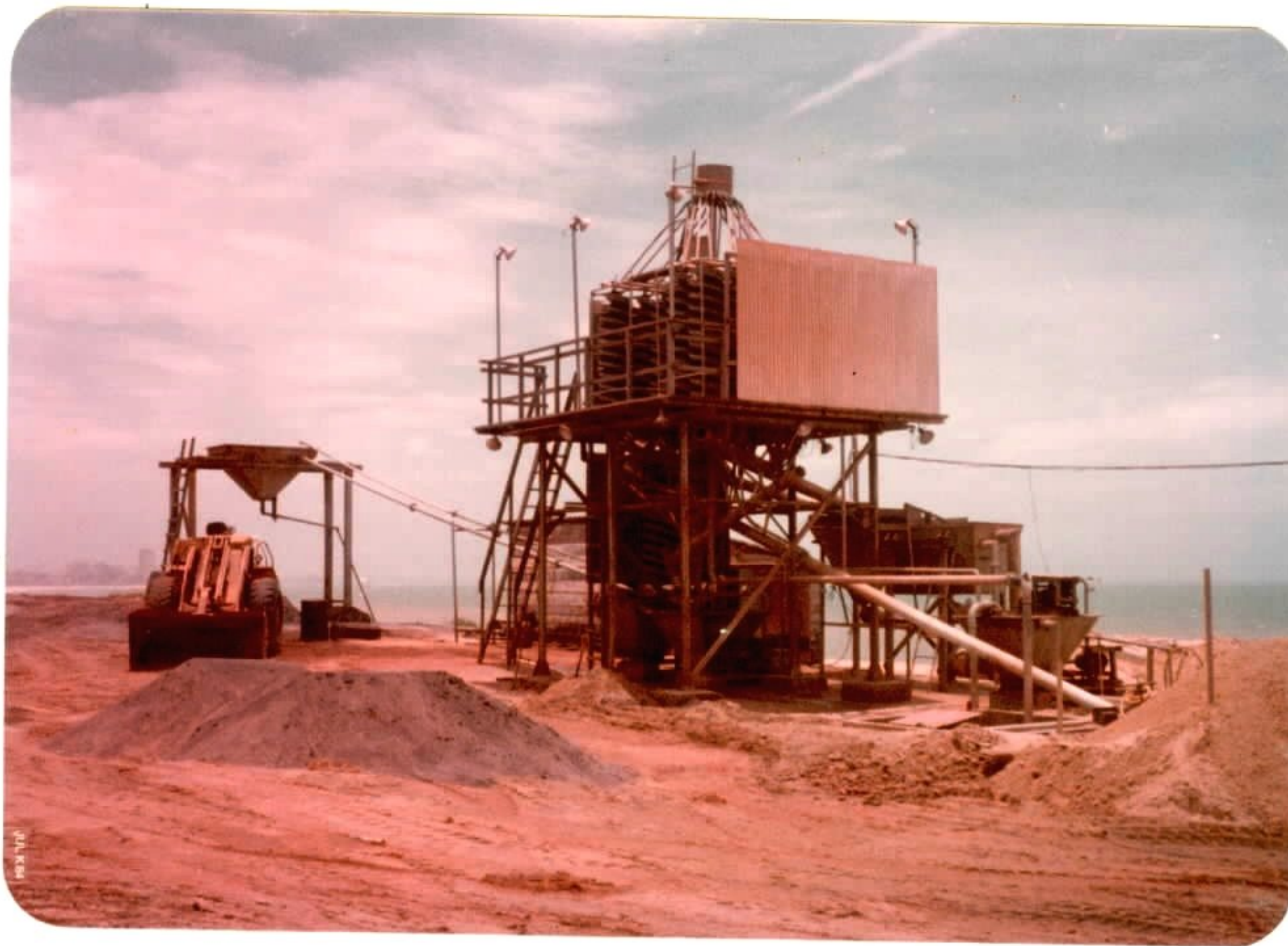
Foto nº 15 - Detalhe da foto anterior, destacando o separador helicoidal a água, utilizado na concentração de minerais pesados.
