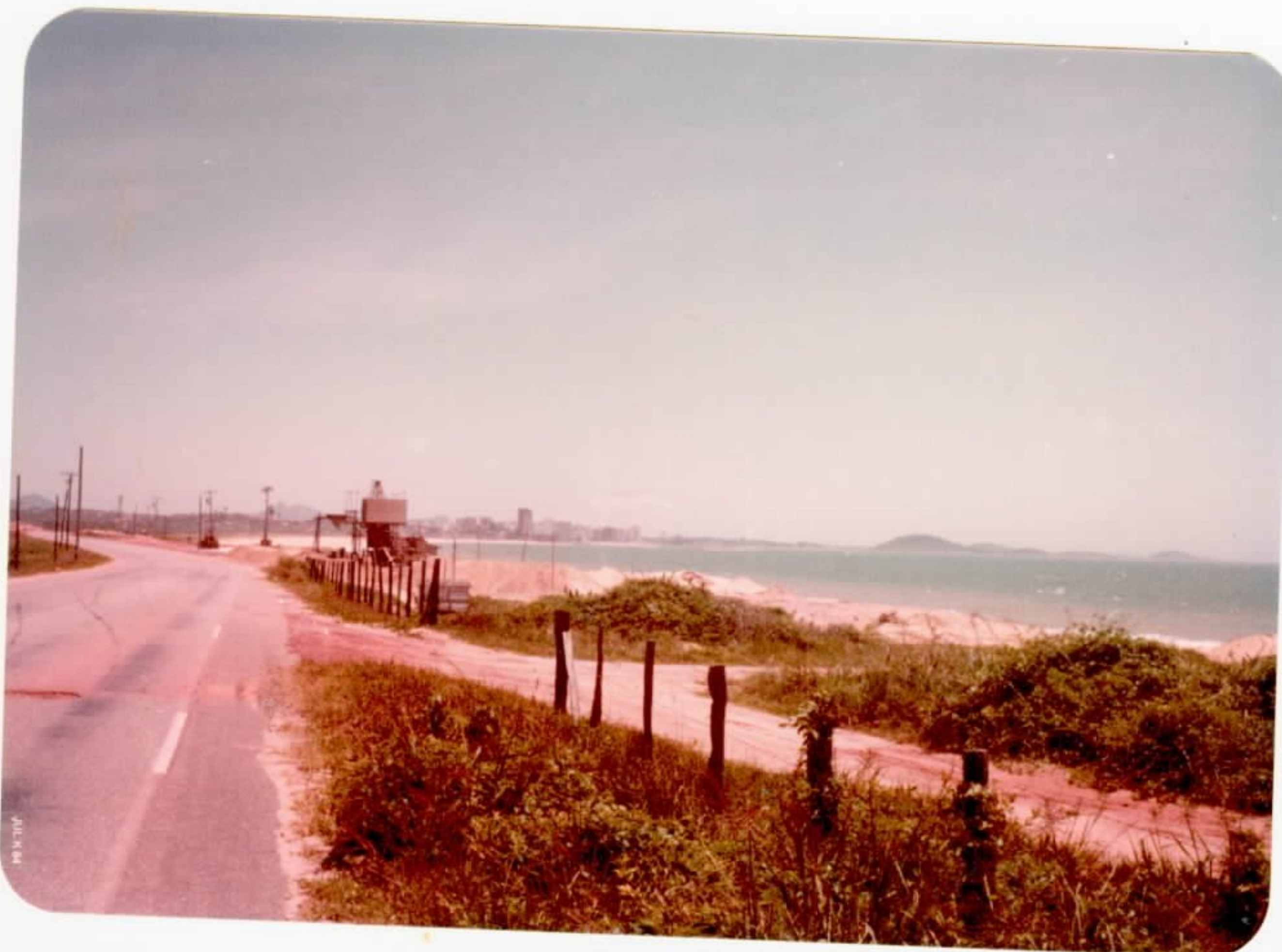
Foto nº 14 - Trecho do litoral ao sul de Guarapari(ao fundo). Observa-se, em primeiro plano, a unidade de concentração de minerais pesados da subsidiária da Nuclemon.
