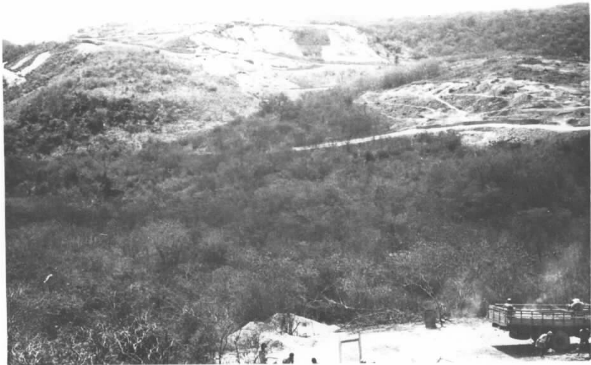
FOTO Nº 60 - Mina de manganês do Boqueirão do Pedrinho. Ao longe área já trabalhada sobre a Formação Caboclo. Em primeiro plano área objeto de Lavra.
