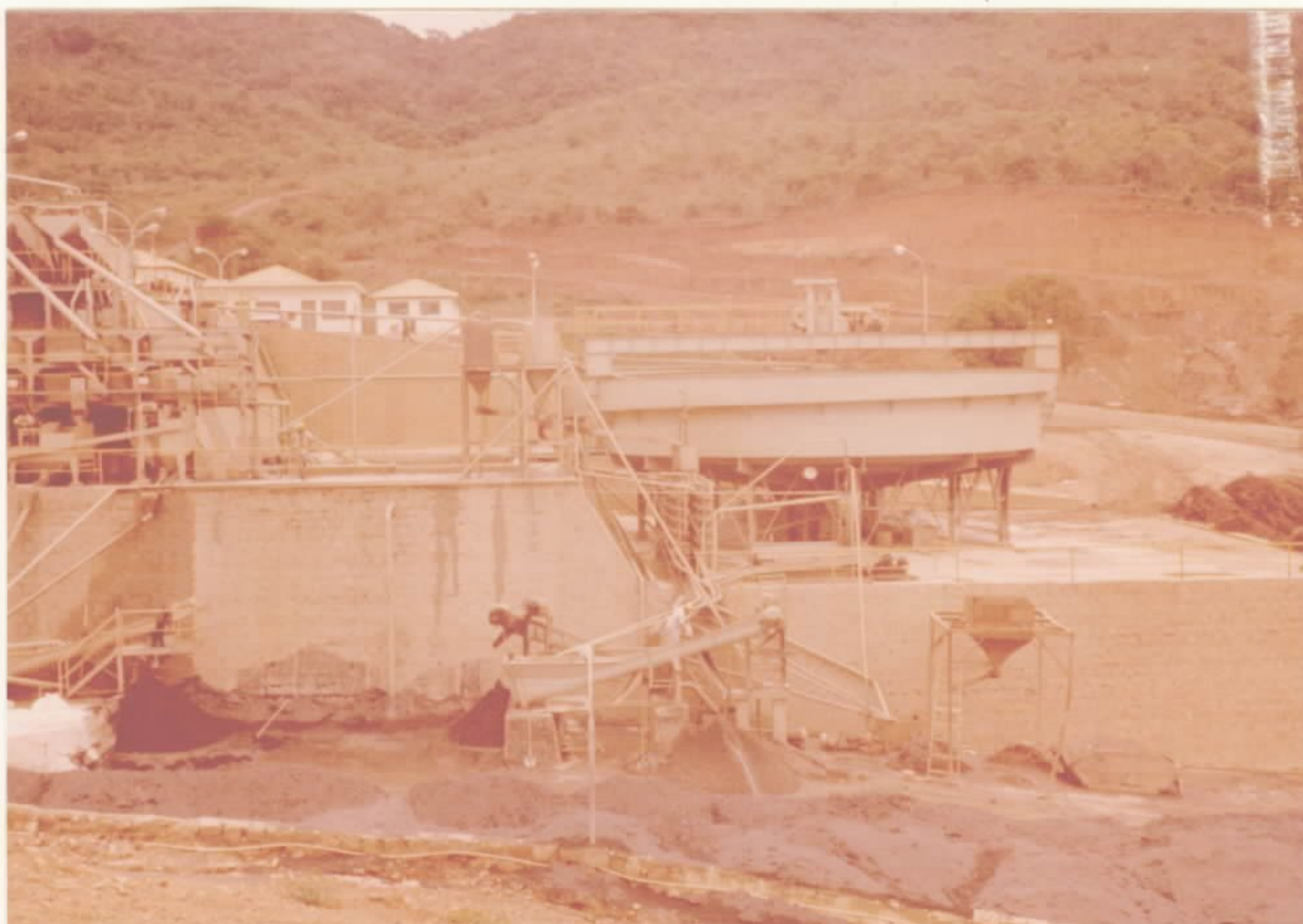
Foto 6 - Vista parcial da usina, parte final do circuito
