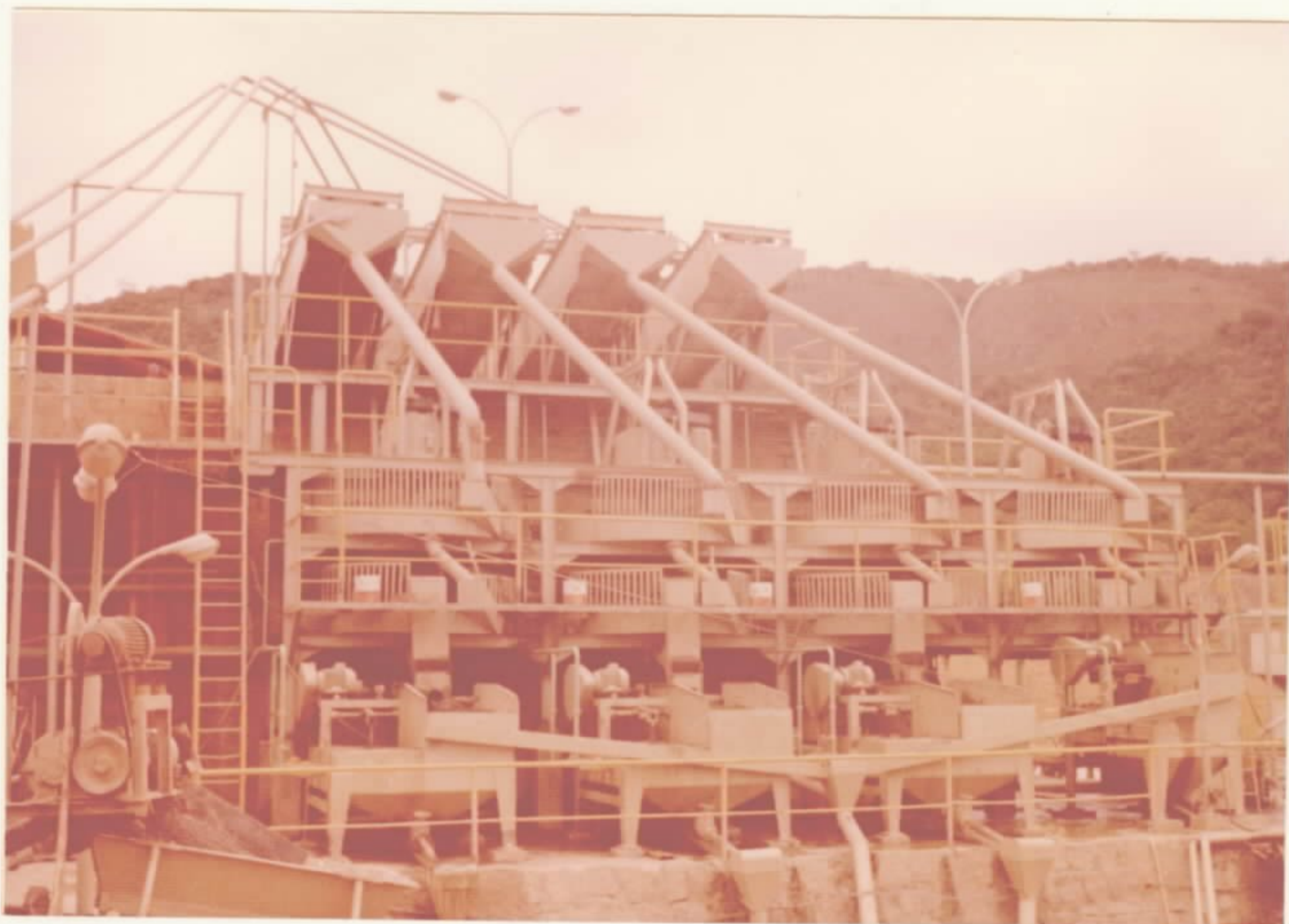
Foto 8 - Classificadores de arraste, panelas concentradoras e jiges
