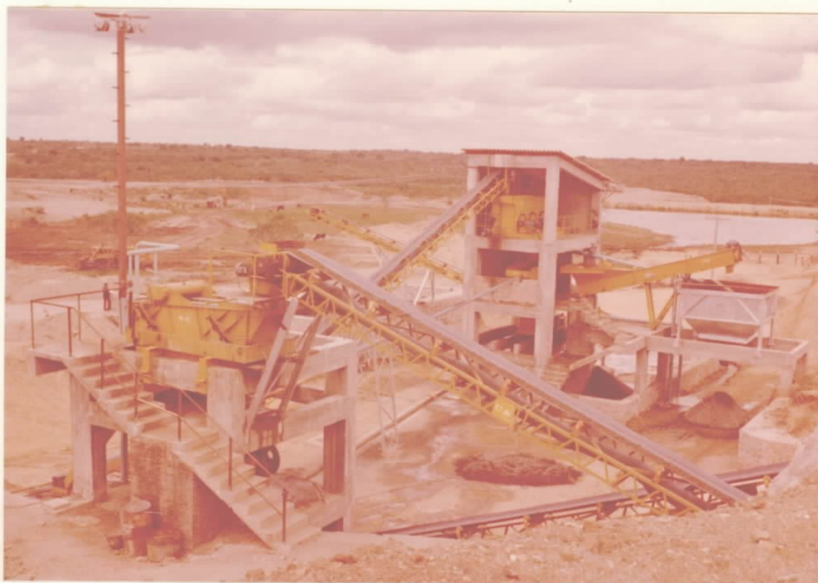
Foto 13 - Vista da usina de Lage Nova-Mi- neração Vale do Jacurici
