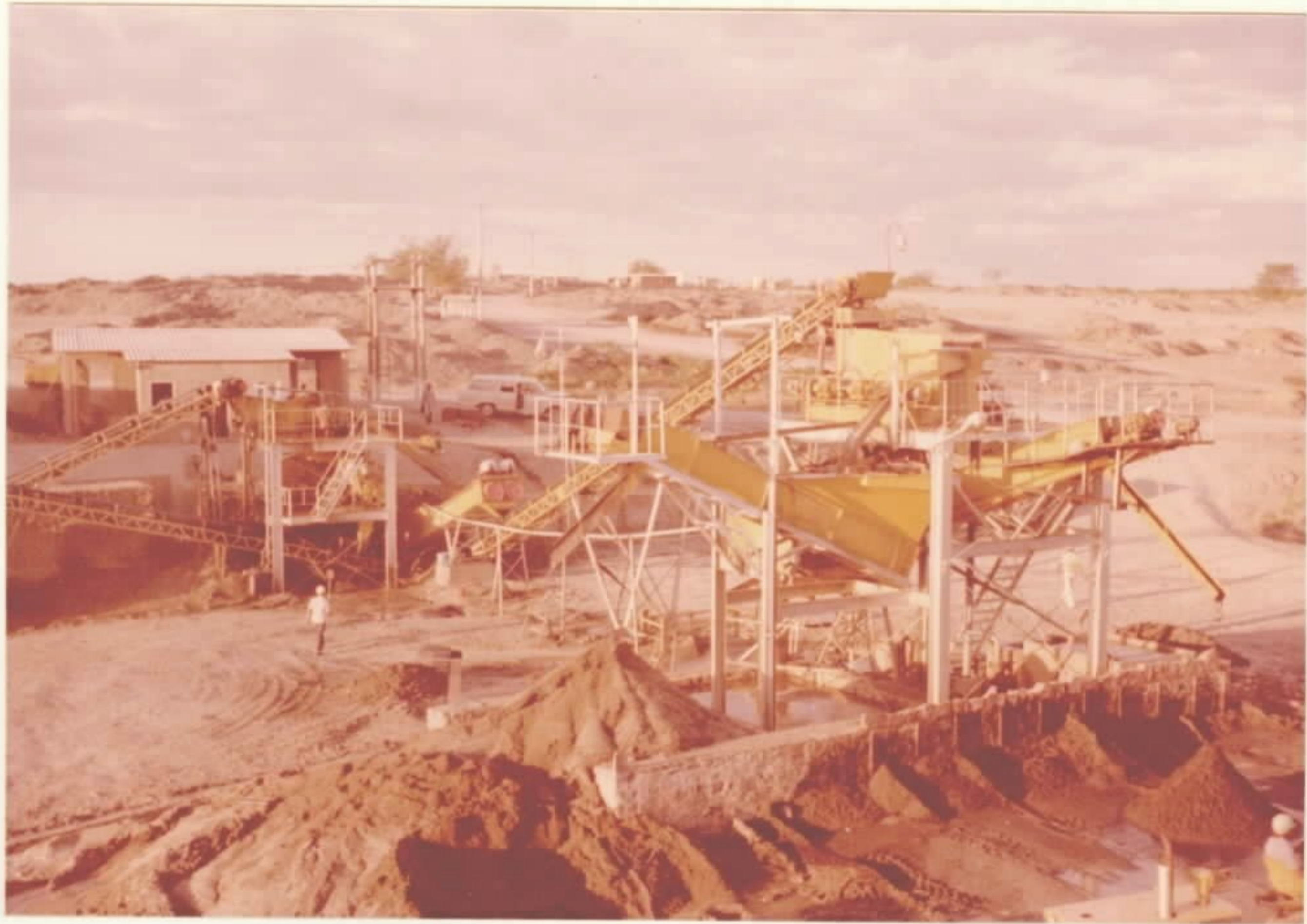
Foto 9 - Vista da usina
