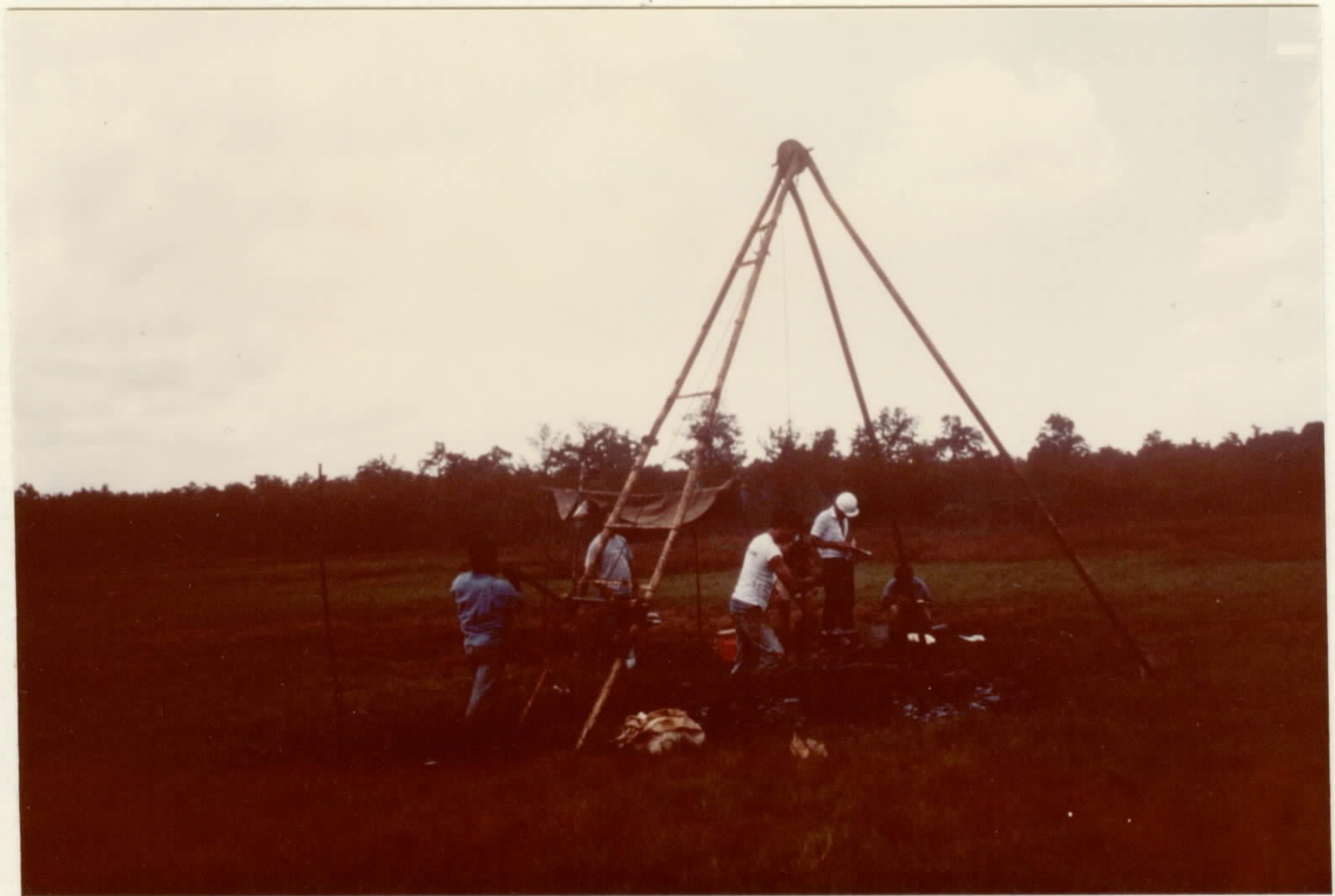
FOTO 09 - Sondagem mecanizada até 30 m na baixa ma ranhense, Campo de Perizes.
