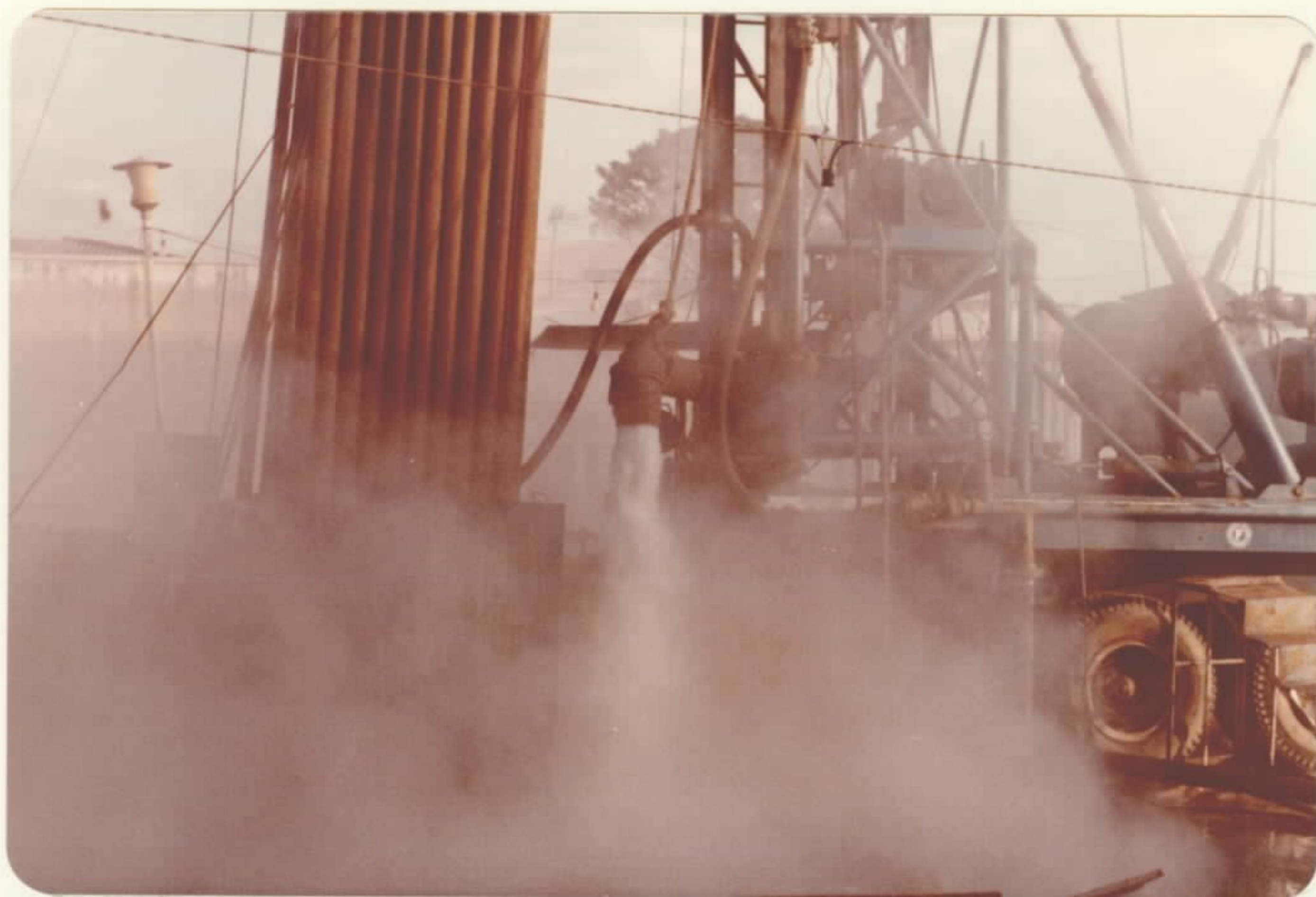
Detalhe do desenvolvimento com compressor no poço 04-RP-01-SP.
