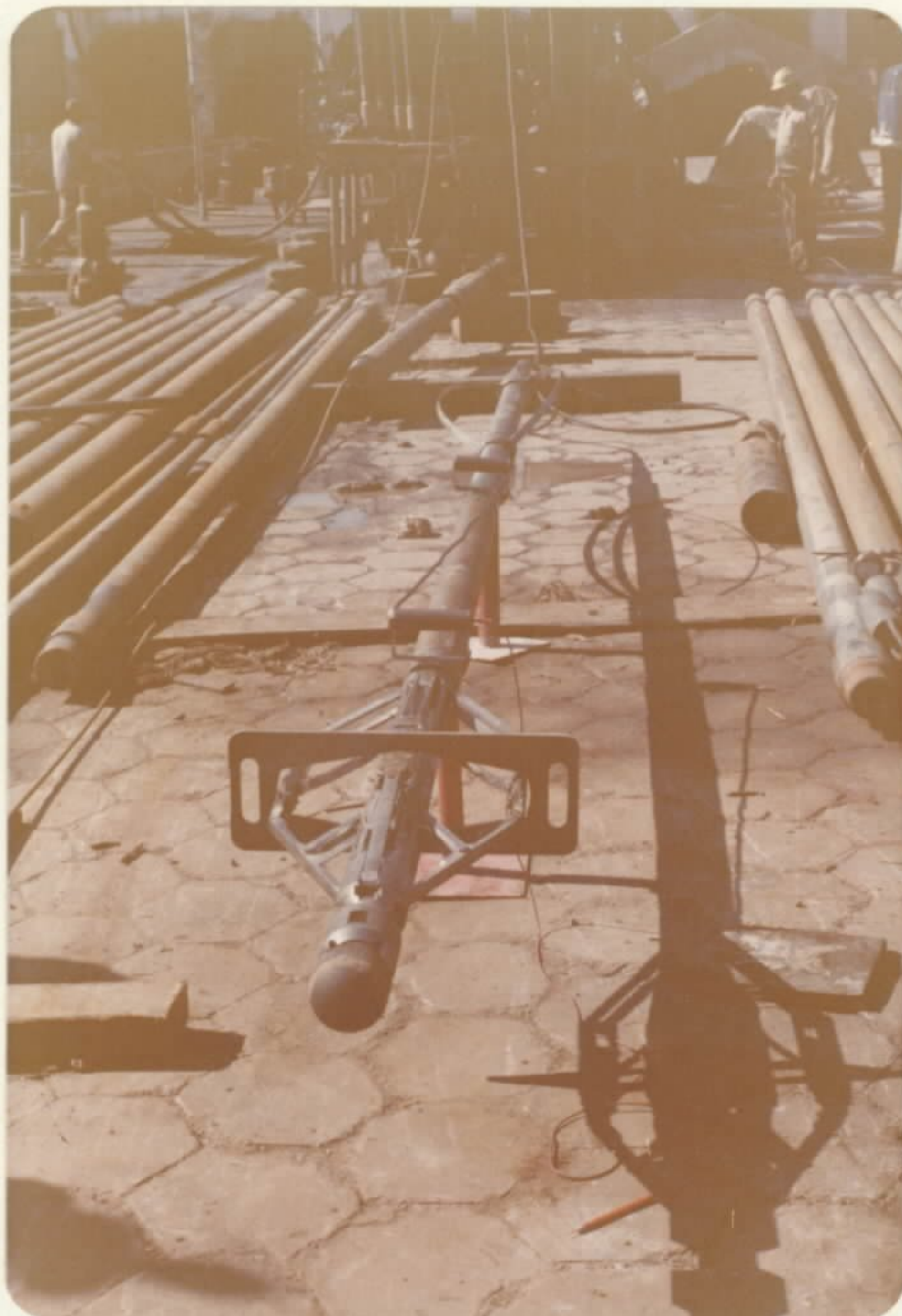
Sonda caliper da Schlumberger em calibração.
