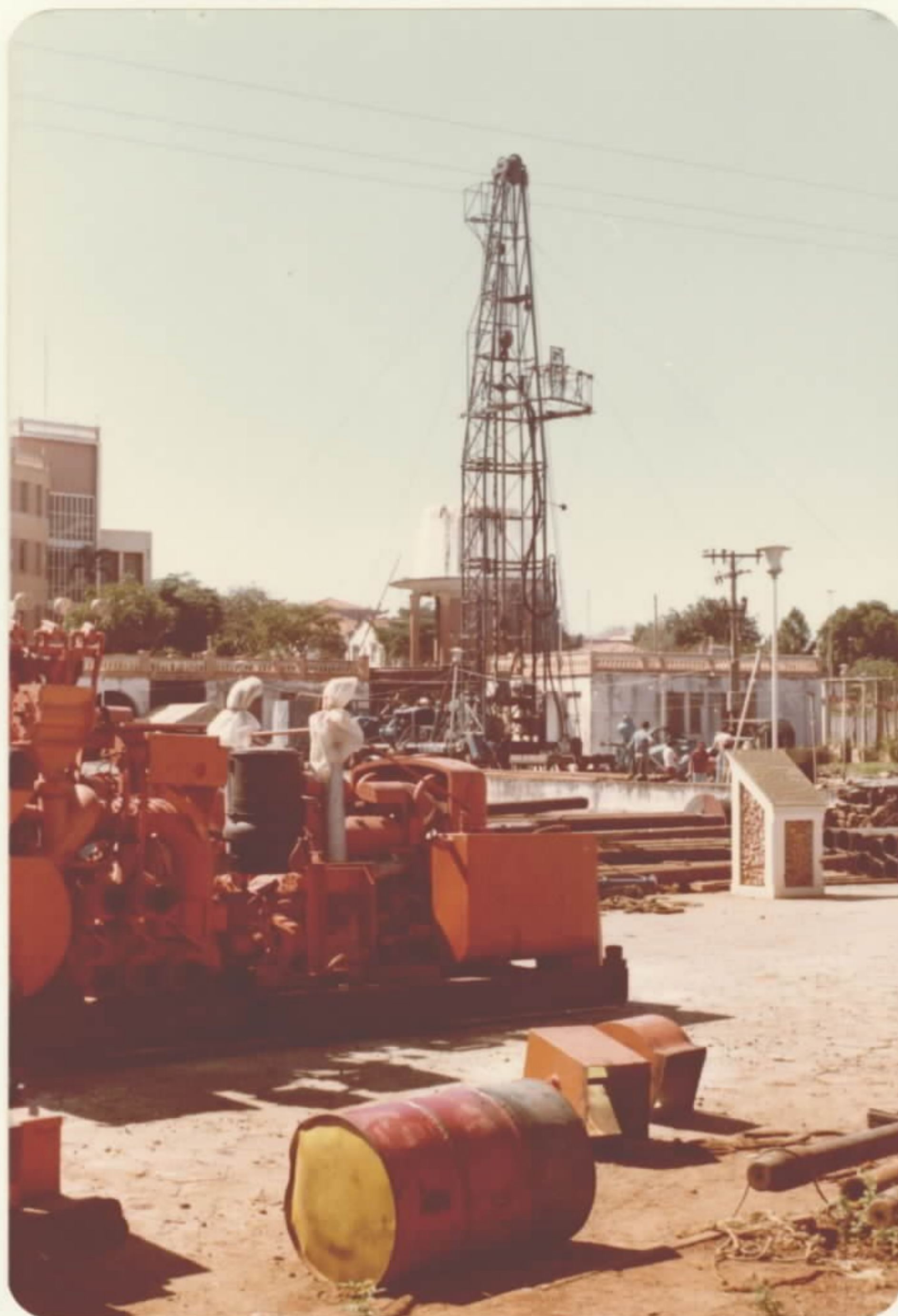
Sonda Failing 3000 ao fundo e em 1º plano equipamento de carregar o silo de pré-filtro.
