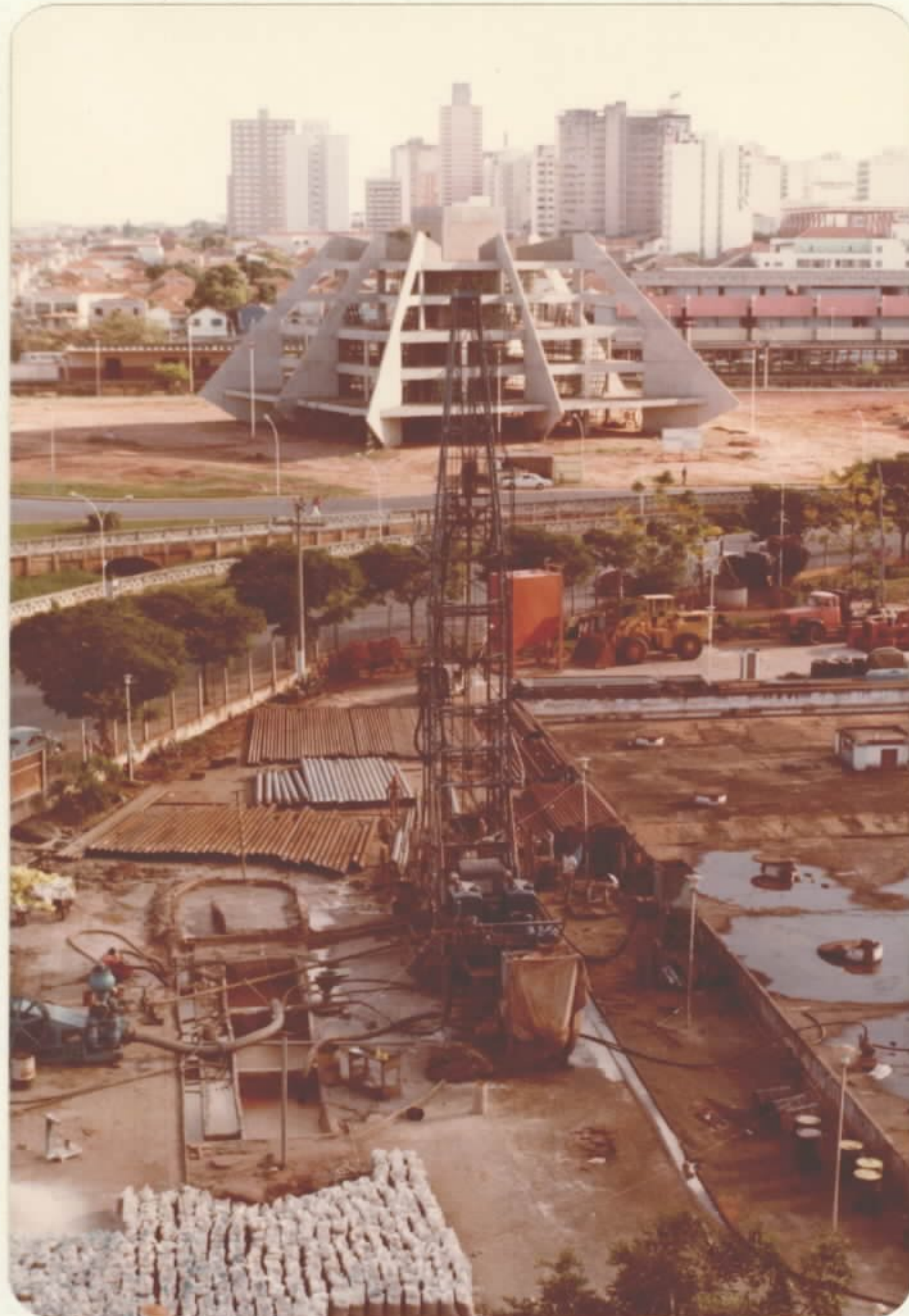
Vista geral do canteiro de obras do poço 04-RP-01-SP.
