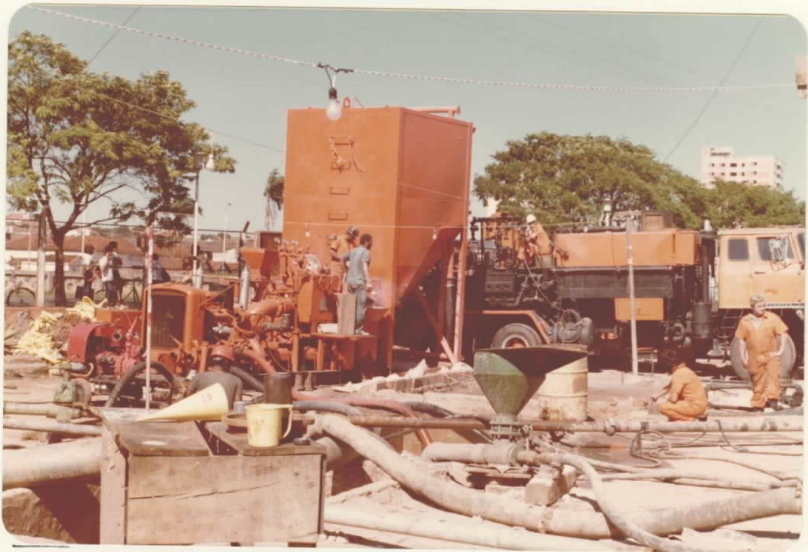
Vista panorâmica da montagem do equipamento de injeção de pré-filtro DOWELL-SCHLUMBERGER.
