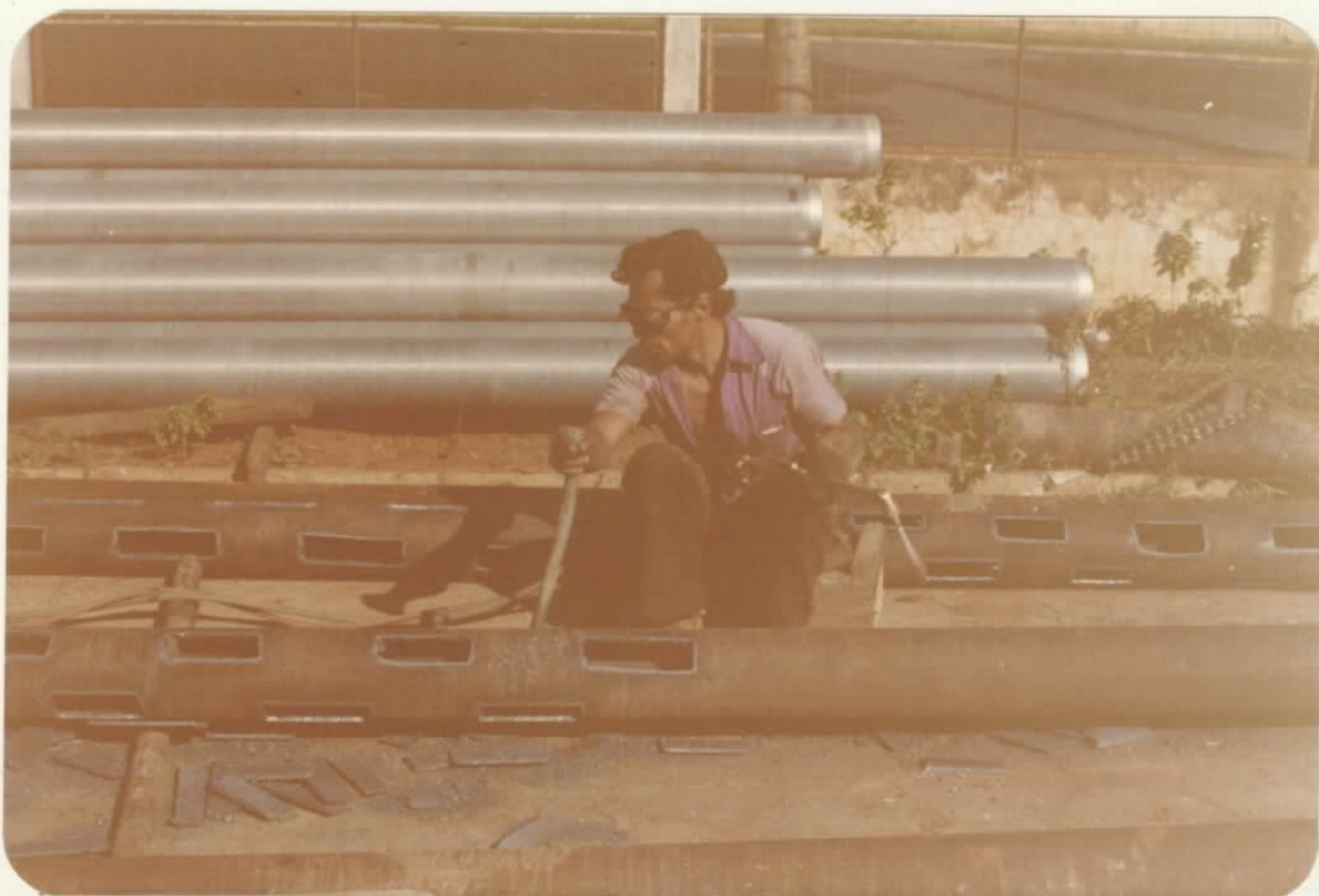
Tubos de 7" sendo rasgados para serem encamisados por filtros de 8" "standard".
