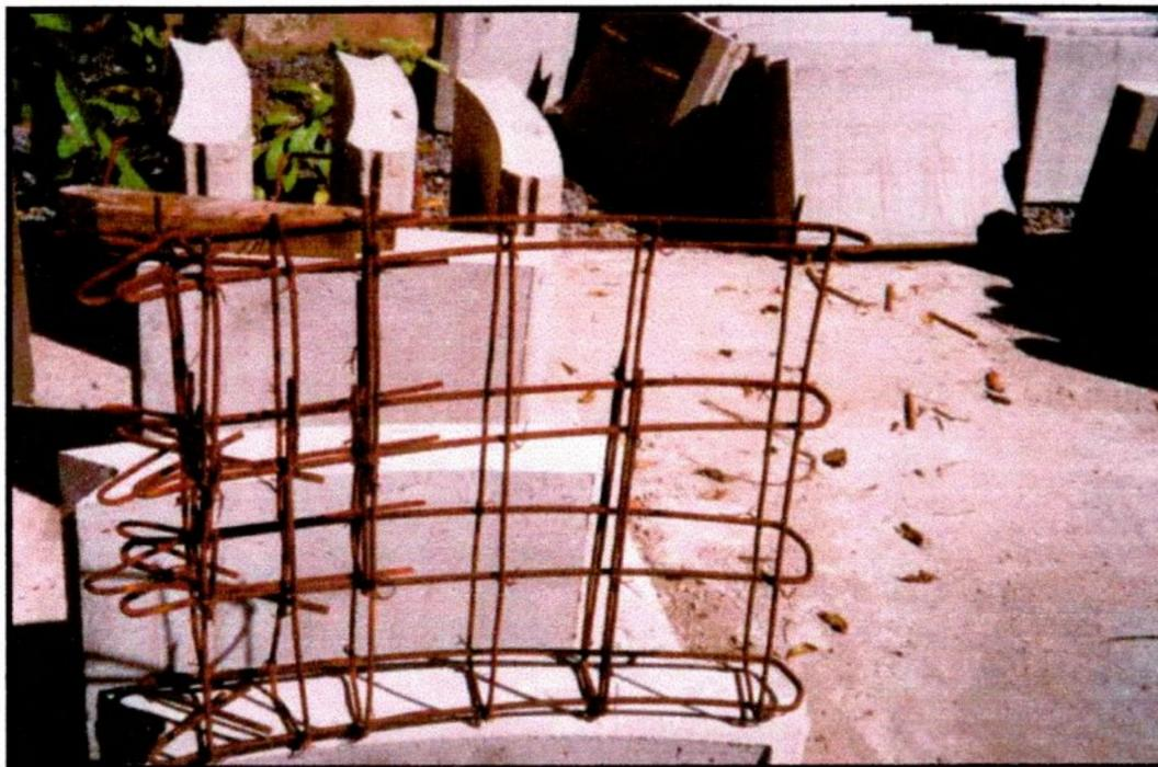
**Foto 3** - Malha metálica em ferro 3/16" desenhada pela UFPE.
