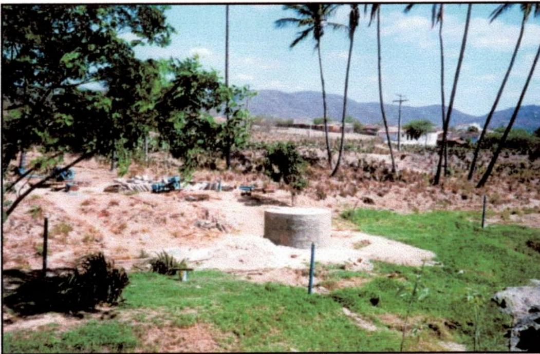
**Foto 18 – Marcação em superfície da projeção dos três drenos instalados.**
