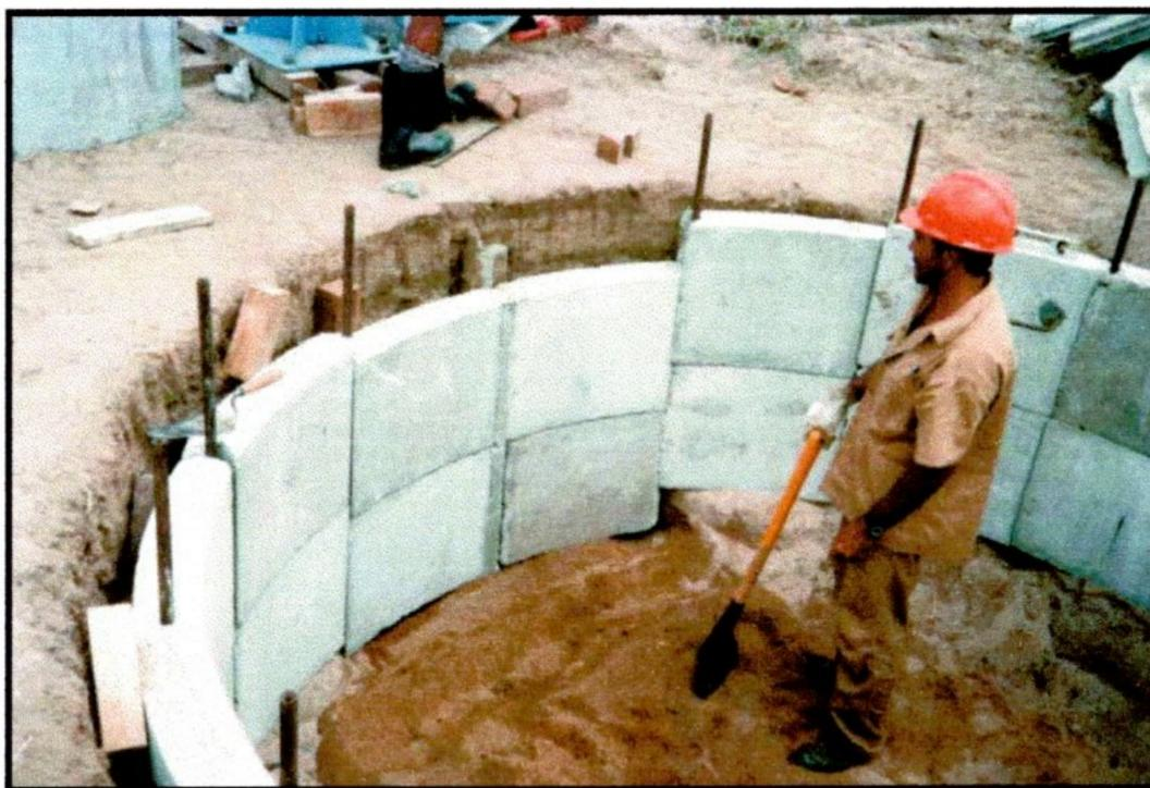
**Foto 4** - Início da montagem dos blocos pré-moldados e escavação manual, observando-se, na vertical, os "centralizadores" responsáveis pela estabilização dos blocos.
