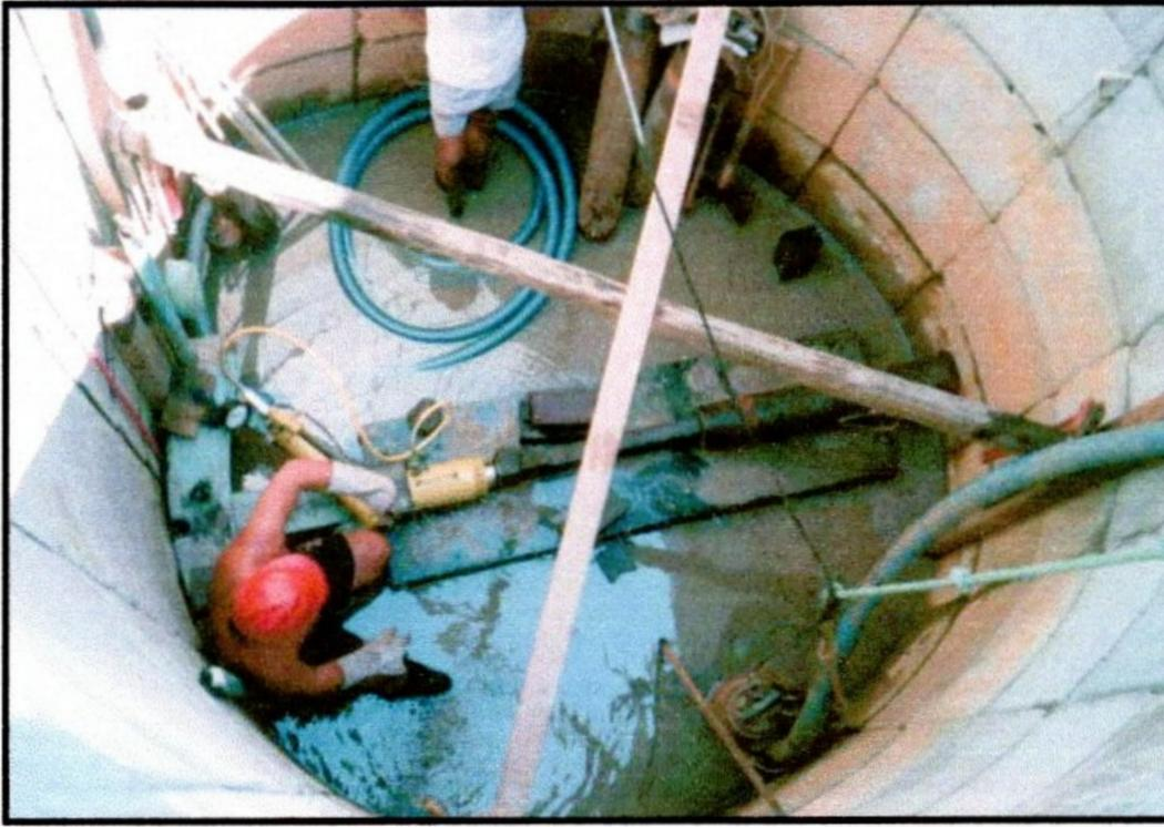
**Foto 7** - Prensamento com cilindro hidráulico dos tubos de 6 5/8".
