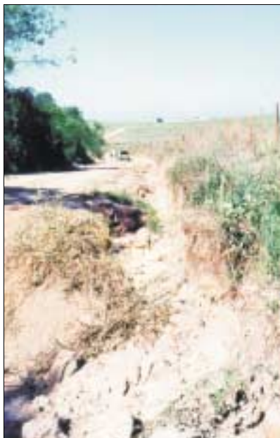
Foto 28 - Erosão induzida pela concentração de águas pluviais ao longo de uma estrada locada sobre os terrenos do subdomínio 5b 2 . Esse é um tipo de problema verificado ao longo de quase toda a malha viária rural.
