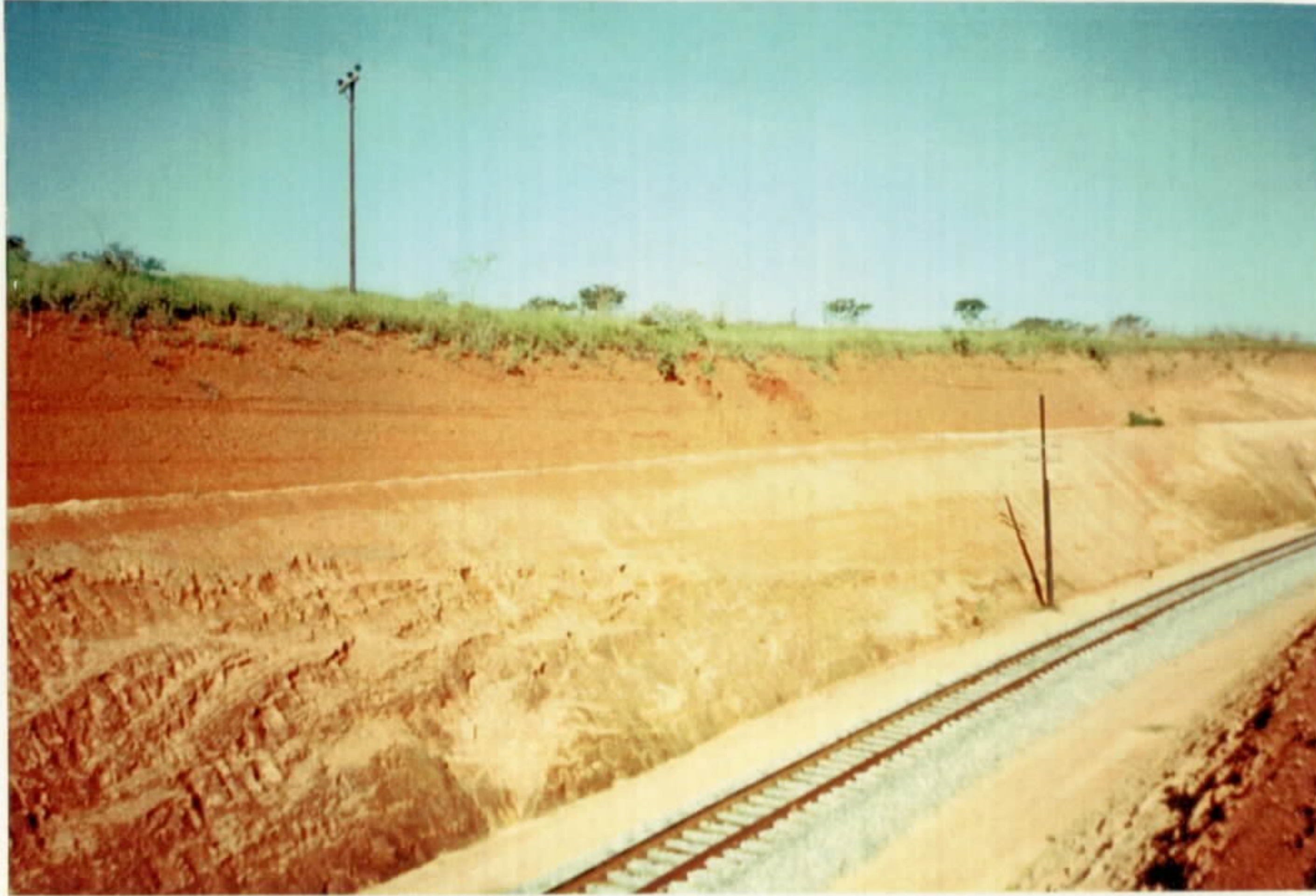
Foto 9: Unidade 5/Unidade 3-Solos coluviais vermelho escuro preenchendo paleodepressões dos solos residuais de metapelitos, geralmente mais susceptíveis aos efeitos da erosão. Corte da RFFSA, viaduto da MG 238.
