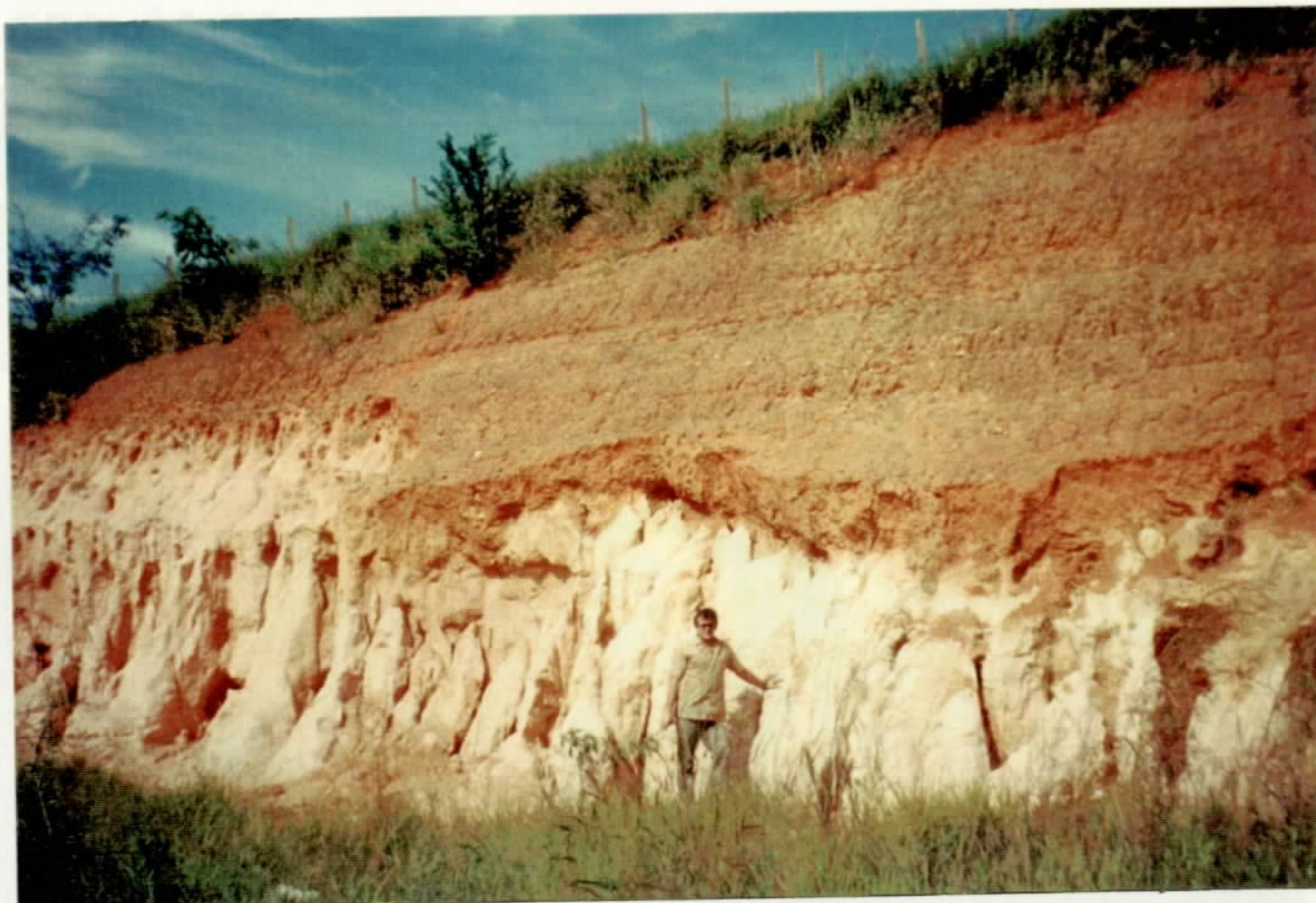
Foto 7: Unidade 1. Solos residuais de rochas gnáissicas-migmatíticas, coloração rósea, textura silte-argilo-arenosa, contendo evidências da estrutura original da rocha. Em cortes apresenta alta propensão a erosão através de sulcos verticais. Rodovia Inhaúma-Sete Lagoas, km 54.
