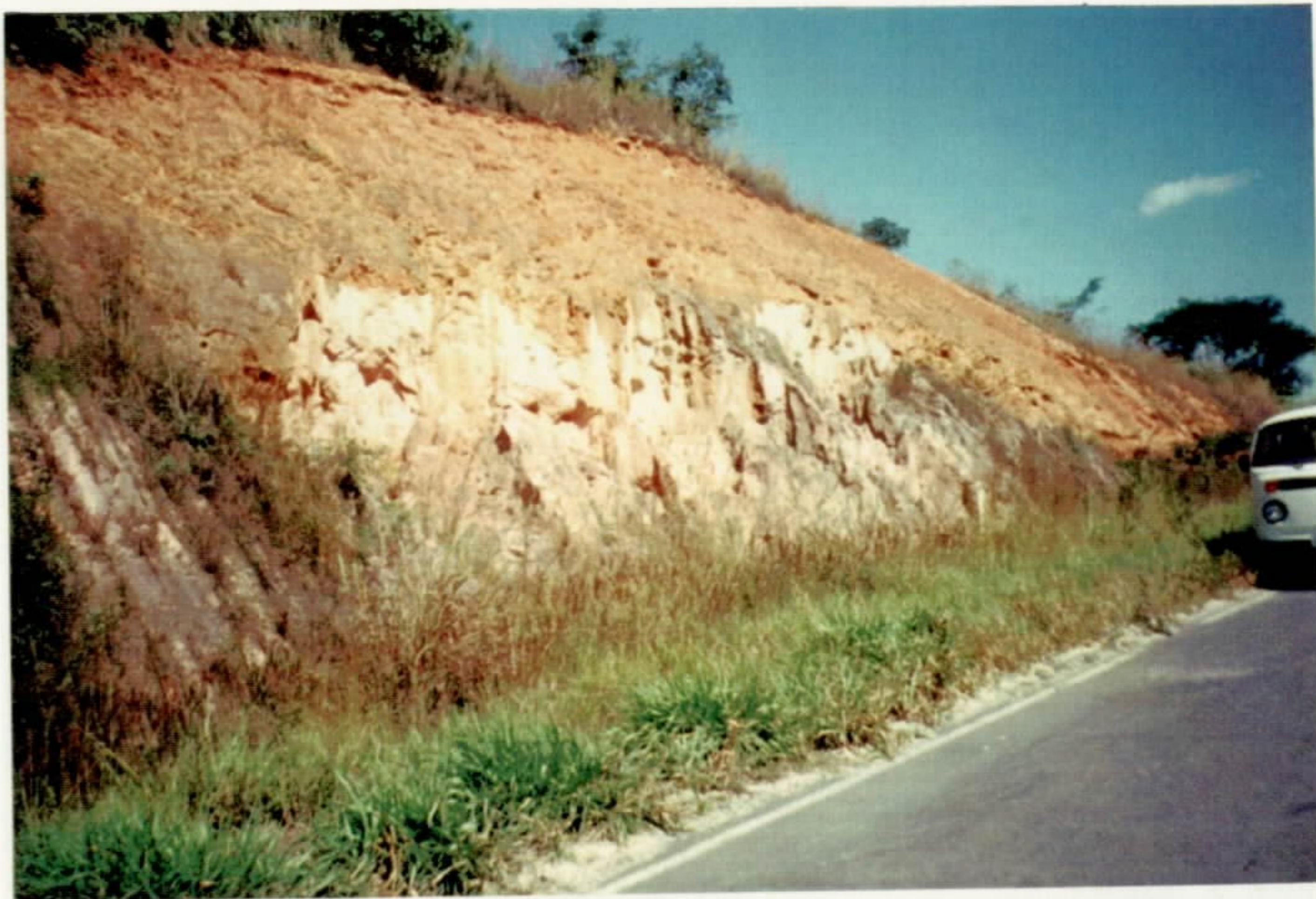
Foto 7: Unidade 1. Solos residuais de rochas gnáissicas-migmatíticas, coloração rósea, textura silte-argilo-arenosa, contendo evidências da estrutura original da rocha. Em cortes apresenta alta propensão a erosão através de sulcos verticais. Rodovia Inhaúma-Sete Lagoas, km 54.
