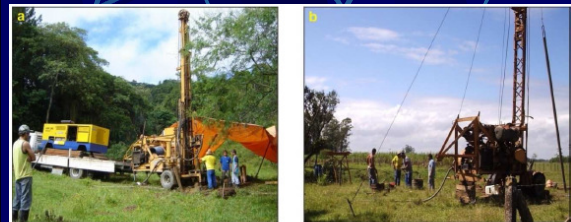
Figura 2.116 – Equipamento usado para a perfuração dos poços de monitoramento. a) Sonda rotot-pneumática MAQUESONDA NSP-325; b) Sonda percussiva TORNEP 22H.
