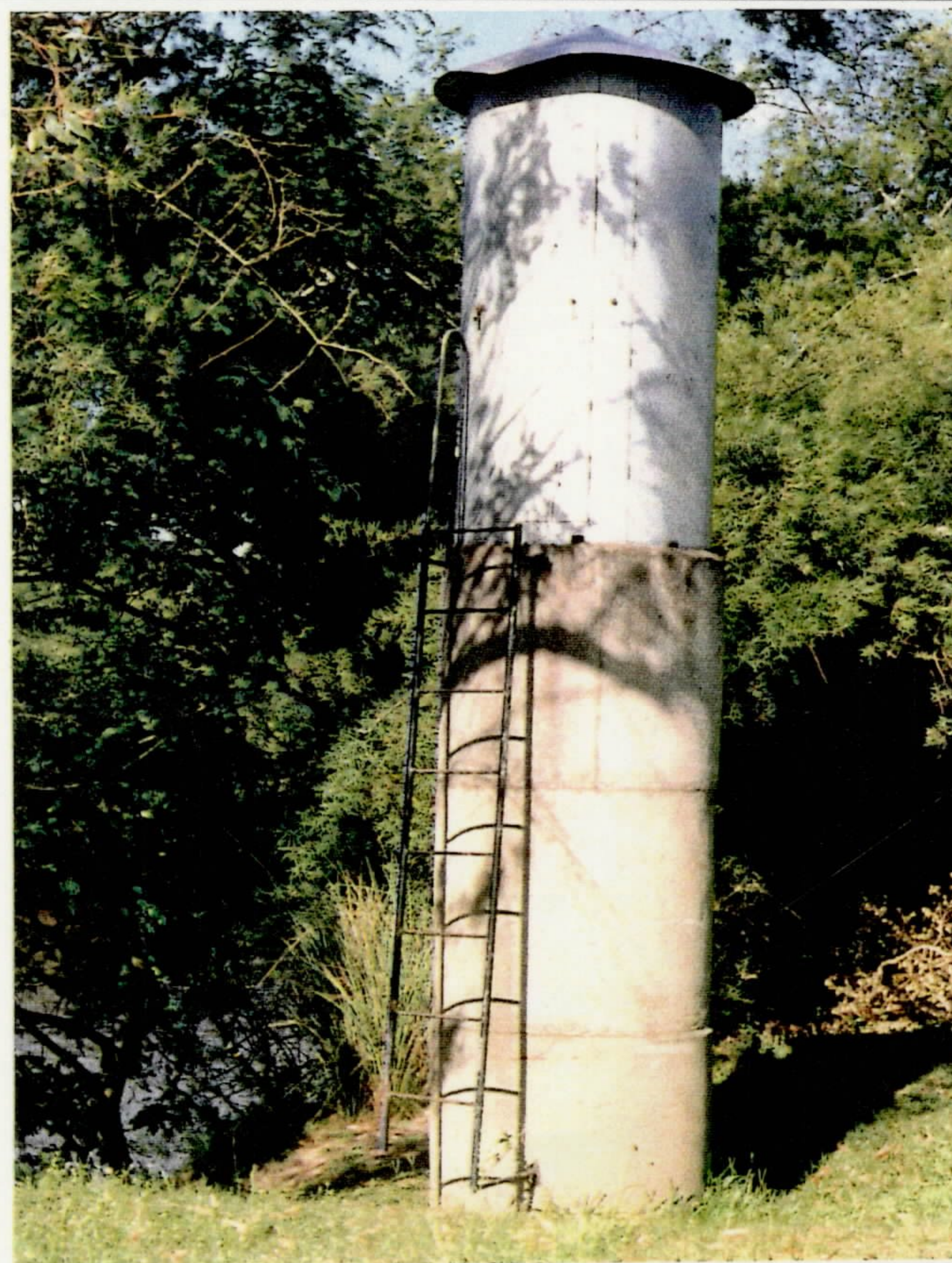
Foto 6 - Estação linigráfica de Passo das Canoas Auxiliar (DNAEE).
