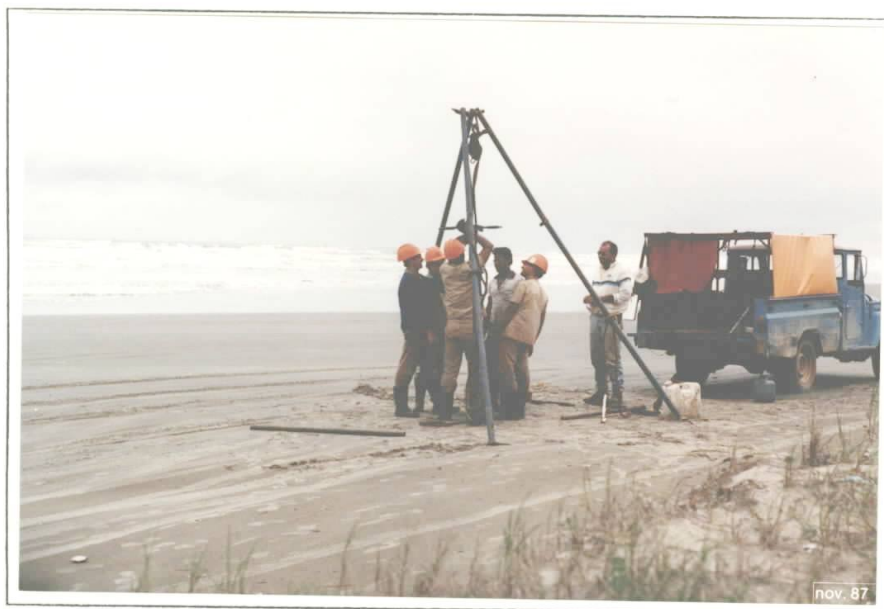
FOTO 3 - Mesmo tipo de Sonda, mostrando operação de recuperação do testemunho.
