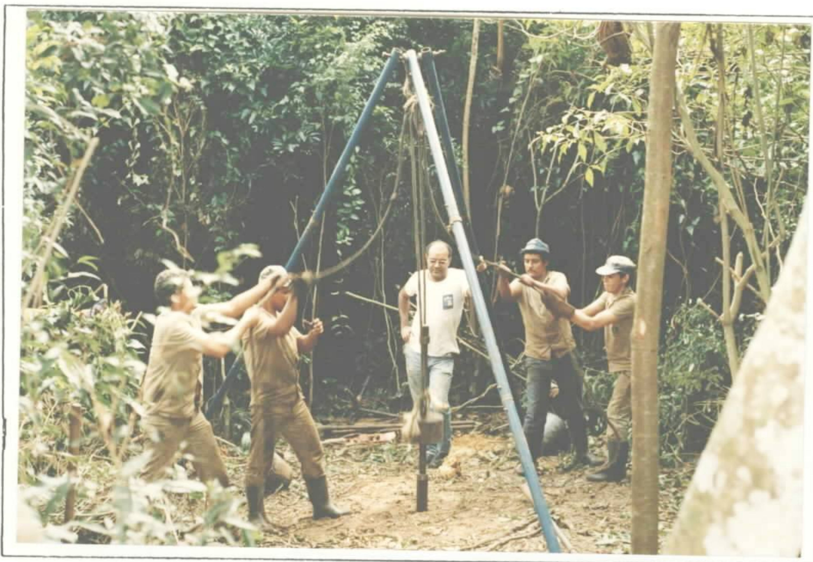
FOTO 2 - Sonda o tipo Banka, duas polegadas, manual, utilizada pelo Projeto. Operação de penetração dos revestimentos.
