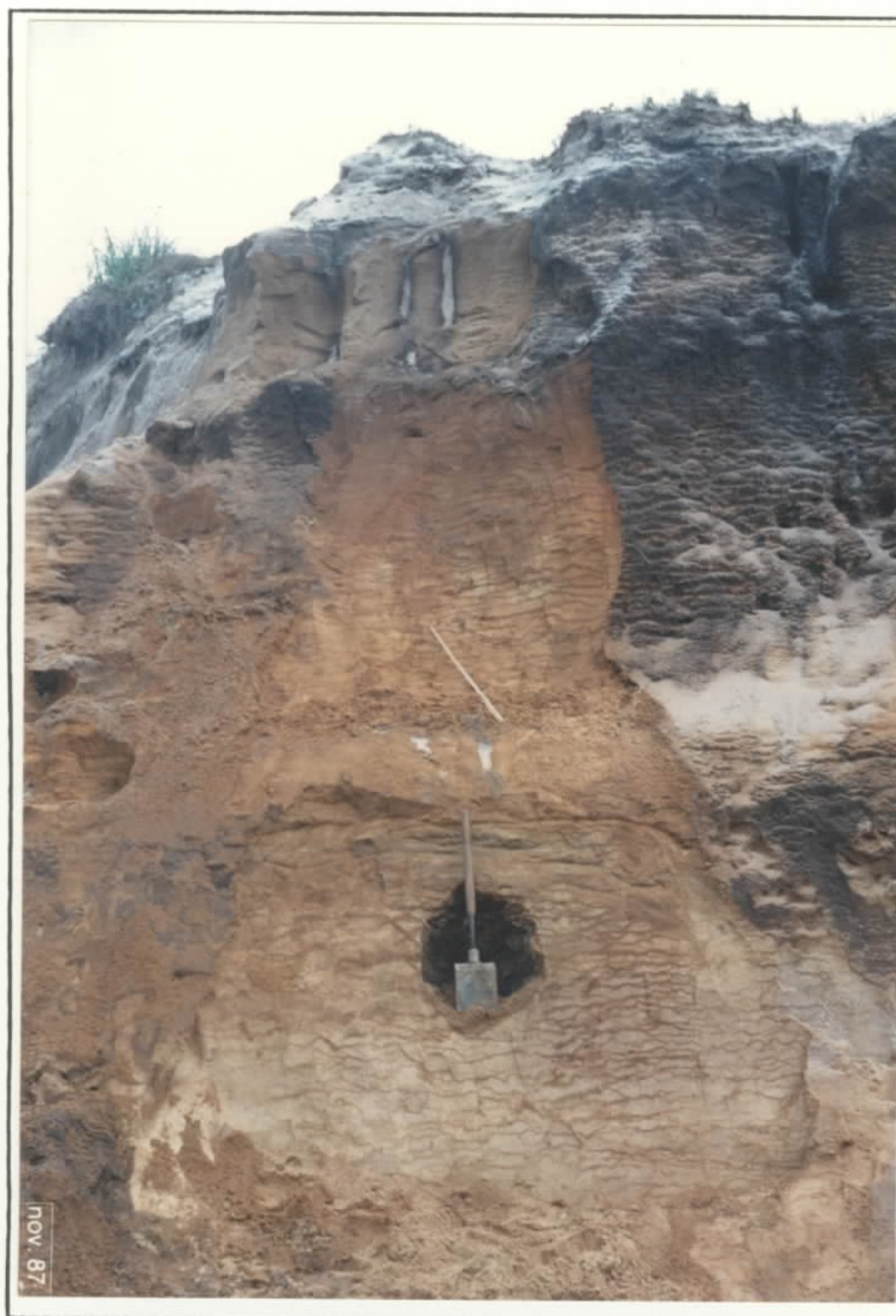
FOTO 9 - Aspectos geral de uma das frentes de lavra do afloramento MG-38, mostrando os cinco níveis descritos no perfil I da figura II.1.1.
