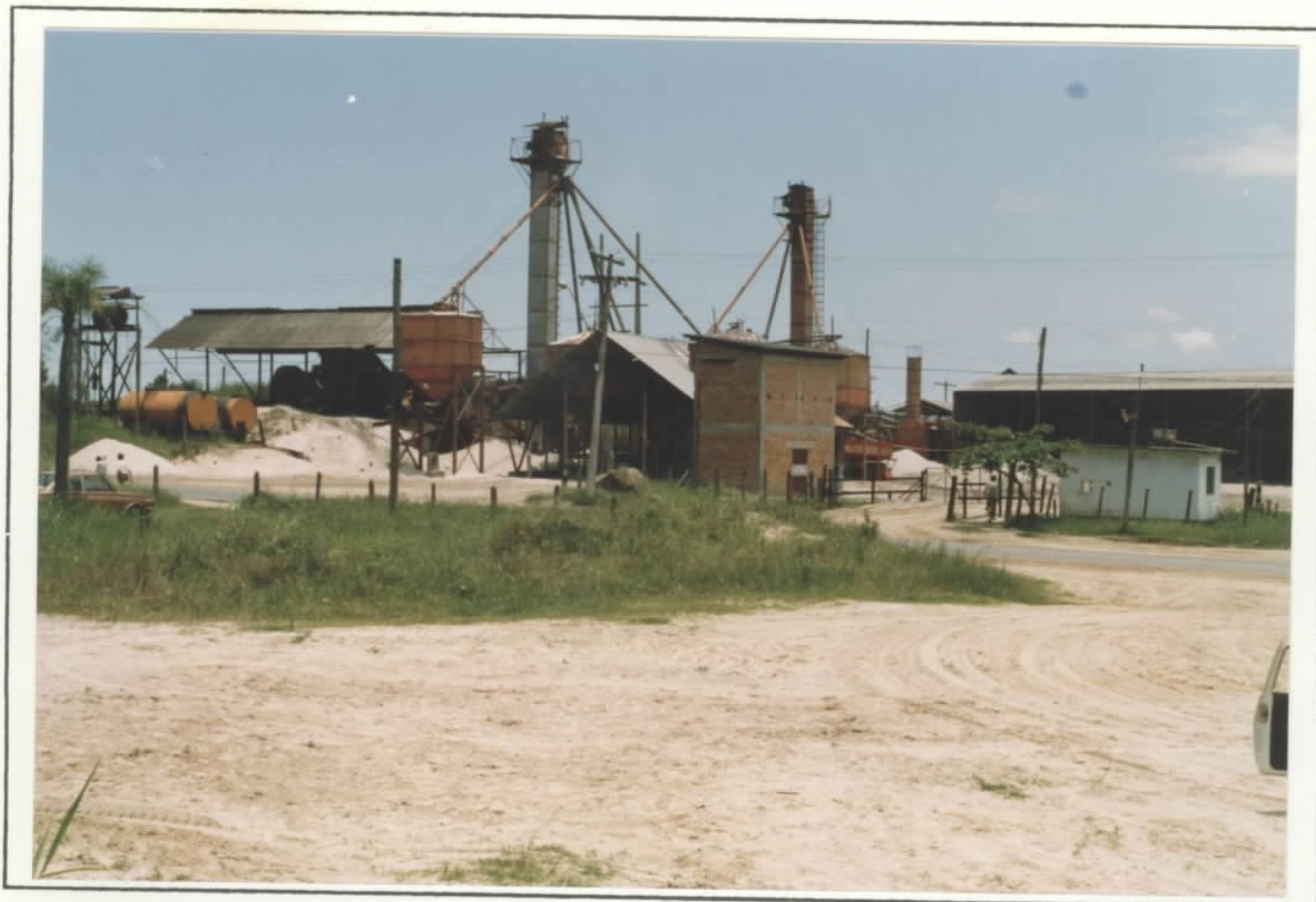
FOTOS 22 e 23 - Vista geral de plantas de beneficiamento na Baixada Santista. Na foto 22 é mostrada uma planta bastante rudimentar, onde as areias passam somente por um processo de lavagem, enquanto que na foto 23 observa-se a presença de fornos de secagem, ciclones e silos.
