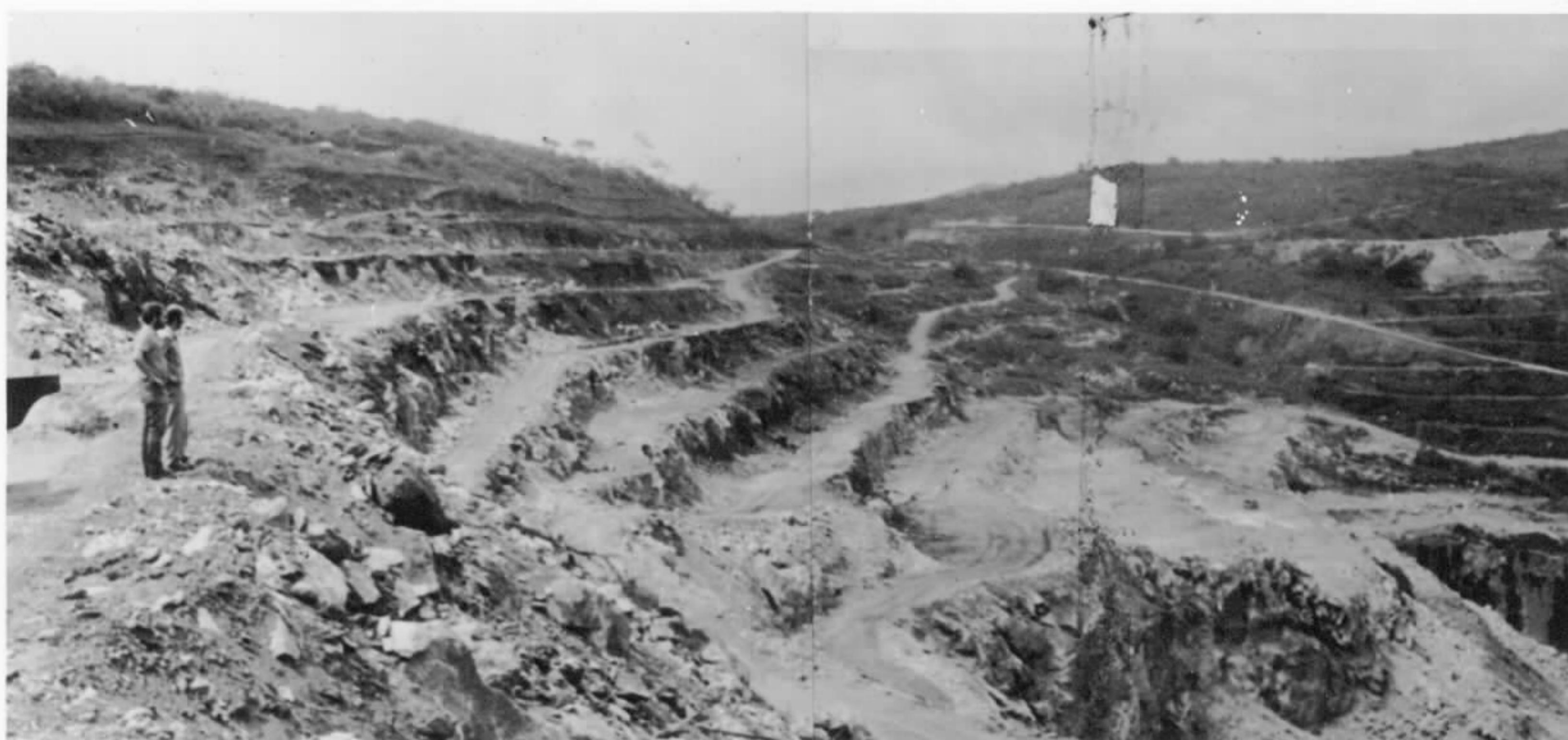
Foto 26 – Vista panorâmica da lavra da MAGNESITA S/A na serra das Éguas-Brumado-Mina Pedra Preta. O ataque às lentes de magnesita é realizado através de bancadas de 8 (oito) metros e com 20 níveis projetados a partir do topo das jazidas.
