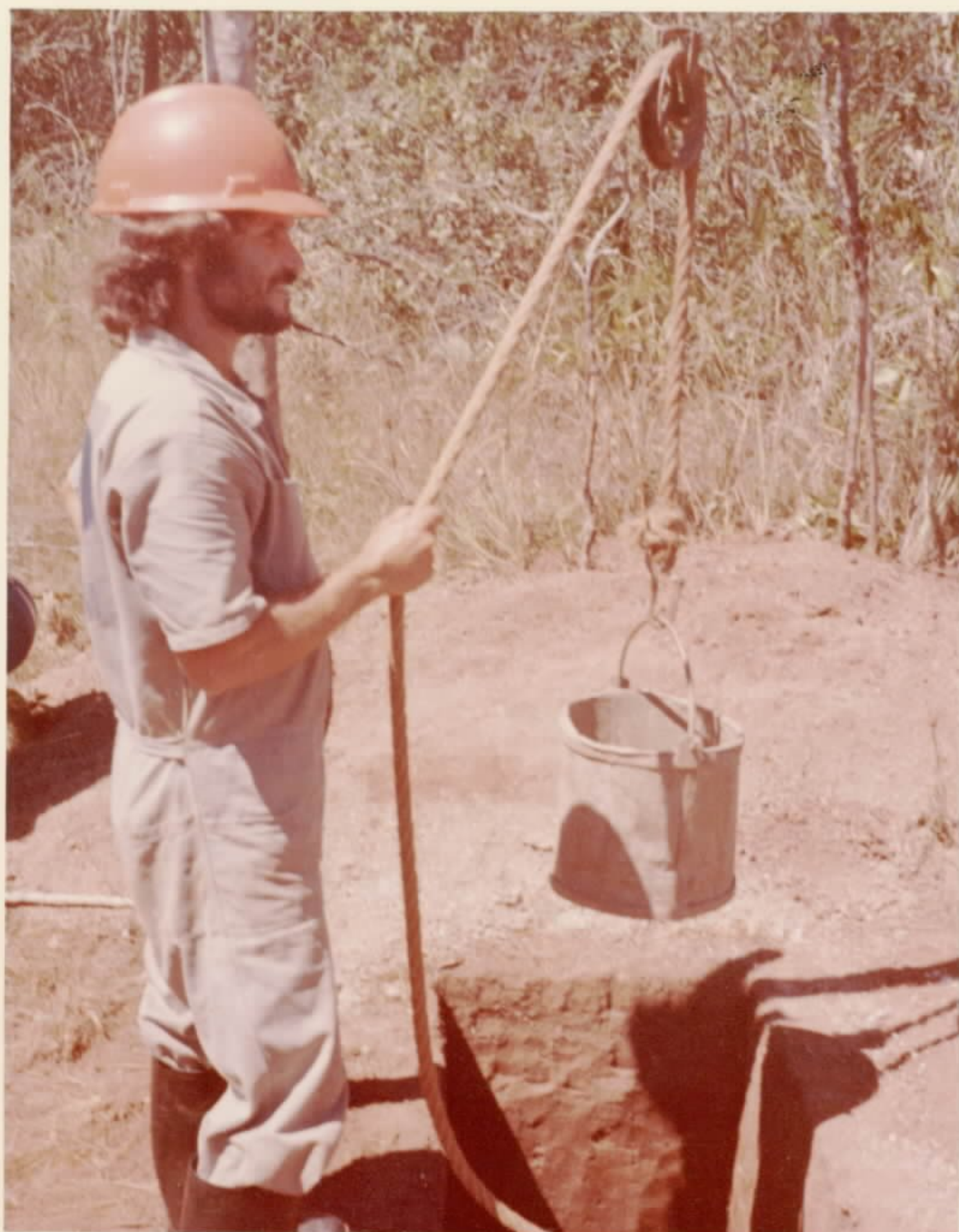
FOTO 02 Aspecto de ab er tura de poços.
