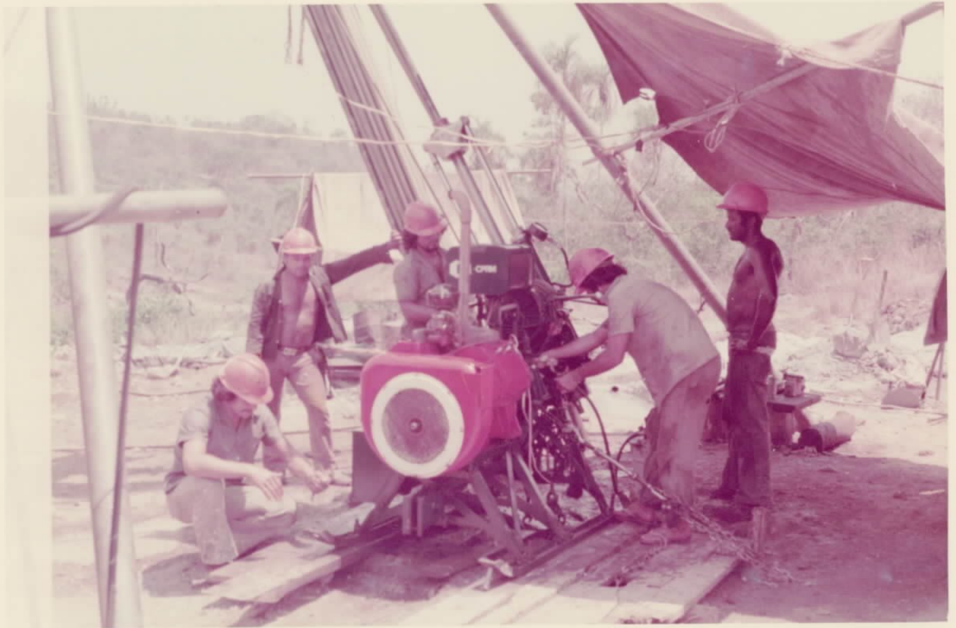
FOTO 03 - Aspecto dos trabalhos de sondagem.
