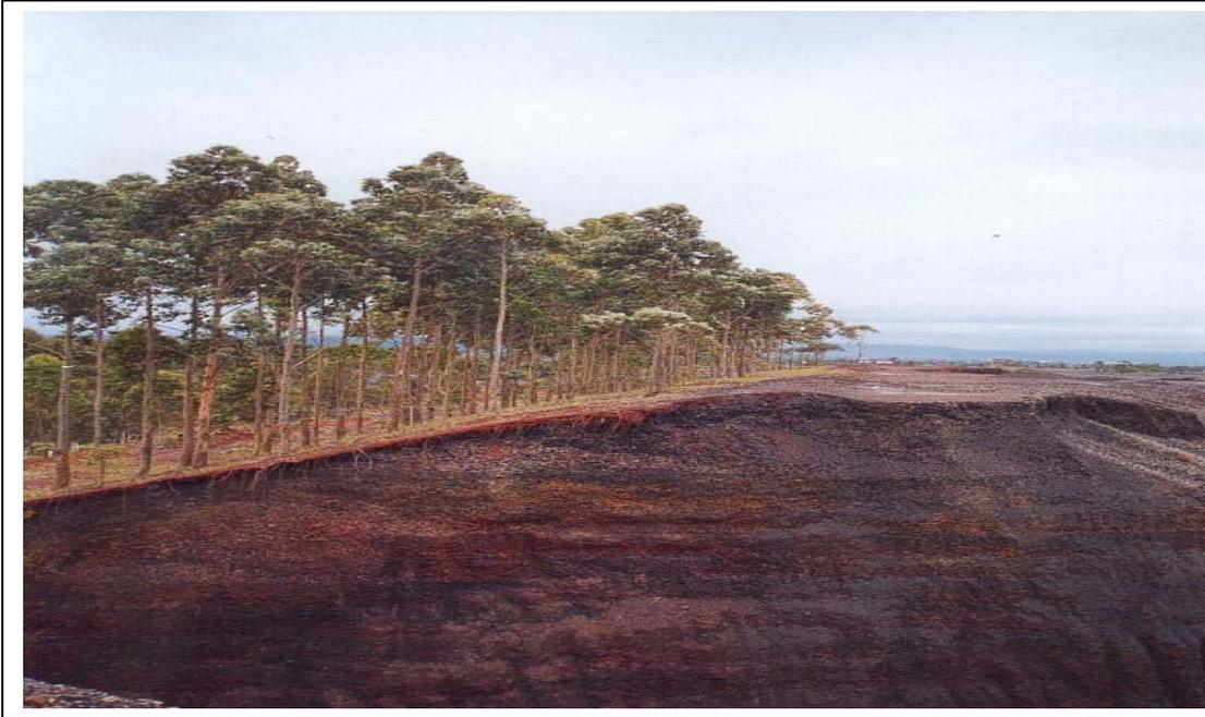
**Figura 4** - Antigos depósitos de rejeitos no sul da Bacia do rio Sangão para rebeneficiamento.
