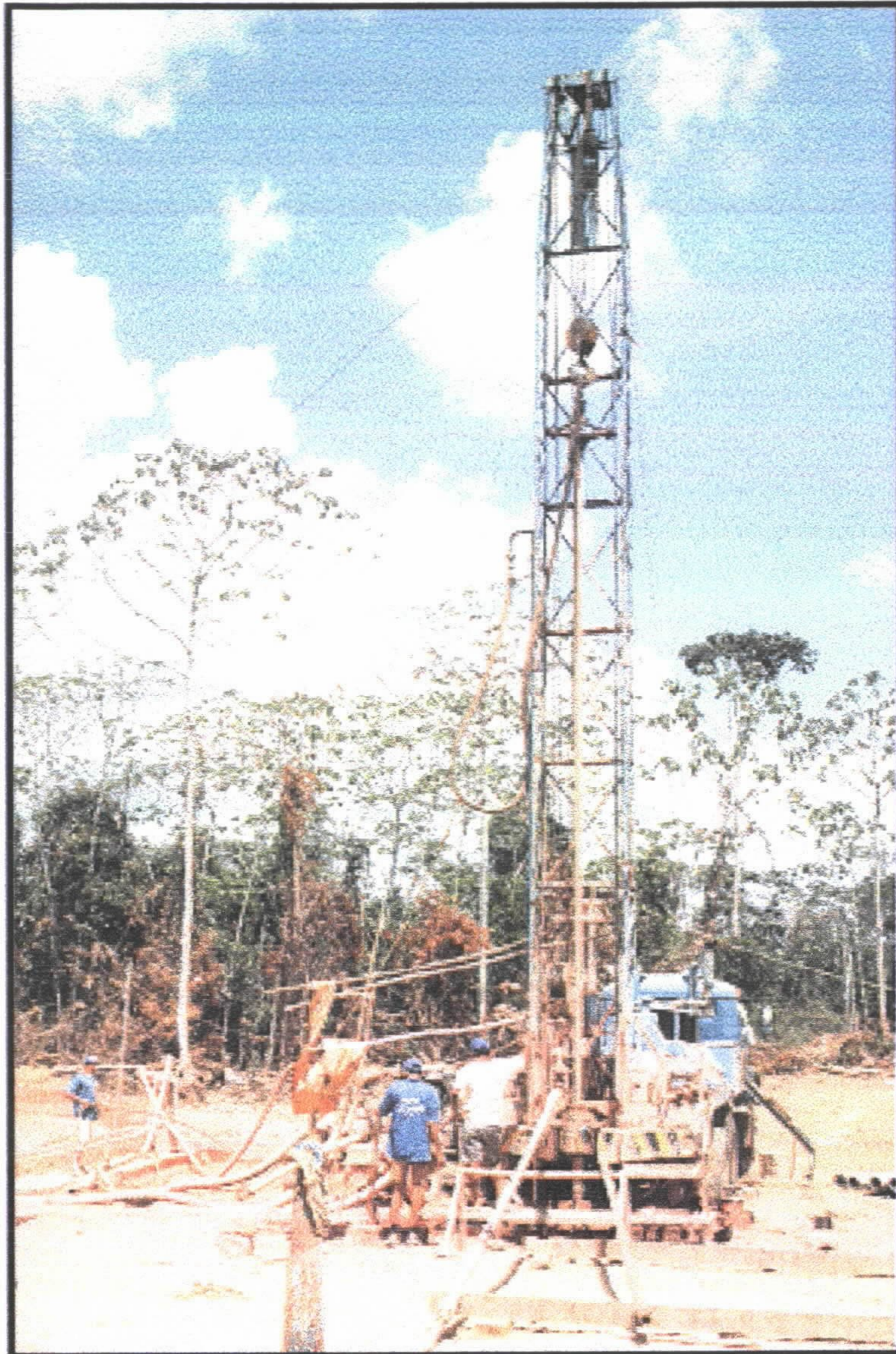
POÇO 4BRP - 04 - MA TRABALHOS DE PERFURAÇÃO SONDA FALLING CF-15
