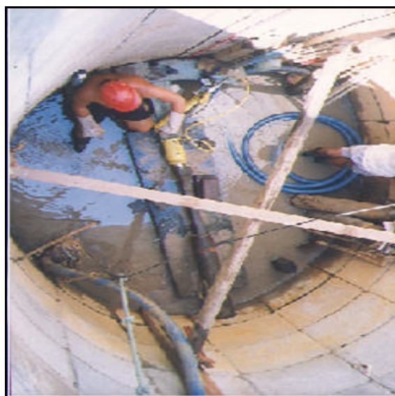
Figura 06 – Poço com drenos radiais. À direita, mostra-se a instalação das ponteiras (foto José Ubaldo de Sá)
