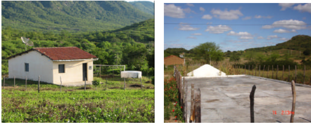
FIGURA 01 – Captações de águas pluviais
