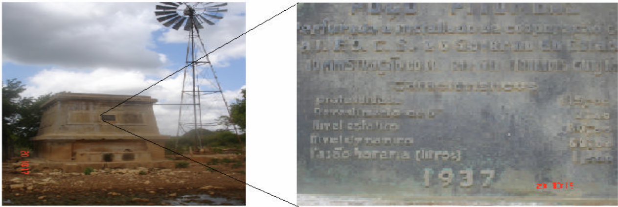
Figura 07 – Poço tubular “Pitombas”, município de Governador Dix-Sept Rosado, Estado do Rio Grande do Norte. Perfurado em 1937 pelo extinto IFOCS, atual DNOCS, até hoje produtor de água.
