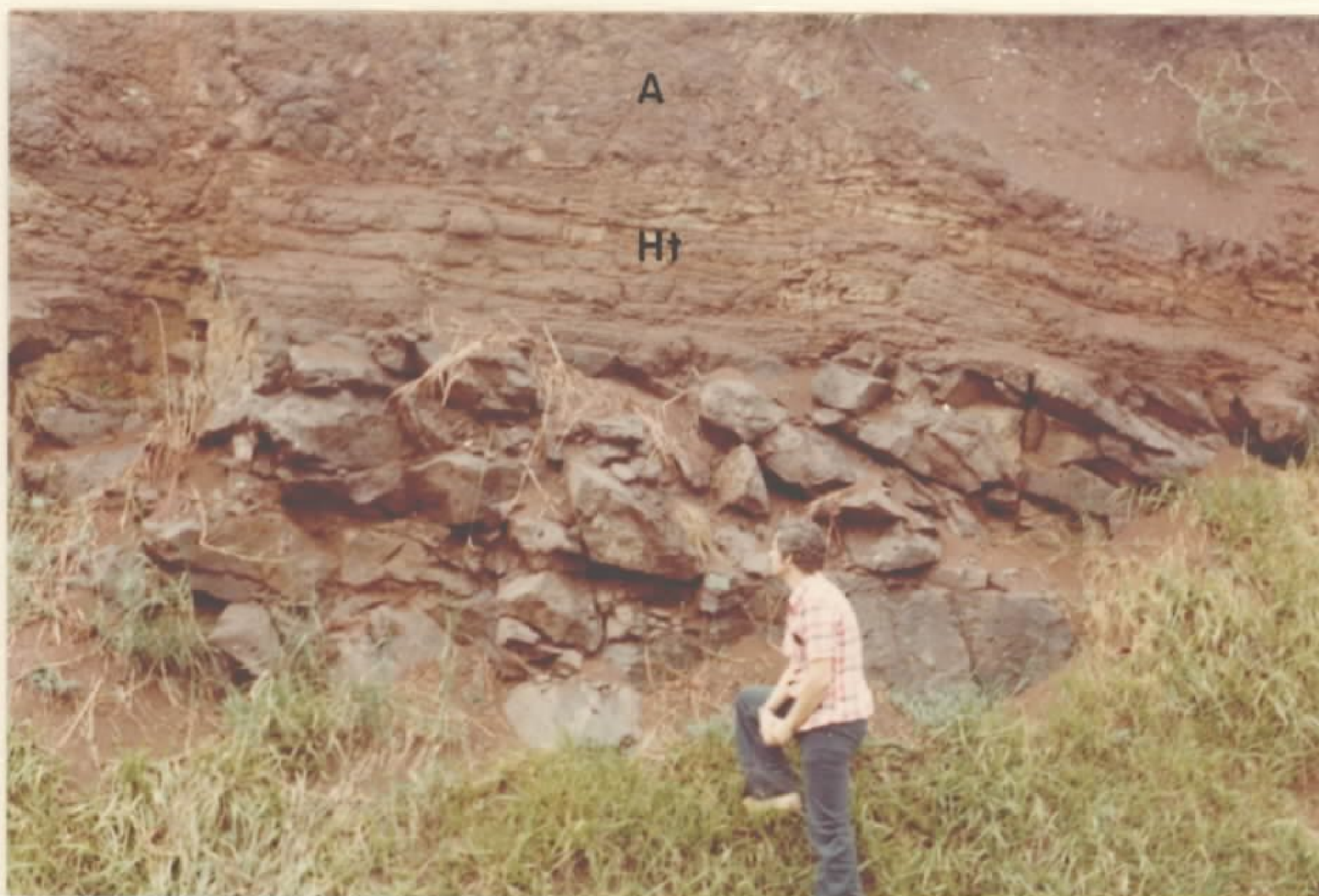
Foto 11 - Derrame basáltico com uma zona amigdalóide (A) de aspecto compacto, uma zona de diaclasamento horizontal (Ht) finamente laminada e uma zona central com fraturas irregulares. Km 410, BR-386.
