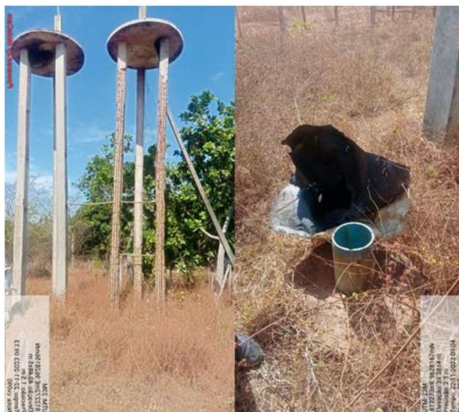
Figura 15 – Base para caixa d'água e poço desativado.
