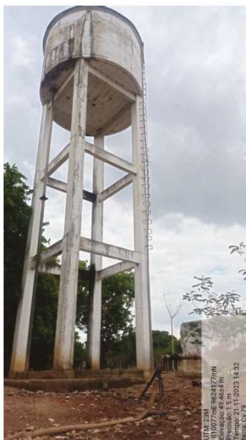
Figura 16 – Caixa d'água de alvenaria com capacidade de 10 m 3 .
