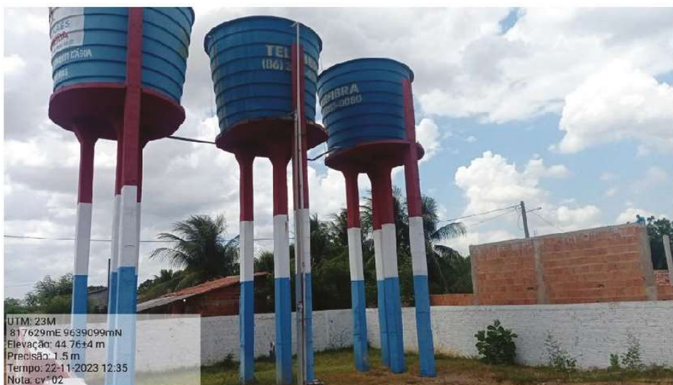
Figura 14 – Sistema de Abastecimento de Água (SAA) – Trincheira
