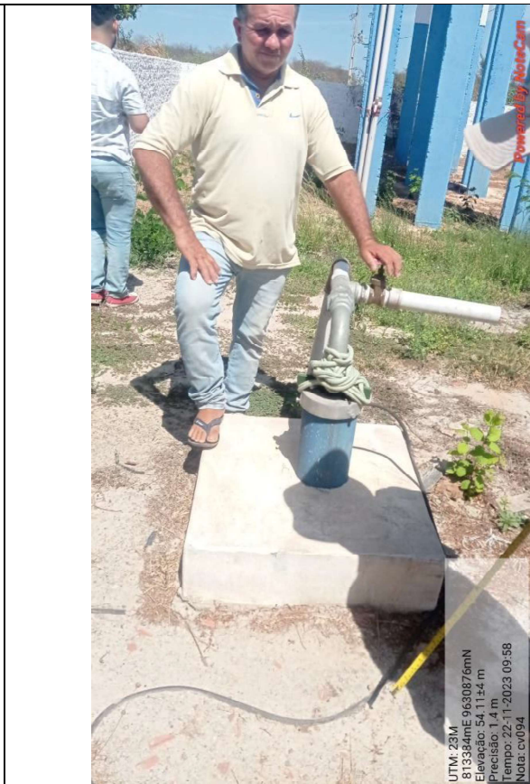
Poço CV 94 – Poço com laje de proteção e cercado adequados
