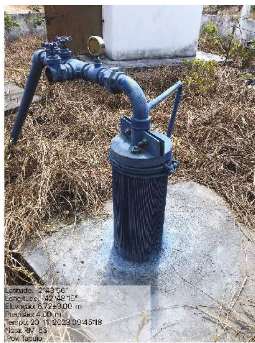
Figura 9 – Tubulação com registro para coleta d'água.
