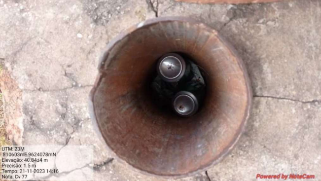
Poço CV 77 – Poço sem tampa e com sujeira dentro
