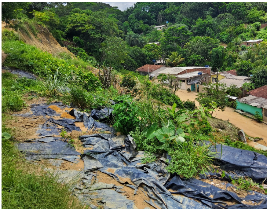
Figura 6: Situação atual da encosta que deslizou durante as chuvas de 2022.
