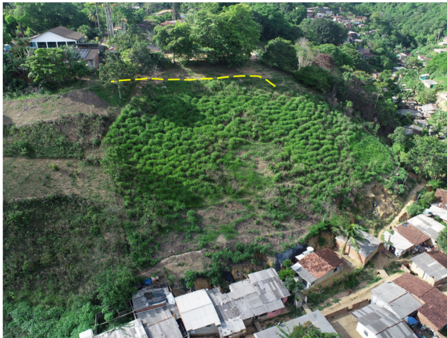
Figura 1: Visão aérea da encosta. A linha tracejada em amarelo indica a posição da trinca. Notar moradias localizadas na base da encosta.
