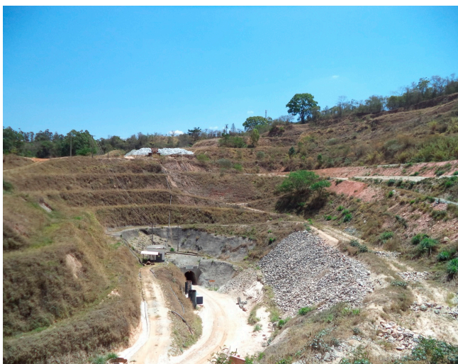
Figura 8.9 - Mina Velha (Lamil Lage Minérios). Vista da entrada para a mina subterrânea de agalmatolito. Fotos de Joanna Araújo (SGB-CPRM).
