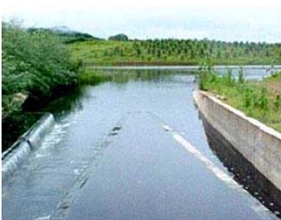
Foto 2 – Vista da Barragem de Compensação. Projeto Várzeas de Sousa
