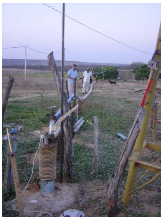
Figura 4.12 - Visão global do conjunto poço bombeado, tubo escoador de orifício circular com coluna suporte vertical contendo mangueira e escala métrica, e tubos de PVC (Arq.DSC004)
