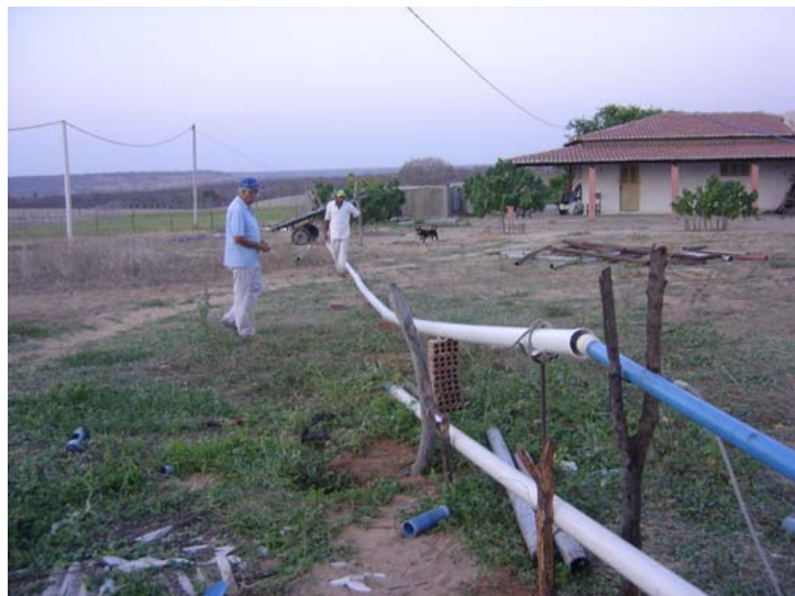
Figura 4.11 - Visão do conjunto tubo escoador de orifício circular e rede auxiliar de tubos de PVC auxiliar usada para conduzir a água que sai do tubo escoador evitando, assim, acúmulo e infiltração no local do teste(Arq. DSC0033).
