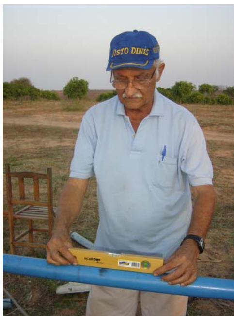
Figura 4.8 - Nivelando o tubo escoador de orifício circular (Arq. DSC0017)
