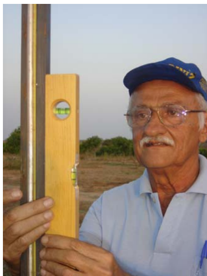
Figura 4.6 - Nivelando coluna suporte vertical contendo mangueira e a escala métrica usada para medição da carga hidráulica (Arq. DSC0012)
