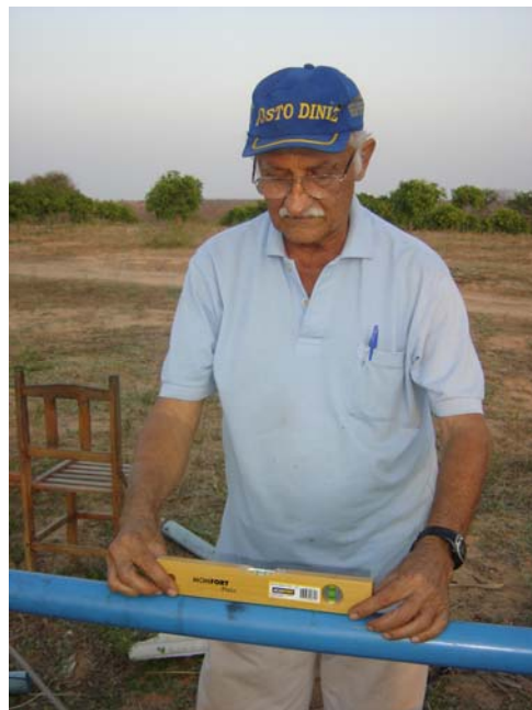
Figura 8 - Nivelando o tubo escoador de orifício circular (Arq. DSC0017)
