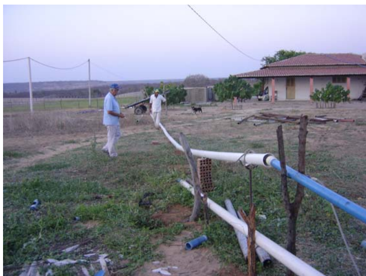
Figura 11 - Visão do conjunto tubo escoador de orifício circular e rede auxiliar de tubos de PVC auxiliar usada para conduzir a água que sai do tubo escoador evitando, assim, acúmulo e infiltração no local do teste(Arq. DSC0033).
