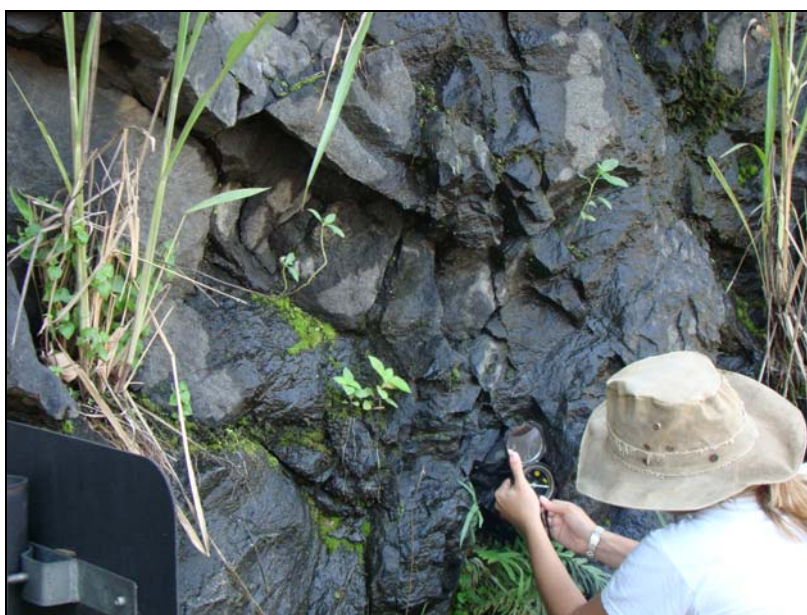
Figura V.5.52 – Fraturamento com presença de umidade e gotejamento.
