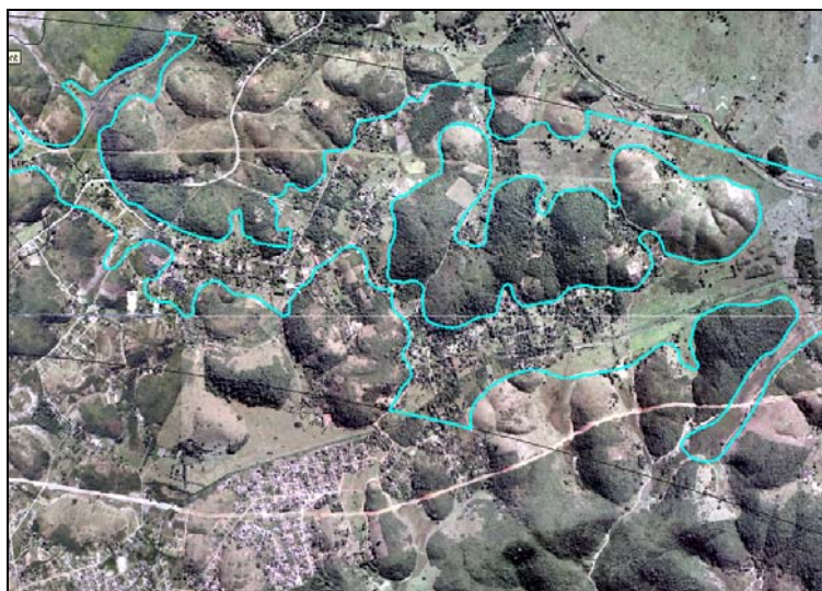
Figura V.5.9 - Vista geral da Unidade Geotécnica Alúvio-Colúvio.
