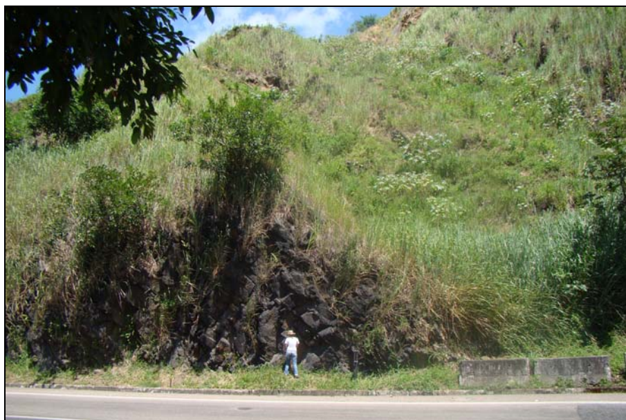
Figura V.5.50 – Afloramento de rocha levemente alterada a sã recoberto por solo residual da Ug_Sr_sa.
