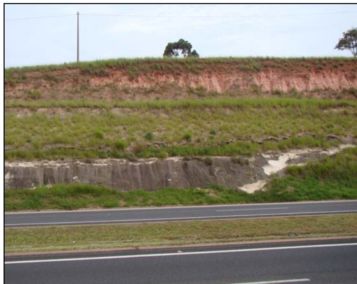
Figura V.5.18 – Lente de arenito em meio a folhelhos alterado.
