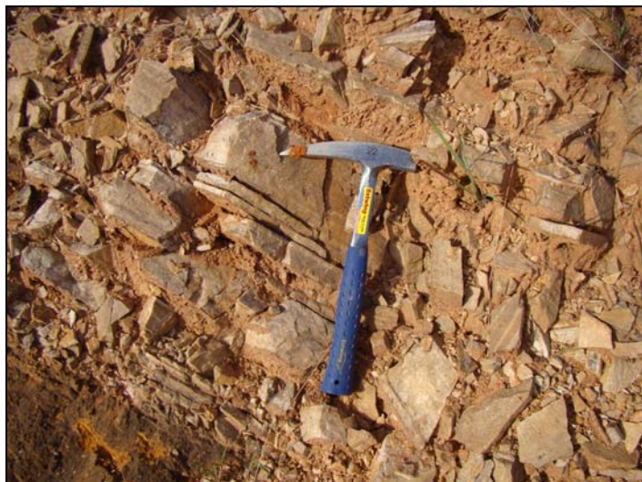
Figura V.5.44 – Aspecto muito fraturado do maciço no horizonte de rocha medianamente alterada.
