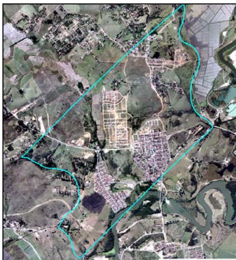
Figura V.5.21 – Vista geral da Unidade Geotécnica Solo Residual de Rocha Sedimentar - Formação Tremembé.
