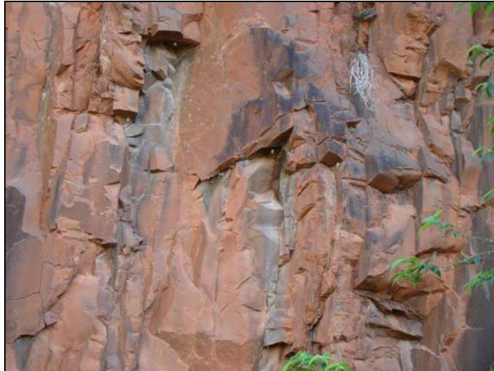
Figura V.5.32– Detalhe do fraturamento do maciço rochoso.
