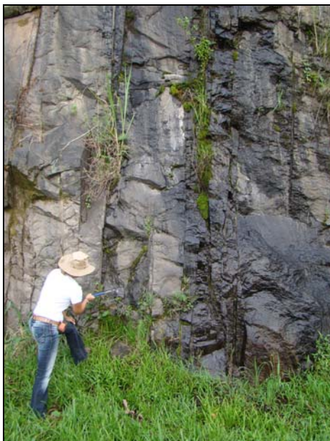
Figura V.5.53- Zona de Cisalhamento com intenso fraturamento presente na Ug_Sr_sa.
