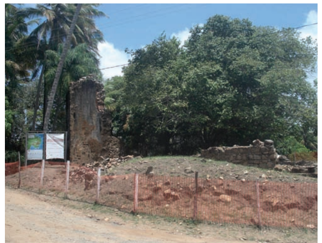
Figura 31 - Ruínas da Igreja Velha também construída com fragmentos de granito, arenito e riolito (vulcânica encontrada na região).
