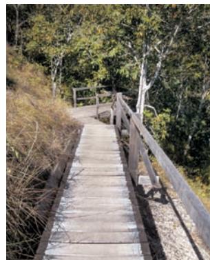
Figura 19 - Ponte de acesso às cachoeiras das Andorinhas e Independência.
