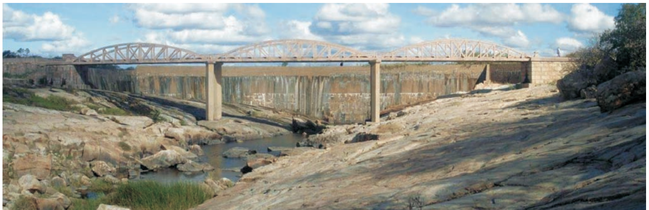
Figura 119 - Ponte da Pedra Lavrada sobre o Rio Seridó que corta granitos e pegmatitos em Jardim do Seridó.
