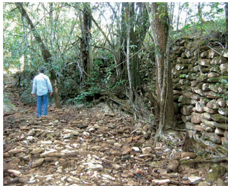
Figura 20 - Canal de desvio do rio das Almas. Final.
