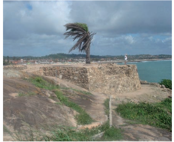
Figura 21 - Visão traseira do referido forte. Notar que o mesmo foi erguido sobre o Granito do Cabo
