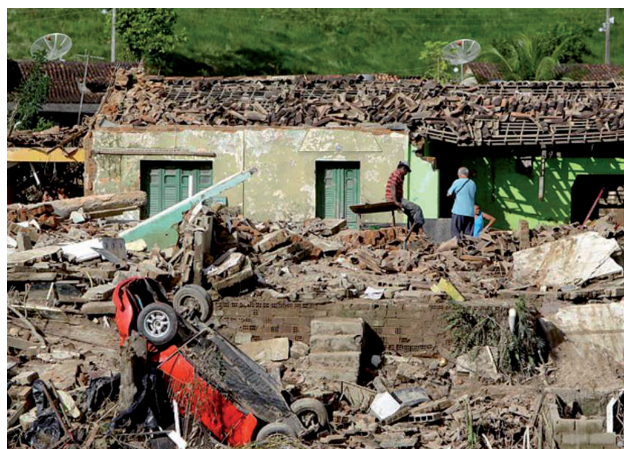
Figura 1.11 - Detalhe da destruição de casas na cidade de Quebrangulo, em função de enchentes ocorridas no ano de 2010, com destaque para o nível que a água do rio Paraíba atingiu nesse evento. Fonte: < http://www.defesacivil.al.gov.br >.
