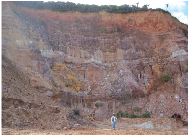
Figura 1.5 - Corte de beira de estrada em afloramento do Grupo Barreiras, com desenvolvimento de processos erosivos formando sulcos e ravinas, tornando o material suscetível ao deslizamento nas proximidades da cidade de Barra de São Miguel-AL. Fotografia: Tereza Bittencourt Villanueva (2011).
