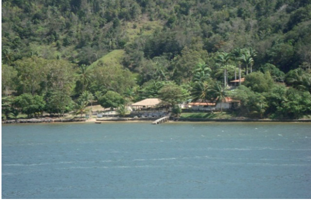
Figura 6.9 - Habitações sujeitas a inundações às margens da lagoa de Manguaba-AL. Fotografia: Violeta de Souza Martins (2011).
