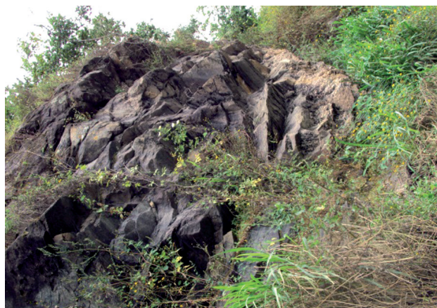
Figura 6.92 - Detalhe dos granitos-gnaisses, propensos à desestabilização, após a cidade de Maribondo, no mesmo corte de estrada às margens da BR-316 (AL). Fotografia: Violeta de Souza Martins (2011).
