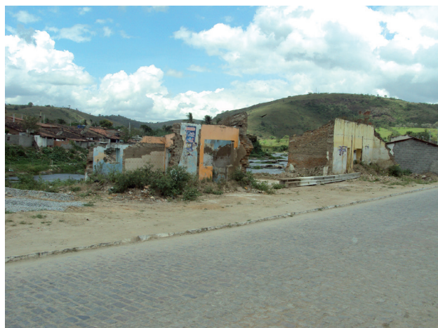
Figura 1.10 - Destruições ocasionadas pela inundação do rio Paraíba em 2010, na cidade de Quebrangulo-AL. Fotografia: Tereza Bittencourt Villanueva (2011).
