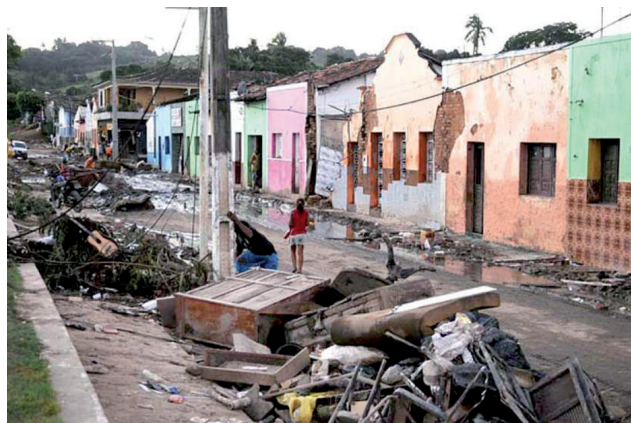
Figura 1.9 - Ruptura de barragem no rio Mundaú, decorrente de enchentes ocorridas no ano de 2010. Fonte: < http://www.defesacivil.al.gov.br >.
