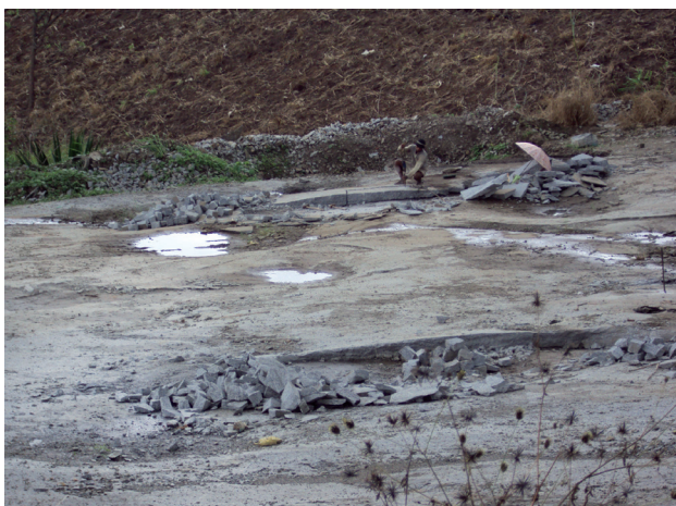
Figura 1.4 - Pedreira para extração de granito isotrópico para uso na construção civil como brita e paralelepípedos, nas proximidades da cidade de Matriz de Camaragibe-AL. Fotografia: Tereza Bittencourt Villanueva (2011).
