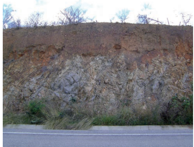
Figura 5.61 – Solo residual em corte de estrada expondo os filitos da formação Rio Gavião (rodovia BA-026, região de Iramaia, BA).
