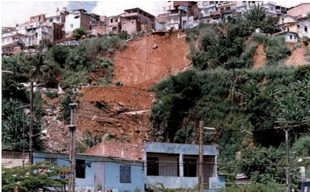
Figura 5.81 – Deslizamento ocorrido em 1992 (bairro do Lobato, Salvador, BA). Fonte: CODESAL (2004).
