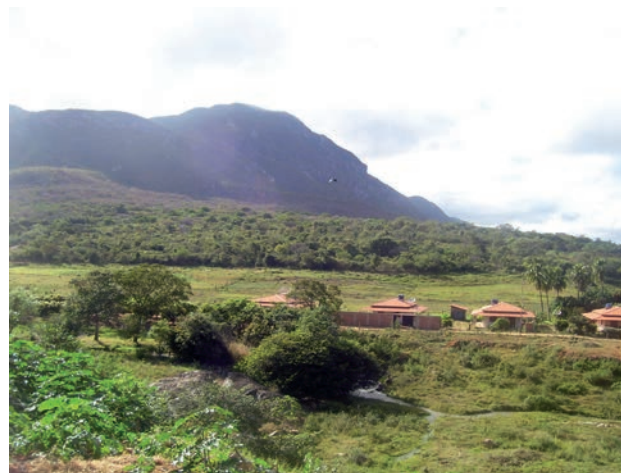
Figura 5.4 – Construções residenciais ocupando áreas de terraço aluvionar.
