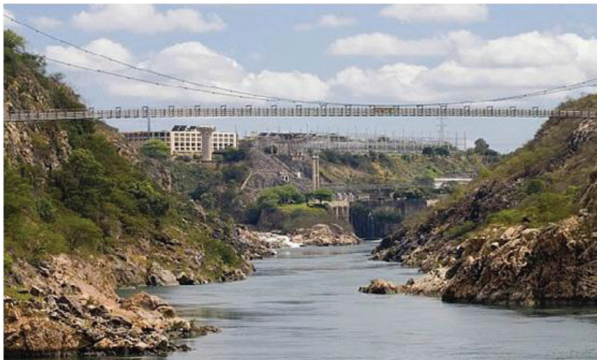
Figura 6.46 - Hidrelétrica da CHESF, rio São Francisco (Paulo Afonso, BA (G 41 )).
