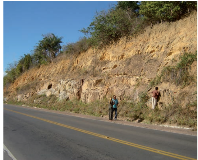
Figura 5.75 – Talude em corte de estrada (BR-242, Itaberaba, BA).
