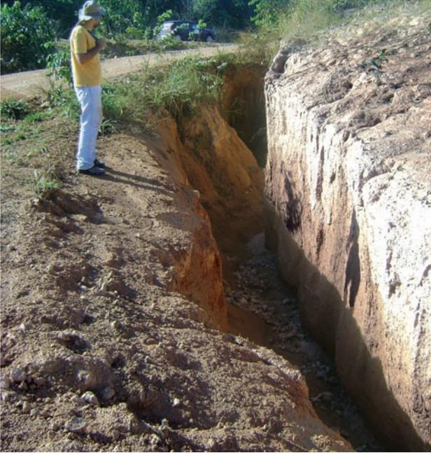
**Figura 3.57:** Processo avançado de erosão em calha de estrada, sobre solo arenoso e saprólito granito-gnáissico (granito São Romão), induzido por zona de cisalhamento (domínio DCGR3).
