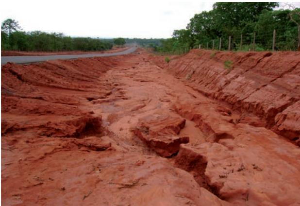
**Figura 4.77** - Área de relevo aplainado a suave ondulado sobre a unidade DSVMPasaf (intercalações de sedimentos arenosos, siltico-argilosos e folhelhos), no caso, constituída por sedimentos arenosos e friáveis da formação Aquidauana, em que se observa intensa erosão em sulcos na rodovia MS-080 induzida pela retirada de material de empréstimo de suas laterais para compor o aterro da rodovia (Rio Negro, MS).
