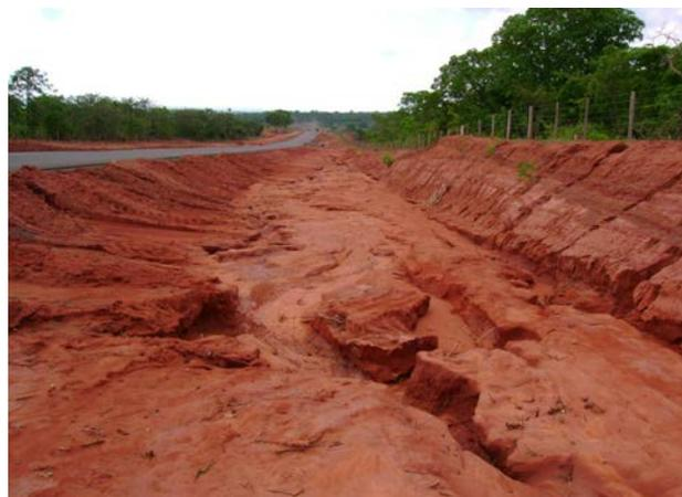
**Figura 1.5** - Erosão induzida pela exposição à concentração das águas das chuvas em solos arenosos em uma rodovia em construção e com o pavimento já comprometido pelos processos erosivos (Estrada Campo Grande/Rio Negro).
