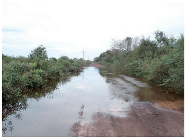
**Figura 4.10** - Estrada Parque Pantanal Sul, construída sobre aterro em terrenos da unidade DCfl (planícies fluviolacustres), com trechos alagados por longos períodos pelas enchentes do rio Paraguai, impedindo a trafegabilidade (Ladário, MS).
