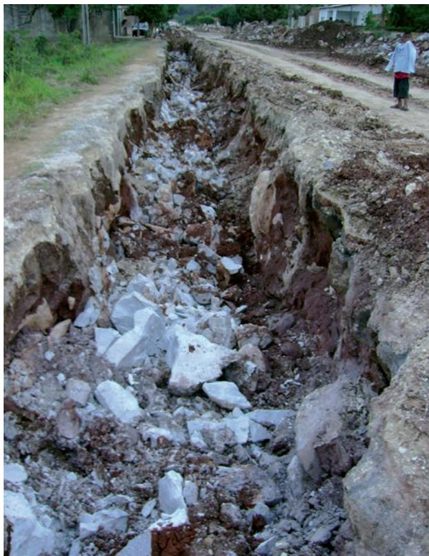
**Figura 4.152** - Escavações para implantação de obras enterradas na cidade de Corumbá. Apesar de o relevo ser aplainado, onde se espera solo profundo, o substrato rochoso constituído por calcário aflora ou situa-se a baixas profundidades (unidade DSP1 csaa, no caso, calcários da formação Bocaina).
