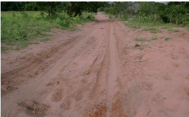
**Figura 4.50** - Aspecto das estradas em área em processo de arenização sobre a unidade DSVMpa (predomínio de sedimentos arenosos malselecionados), nesse caso, correspondente à formação Furnas, onde o relevo é de colinas amplas e suaves; nesse local, o processo de arenização parece ser natural, consequência da lixiviação pelas águas das chuvas (localidade de Jacobina, Corguinho, MS).
