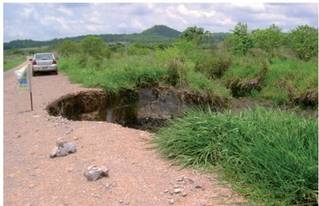
**Figura 4.148** - Desmoronamento na superfície devido à existência de cavidades na unidade DSP1csaa, no caso, correspondente aos calcários da formação Bocaina (Bonito, MS).
