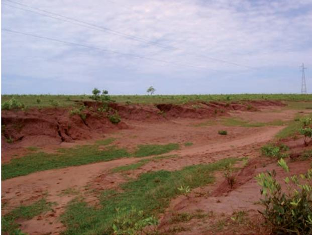
**Figura 5.3** - Cavas abertas na lateral da rodovia BR-060, em trecho que corta sedimentos arenosos da formação Caiuá, expondo-os à erosão (Bandeirantes, MS).
