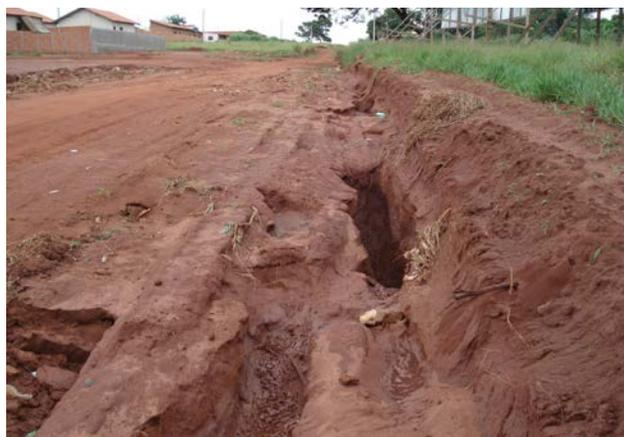
**Figura 1.4** - Focos erosivos em um arruamento concordante com o declive de um terreno arenoso (Bataguassu, MS).
