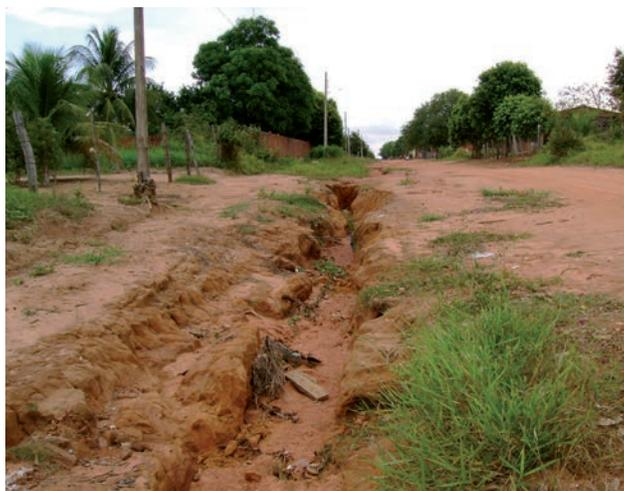
**Figura 4.73** - Erosão em sulco em ruas não-dotadas de obras pluviais e de calçamento, onde afloram sedimentos arenosos da unidade DSVMPasaf (intercalações de sedimentos arenosos, siltico-argilosos e folhelhos), no caso, da formação Aquidauana, bastante suscetíveis à erosão (Aquidauana, MS).
