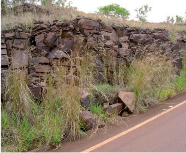
**Figura 4.105** - Área de relevo acidentado (rebordo erosivo), com solo raso ou inexistente, com basaltos intensamente fraturados e sujeitos à queda de blocos expostos em talude de corte de estrada (Maracaju, MS).
