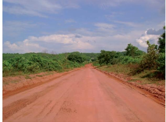
**Figura 4.78** - Exemplo de outro trecho da rodovia MS-080 sobre a unidade DSVMPasaf e com o mesmo tipo de relevo, porém, construída sem aterros, consequentemente, sem escavações nas laterais, onde se preservou a vegetação natural ao longo da estrada (Corguinho, MS).
