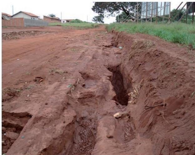
**Figura 4.54** - Erosão em sulco em ruas sem pavimentação e sem obras de drenagens de um loteamento implantado sobre a unidade DSVMPaef (predomínio de espessos pacotes de arenitos de deposição mista), no caso, do grupo Caiuá (Bataguassu, MS).
