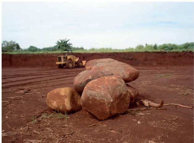
**Figura 4.110** - Terraplenagem em área de relevo aplainado e de solo profundo, onde foram encontrados imensos matacões de rocha dura imersos no solo (Dourados, MS).
