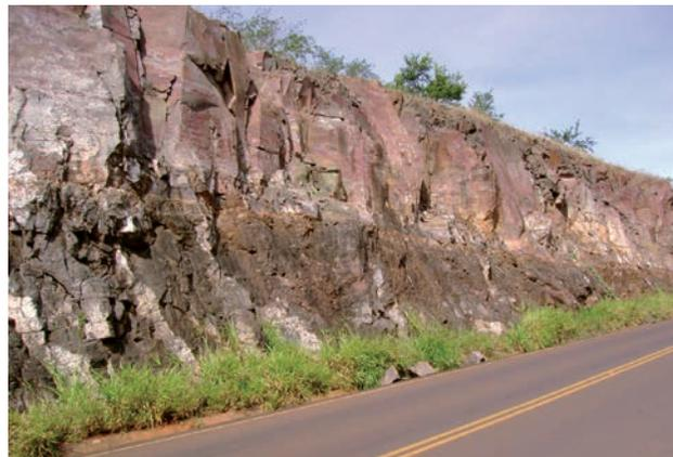
**Figura 4.104** - Sucessão de derrames de rochas vulcânicas de diferentes composições e texturas aflorando em talude de corte de estrada em área de relevo de rebordo erosivo. Na porção basal ocorrem basaltos vesiculados, com vesículas preenchidas principalmente por calcita; sobre eles ocorre basalto densamente fraturado, maciço, sobreposto por um derrame aparentemente de riolito ou andesito (Campo Grande, MS).
